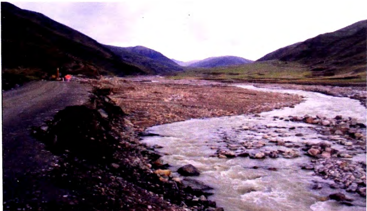
Foto N° 2.4 Vista hacia progresivas arriba a la altura del Km 92+650, donde la carretera está expuesta a la erosión del río Mapacho.
