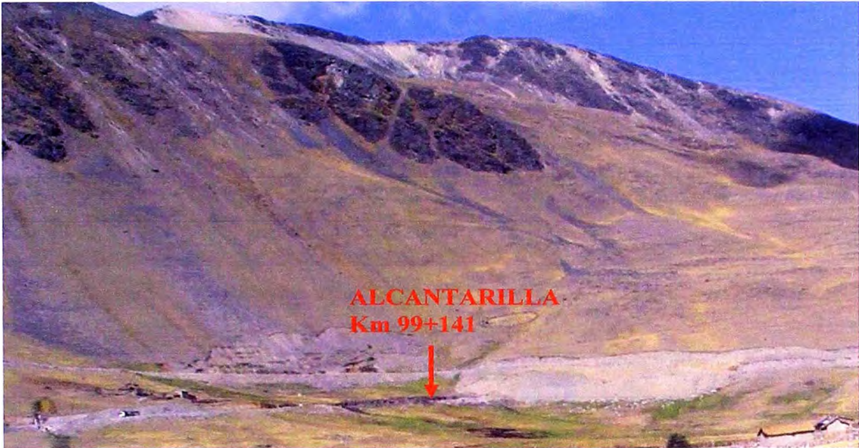
Foto N° 2.8 Tramo final del estudio, que según el proyecto de Ingeniería de Detalle la ubicación de la alcantarilla es considerada en el Km 99+141.
