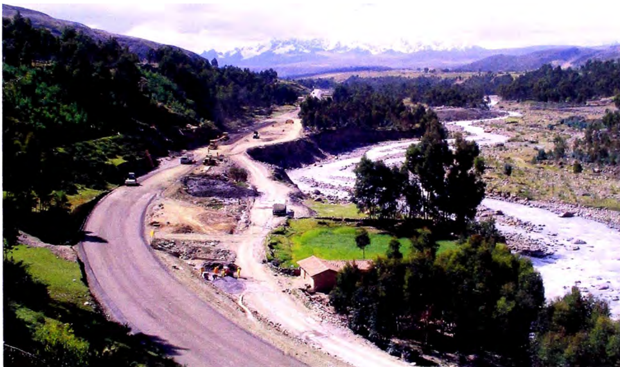
Foto N° 3. Zona del Km 77, vista hacia progresivas arriba de la carretera, que lateralmente sigue a lo largo del cauce del río Mapacho.
