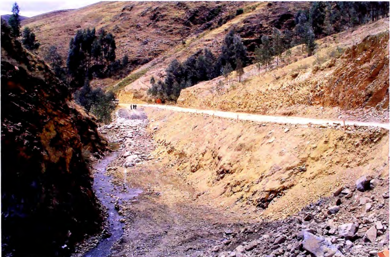
Foto N° 2.3 Vista hacia progresivas arriba a la altura del Km 69, donde la carretera sigue al borde del cauce encañonado del río Mayotinco.
