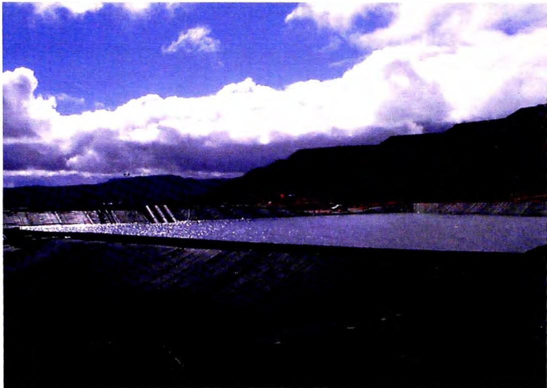
Foto N°19: Vista en dirección nor-oeste. Pozas de Procesos.
