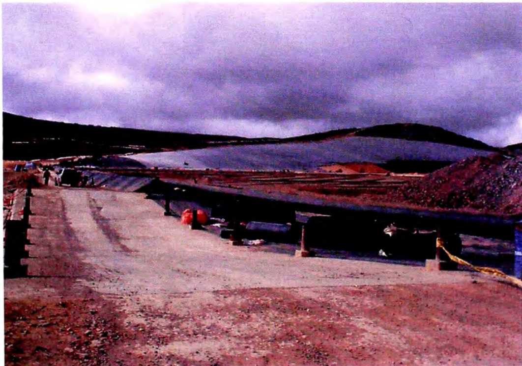
Foto N°20: Vista en dirección nor-este. Vertedero de concreto de la Plataforma de Lixiviación.
