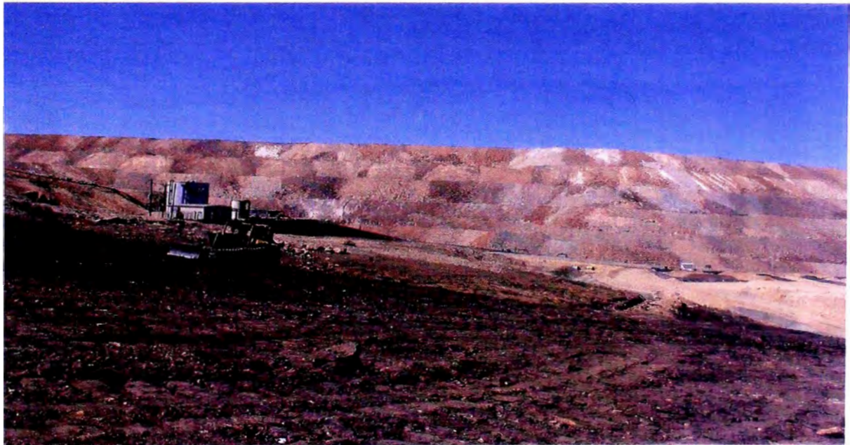
Foto N°02: Conformación del Botadero de material orgánico (parte baja – lado este de la plataforma de lixiviación).
