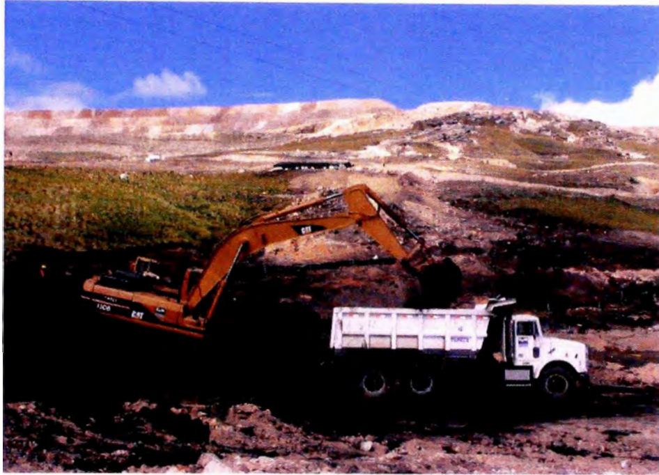
Foto N°01: Excavación de material orgánico en el Canal de Solución.
