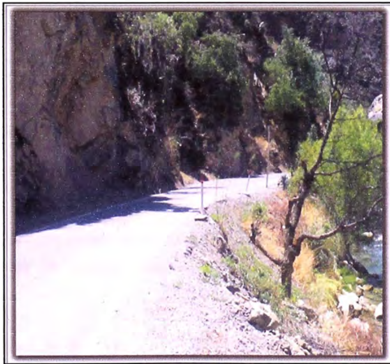
Figura N°1.02 Tramo común de carretera
