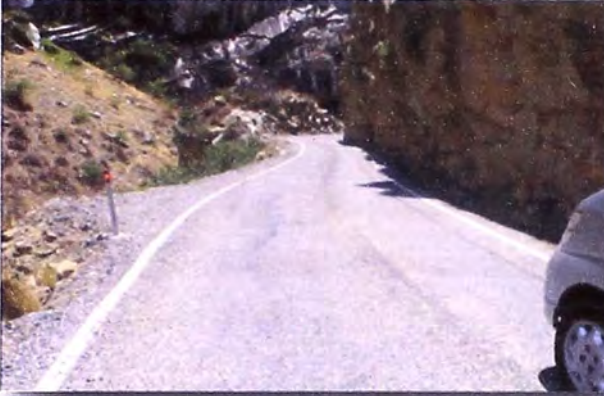
Figura N° 3.05 Desintegración
