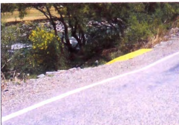
Figura N° 3.03 Hundimientos
