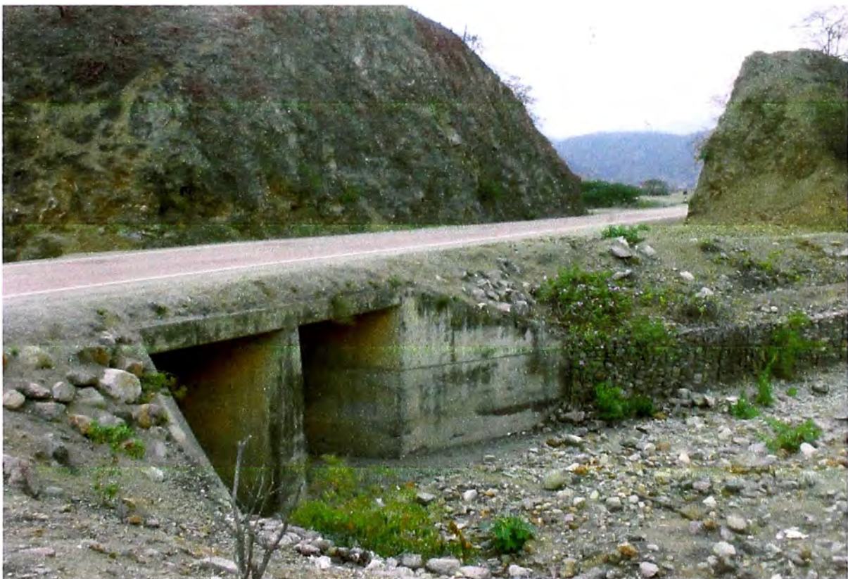
Km 10 Vista de pontón
