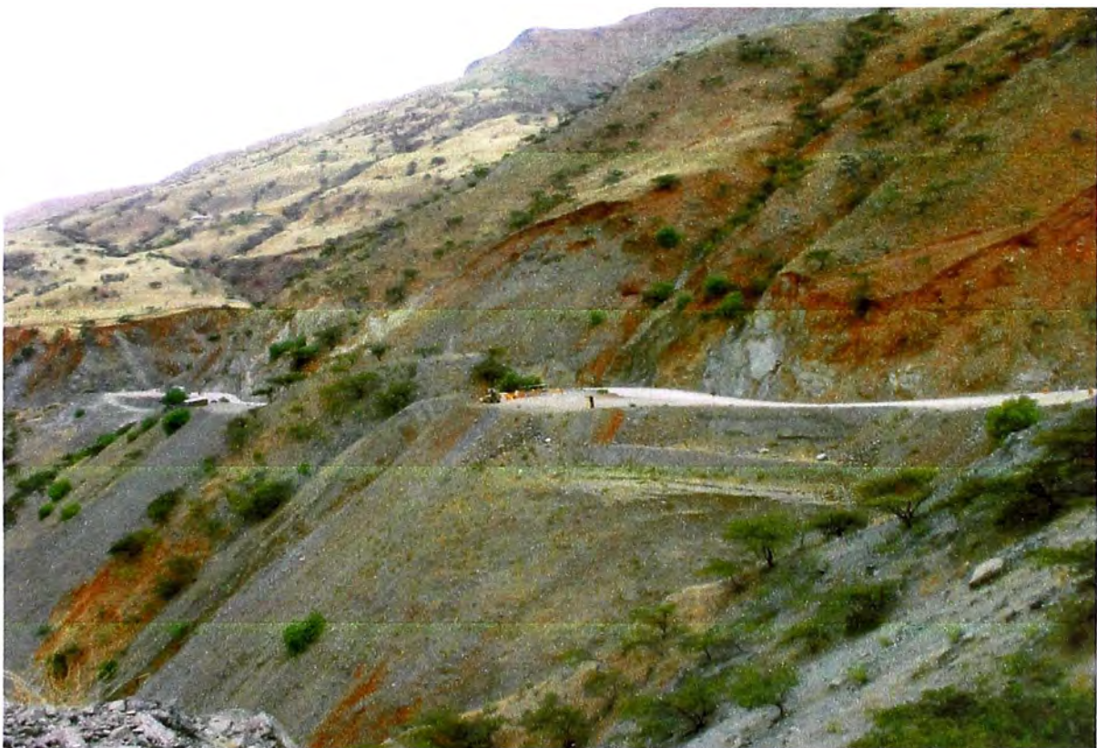
Km 50 Vista hacia adelante en carretera OCQRN
