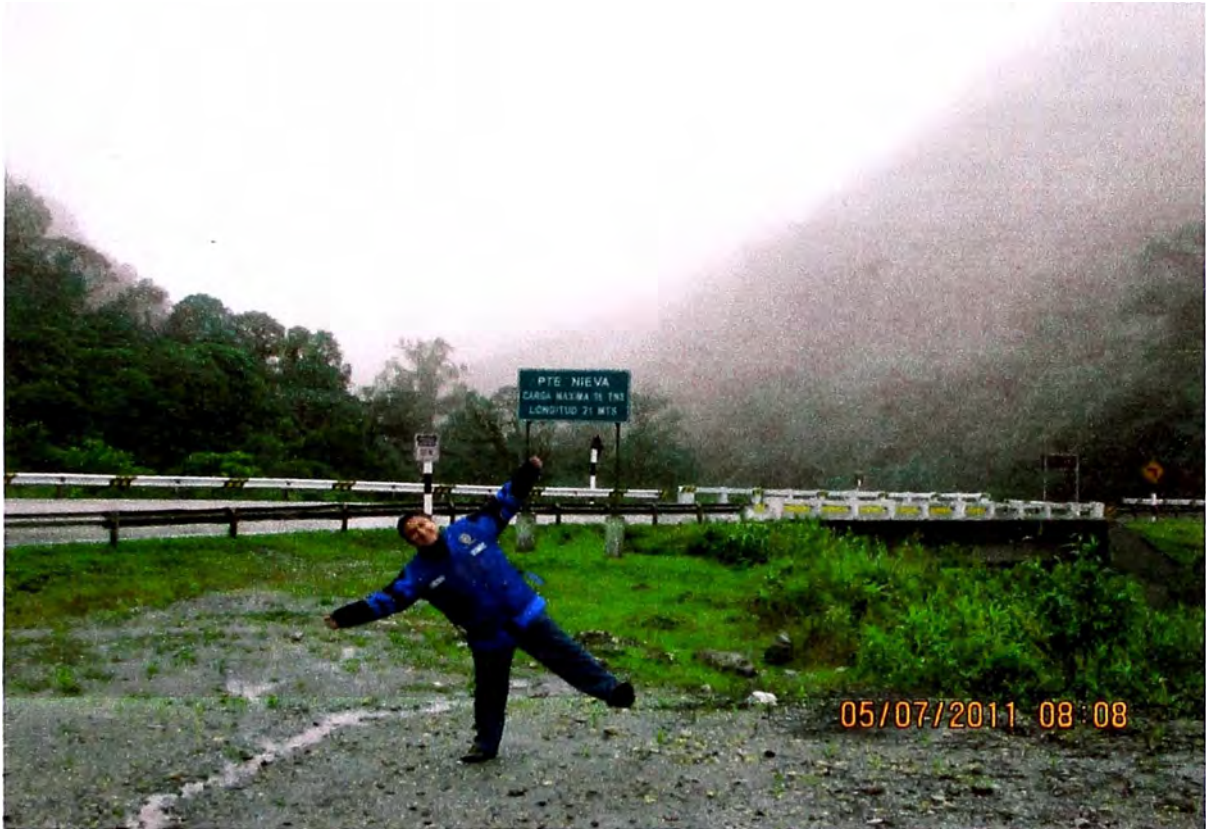
Km 370.3 Vista del puente Nieva
