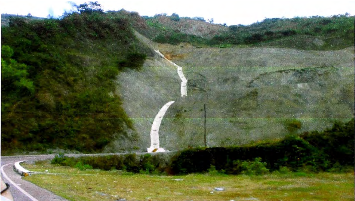
Km 40 Vista de obra de arte, encauzamiento de quebrada
