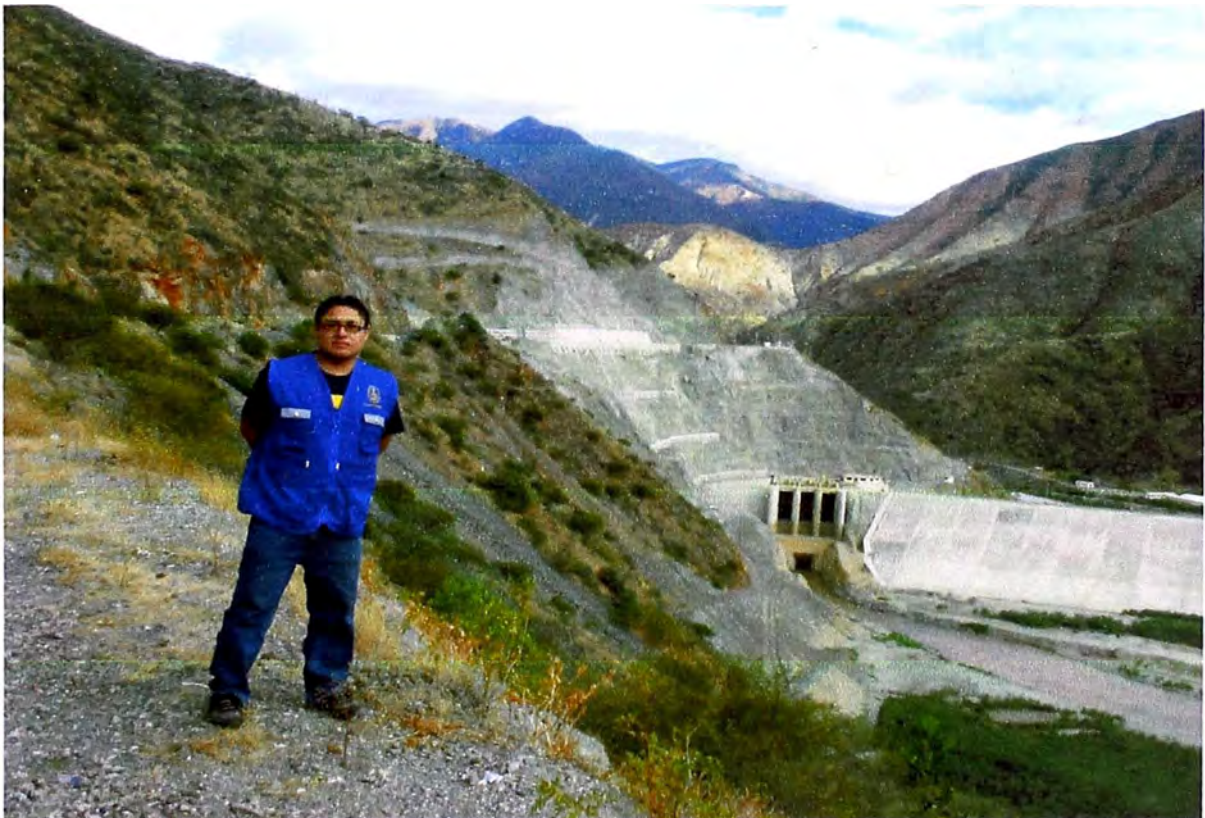
Km 86 Vista desde aguas arriba de la presa Limón
