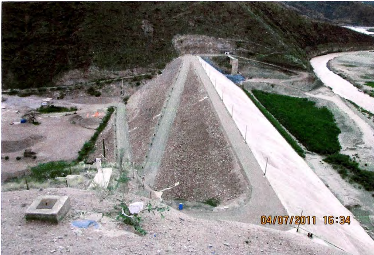
Vista desde estribo izquierdo de la presa Limón
