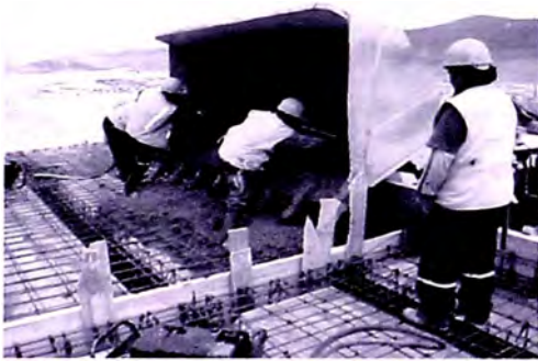
Foto 4.19: Vaciado del Techo de la Vivienda de Operadores
