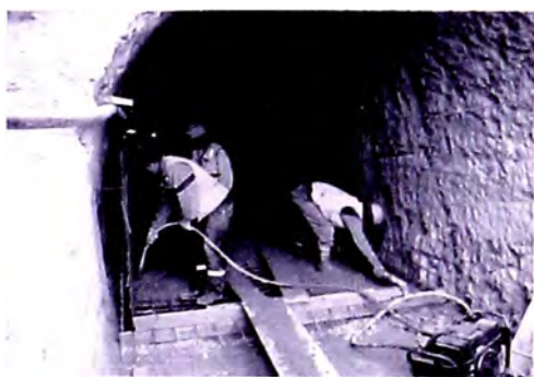
Foto N° 4.05: Vaciado de Concreto f'c=245 kg/cm 2
