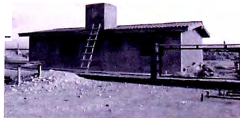
Foto 4.20: Vista del exterior de la Vivienda
