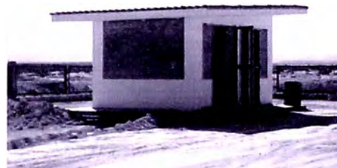
Foto N° 4.21: Vista del exterior de Caseta de Grupo
