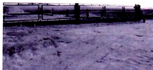
Foto N° 4.23: Colocación del Cerco Perimétrico
