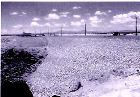
Foto N° 4.31: Vista del Cuerpo de Presa
