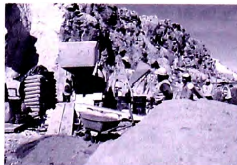
Foto N° 4.04: Preparación de Concreto
