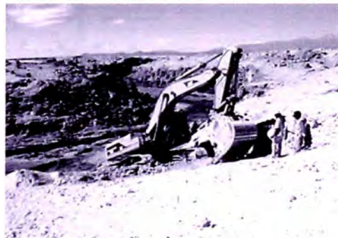
Foto N° 4.10: Excavación en la rápida de Descarga
