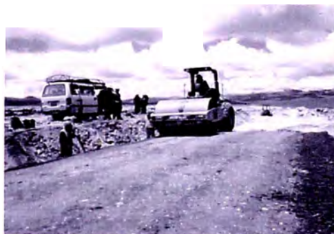
Foto N° 4.37: Trabajo de Compactación en el Tramo de Prueba.
