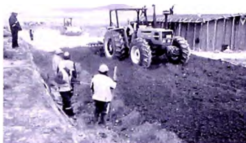
Foto N° 4.36: Mezcla con tractor agrícola en el Tramo de Prueba.
