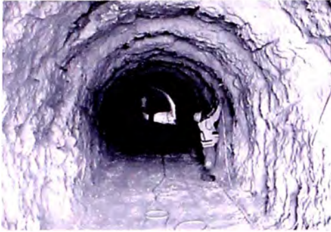
Foto N° 4.02: Trabajos de Excavación en el Túnel de Desvío
