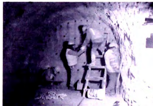
Foto N° 4.03: Colocación de explosivos en la malla para voladura en el Túnel
