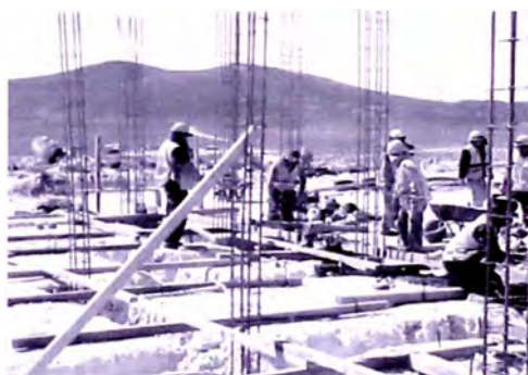
Foto N° 4.16: Trabajos en la Cimentación de la Vivienda de Operadores
