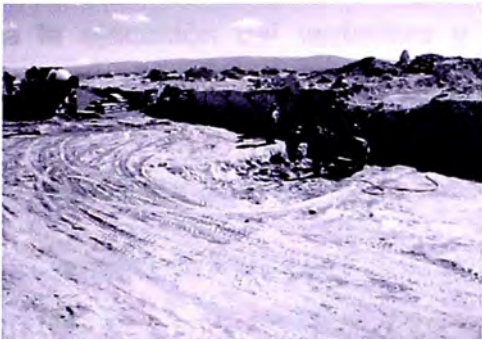
Foto N° 4.09: Excavación en el Vertedero
