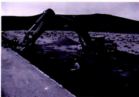
Foto N° 4.15: Corte del Núcleo del Dique
