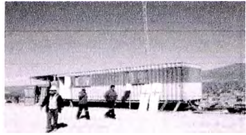
Foto N° 3.05: Almacén a pie de Obra
