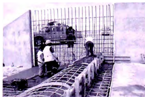
Foto N° 4.12: Vaciado de Concreto en el Vertedero
