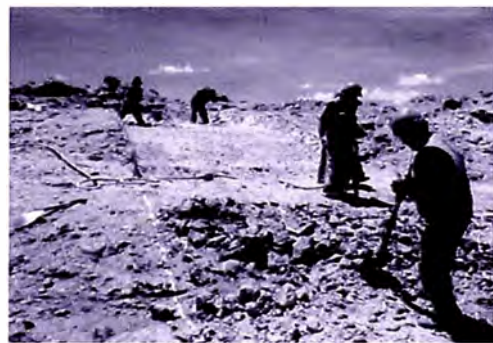
Foto N° 4.25: Trabajos de Excavación en el Cuerpo de Presa
