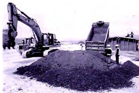
Foto N° 4.34: Colocación de los materiales para el tramo de Prueba ubicado donde actualmente se localiza el Grupo Electrógeno
