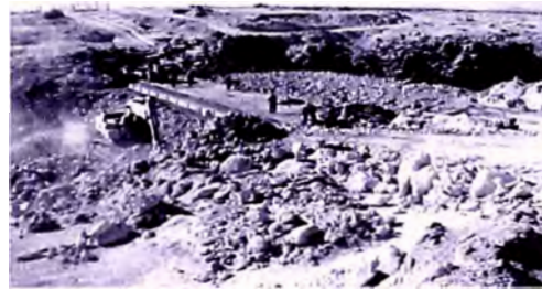
Foto N° 4.28: Colocación de puntos de nivelación para el Relleno Impermeable
