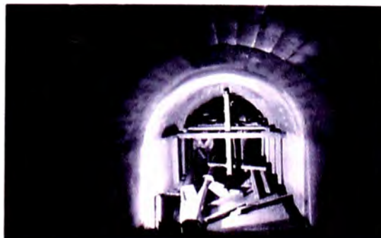
Foto N° 4.06: Vaciado de Concreto f'c=245 kg/cm 2 en la parte superior de la sección del Túnel de Desvío
