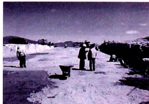
Foto N° 4.11: Aplicación de Lechada de Cemento
