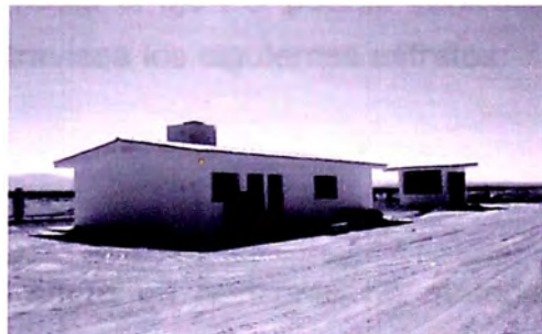
Foto N° 4.22: Vista Panorámica de la Vivienda y Caseta del Grupo Electrógeno
