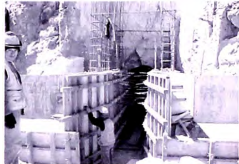
Foto N° 4.07: Trabajos de Encofrado en la Torre de Control
