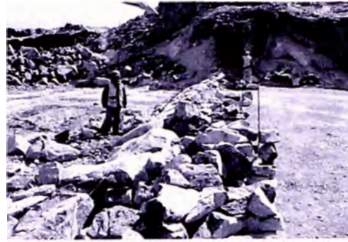
Foto N° 4.27: Acabado del Enrocado en los exteriores del Cuerpo de Presa
