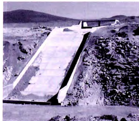
Foto N° 4.13: Vista panorámica del Aliviadero de Demasías (Vertedero)
