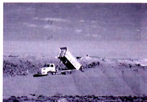
Foto N° 4.26: Almacenamiento previo para el Cuerpo de Presa
