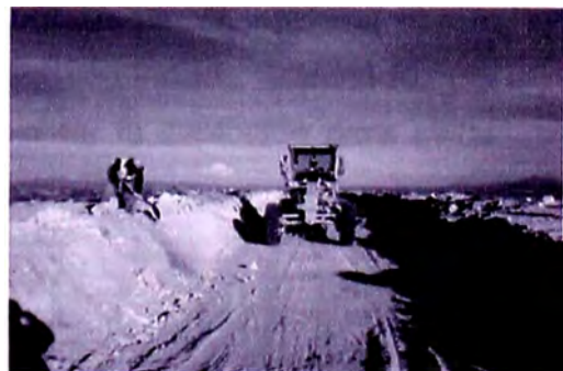
Foto N° 4.01: Trabajos de Nivelación de la Sub-rasante en el Acceso
