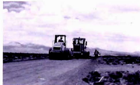
Foto N° 4.14: Relleno del Núcleo del Dique Lateral
