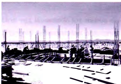
Foto N° 4.17: Trabajos Albañilería en la Vivienda de Operadores
