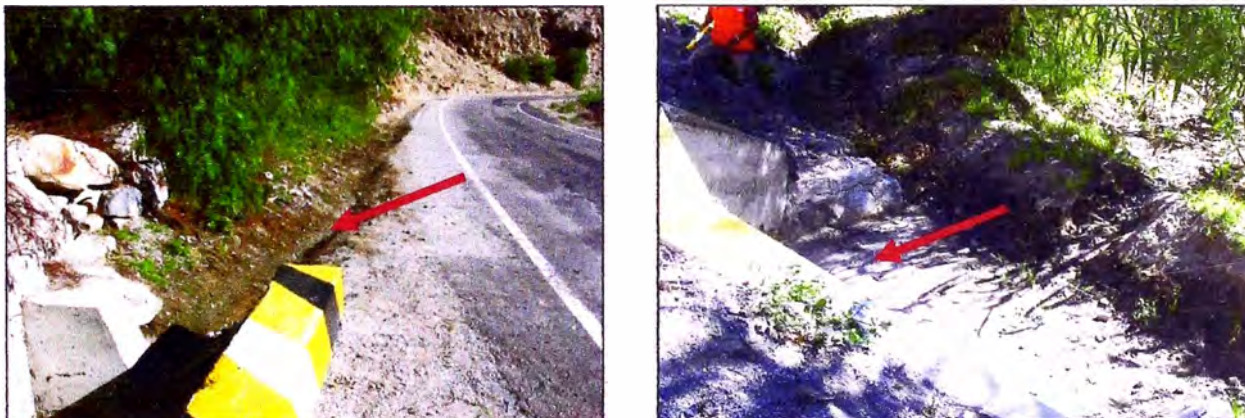
Figura N°1.06 Cuneta de tierra y descarga de alcantarilla con piedra emboquillada
