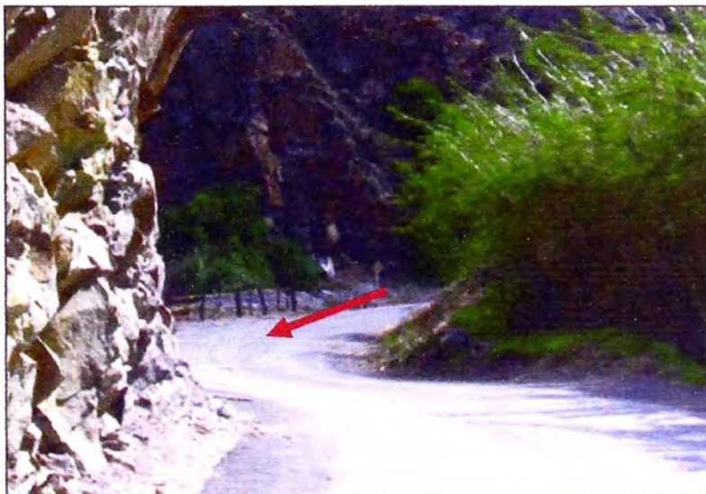
Figura N°1.03 Giba del Km.104+105
