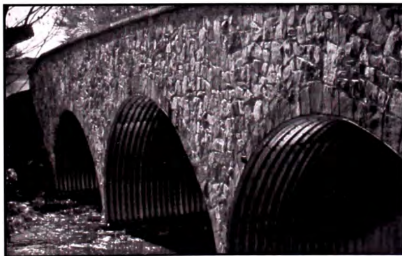
Figura N° 2.13 Alcantarilla en arco de TMC.
