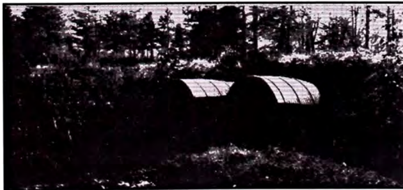
Figura N° 3.2 Alcantarilla corrugada con proyección de su salida, cuyo cuerpo está recubierto por material de la zona.
