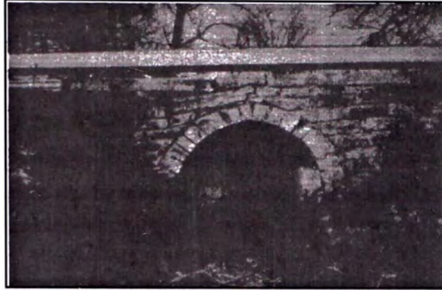
Figura N° 2.12 Alcantarilla rígida de mampostería.
