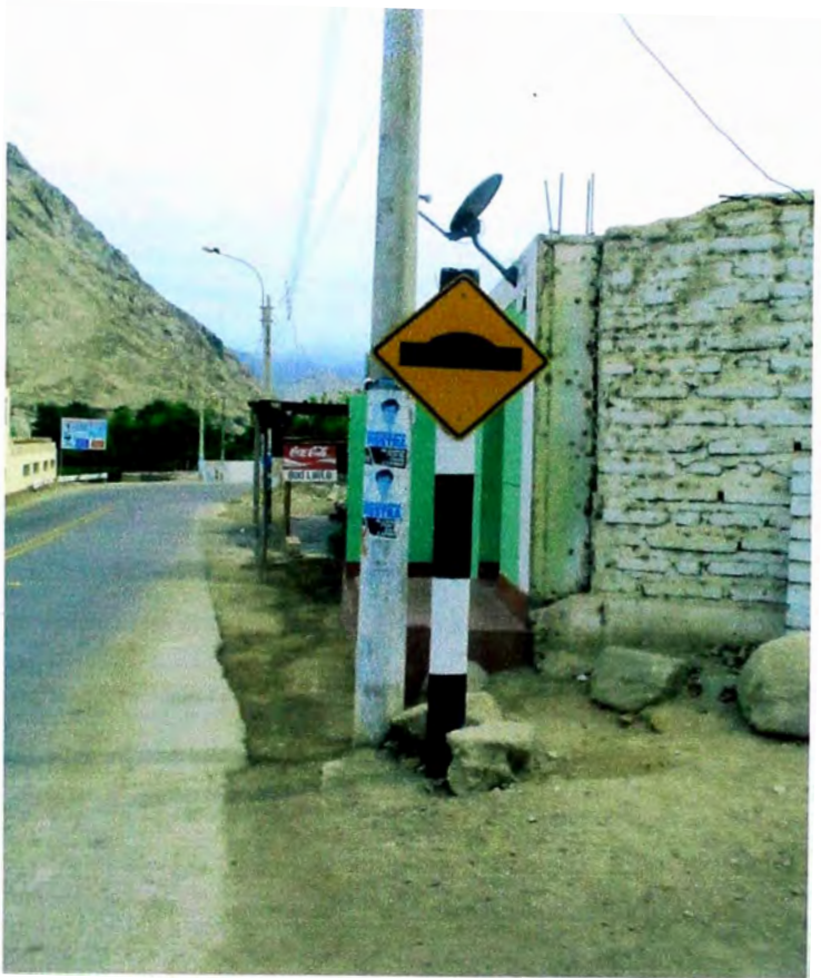
Señal Preventiva P-33, ubicada en la progresiva 33+260
