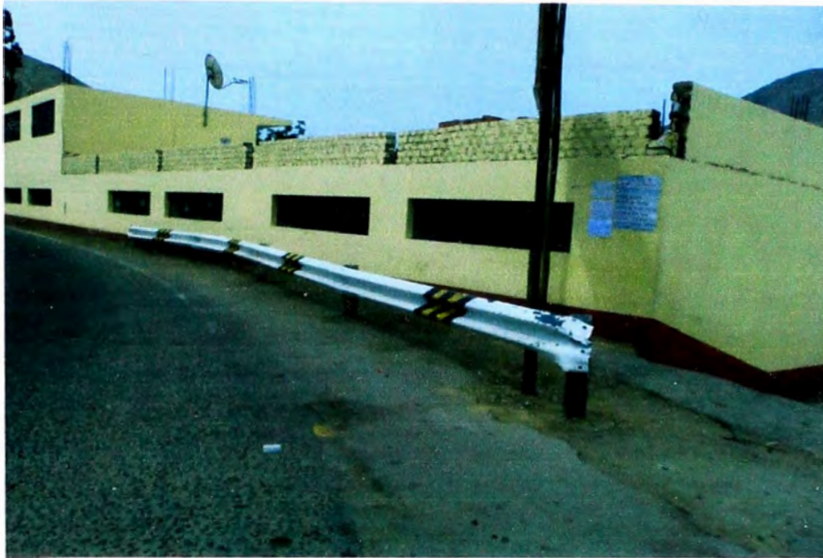
Guardavías, ubicada en la progresiva 33+309 al 33+322
