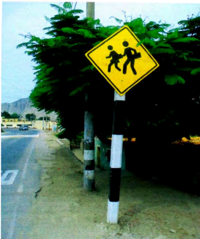
Señal Preventiva P-49, ubicada en la progresiva 33+380
