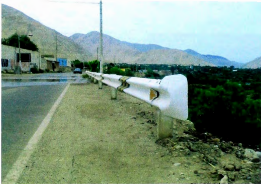
Guardavías, ubicada en la progresiva 34+144 al 34+155
