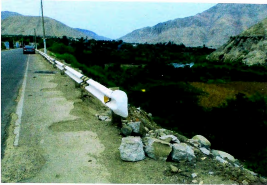
Guardavías, ubicada en la progresiva 33+782 al 33+881
