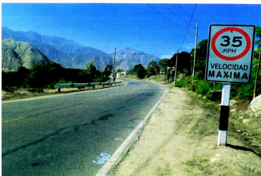
Señal Reguladora R-30, ubicada en la progresiva 34+660
