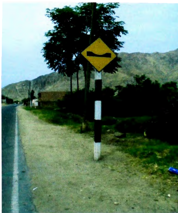
Señal Preventiva P-34, ubicada en la progresiva 33+120
