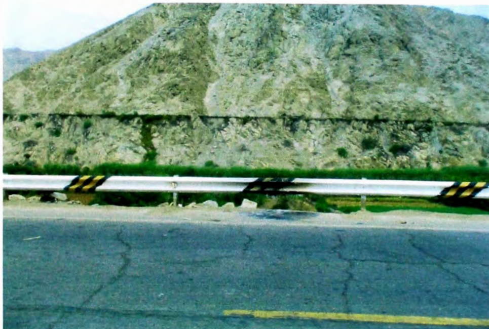
Guardavías, ubicada en la progresiva 33+716 al 33+780
