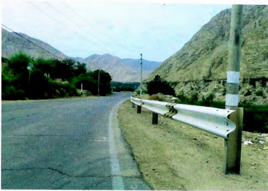
Guardavías, ubicada en la progresiva 34+398 al 34+478
