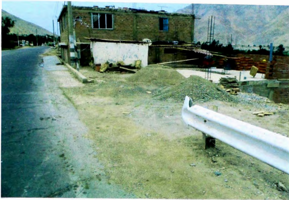
Guardavías, ubicada en la progresiva 33+660 al 33+713
