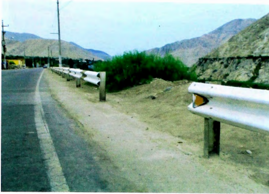
Guardavías, ubicada en la progresiva 33+978 al 34+043
