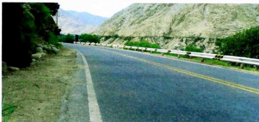
Guardavías, ubicada en la progresiva 34+219 al 34+327
