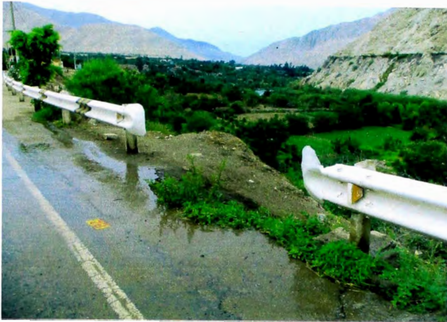
Guardavías, ubicada en la progresiva 34+126 al 34+142
