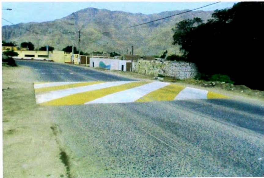
Resalto, ubicada en la progresiva 33+695 al 33+368
