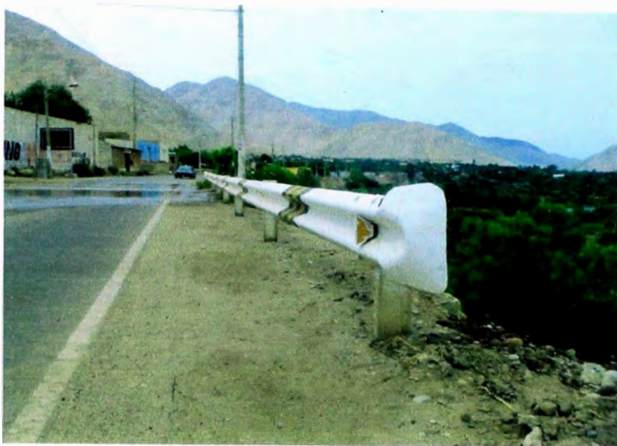
Guardavías, ubicada en la progresiva 34+184 al 34+217
