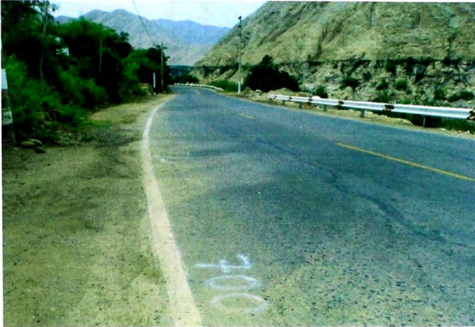
Guardavías, ubicada en la progresiva 34+671 al 34+699
