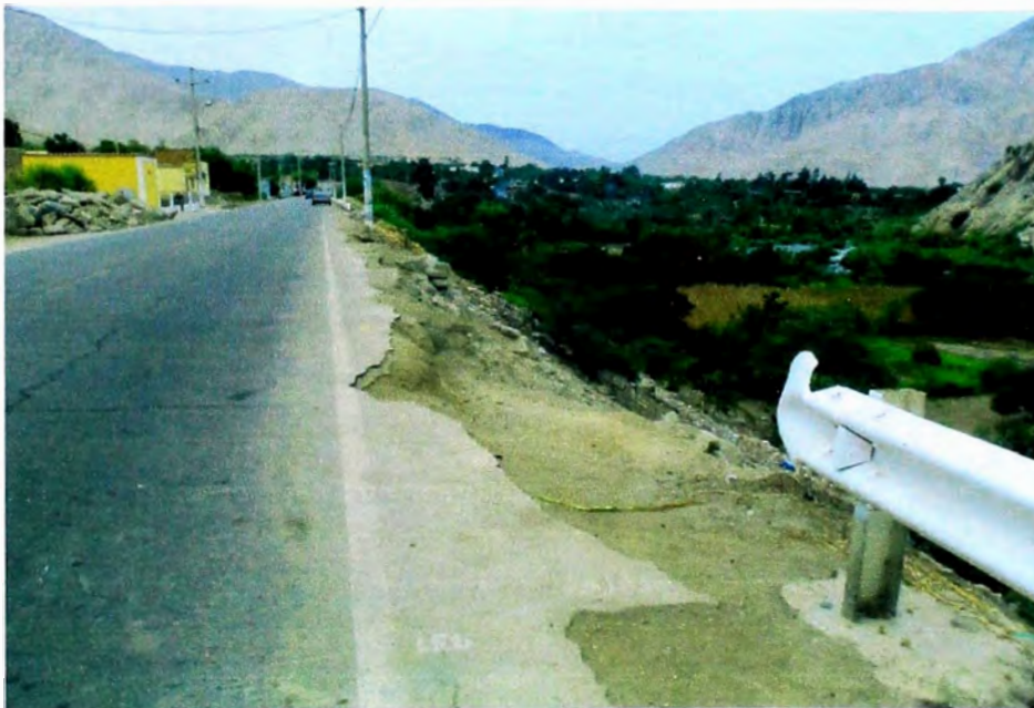
Guardavías, ubicada en la progresiva 33+928 al 33+975
