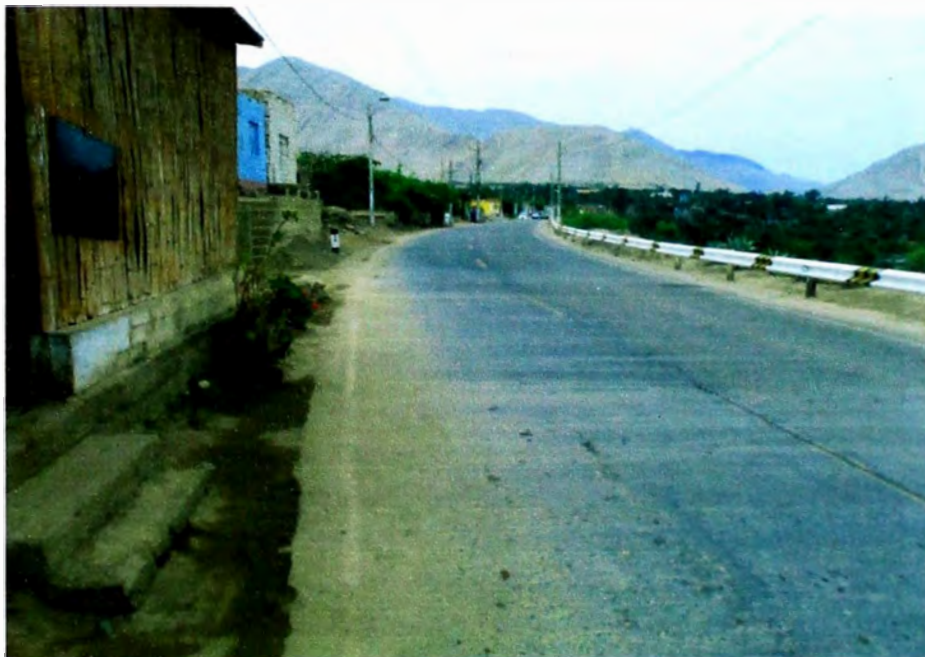
Guardavías, ubicada en la progresiva 34+046 al 34+072
