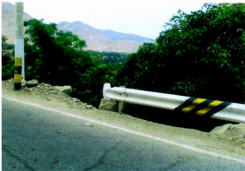
Guardavías, ubicada en la progresiva 34+574 al 34+636
