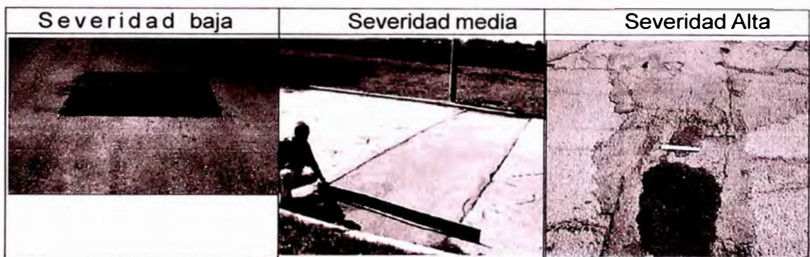
Foto N° 2.11 Bacnes y Zanjas Reparadas
