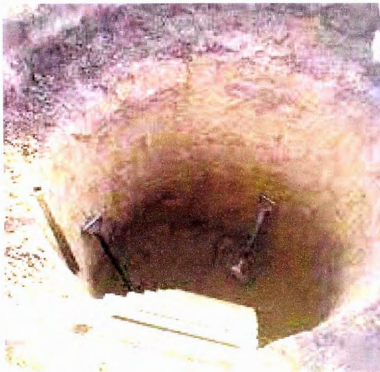
Figura N° 3.02: Excavación Manual de Pozo
