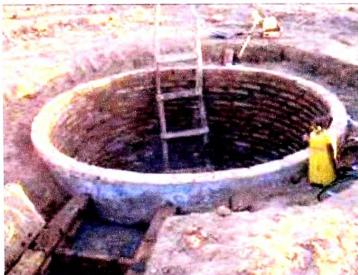
Figura N° 3.03: Revestimiento de Pozos
