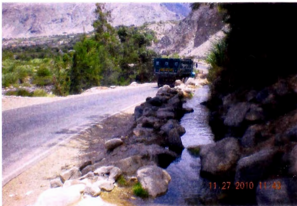
Encauzamiento de agua
