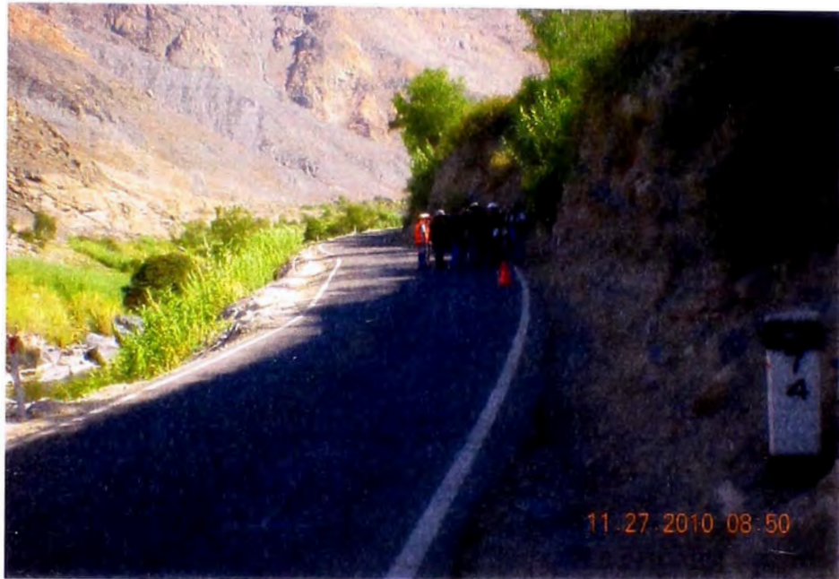
INICIO DEL TRAMO KM 74+000
