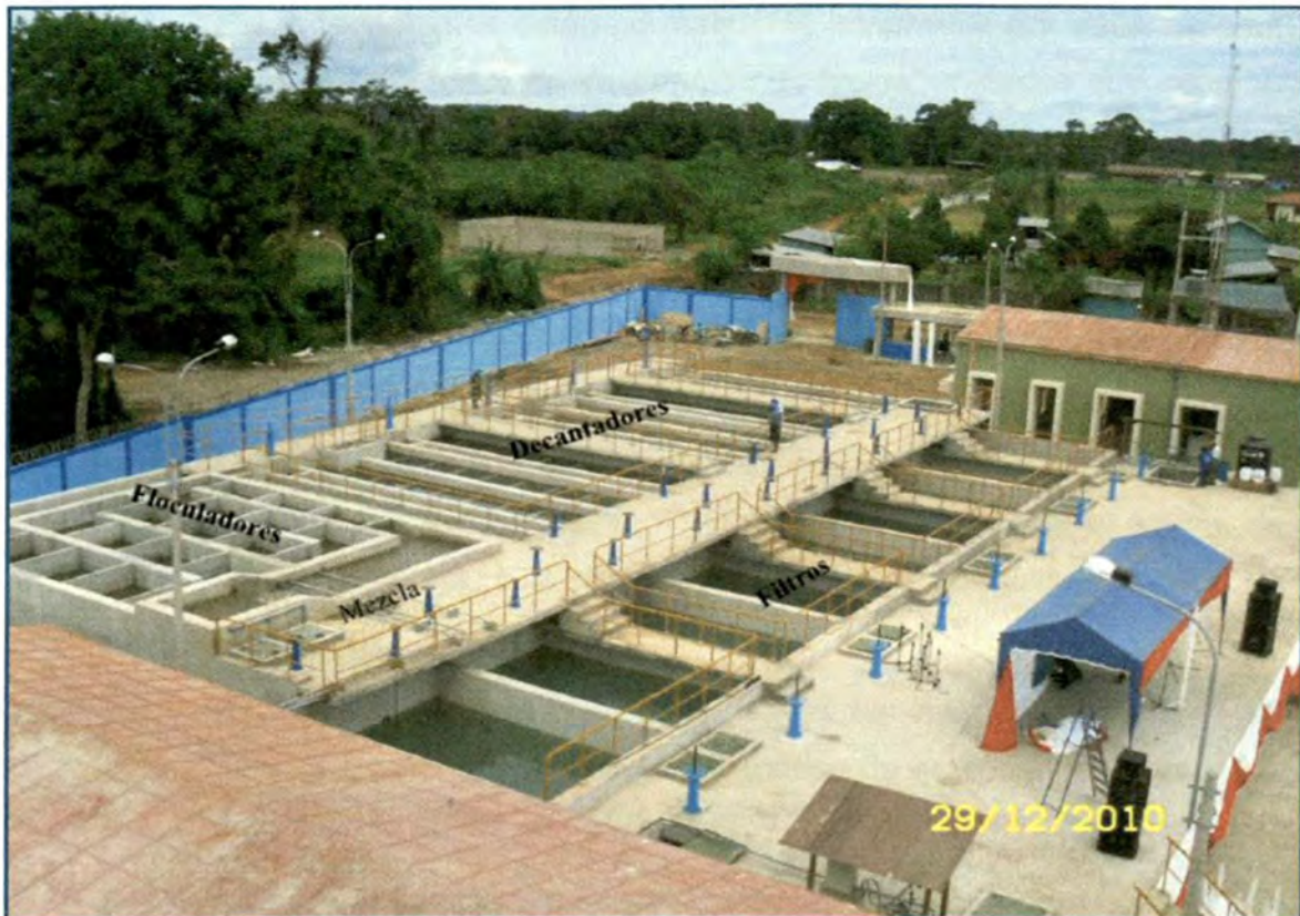
Figura N° 05: Planta de filtración rápida de alta tasa – Pto. Maldonado.
