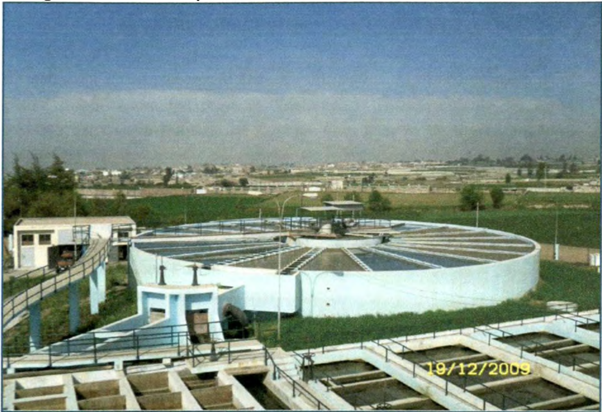
Figura N° 07: Planta patentada – Decantador de manto de lodos.
