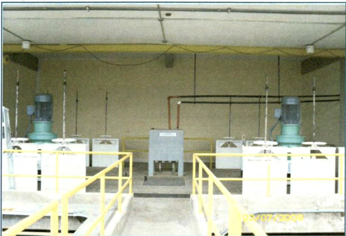
Figura N° 08: Planta patentada – Mezcladores rápidos mecánicos.
