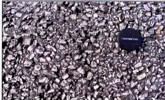
Foto N° B-4. Se aprecia la textura del sistema con SMA
