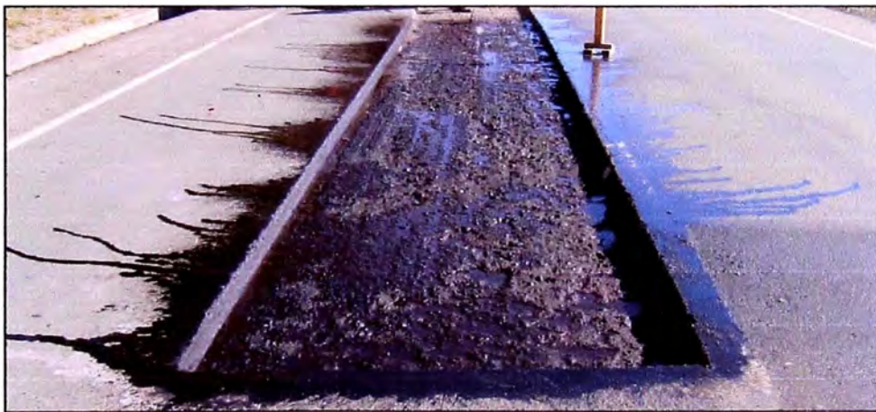
Foto N° B-6. Se aprecia el actividad de recapado o bacheo.
