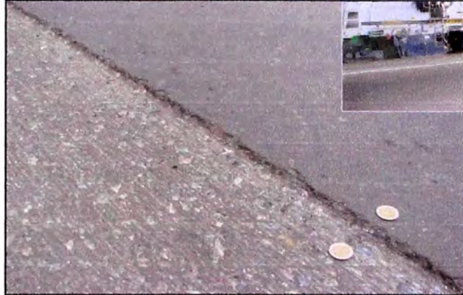
Foto N° B-5. Se aprecia el resultado de la actividad de cepillado.
