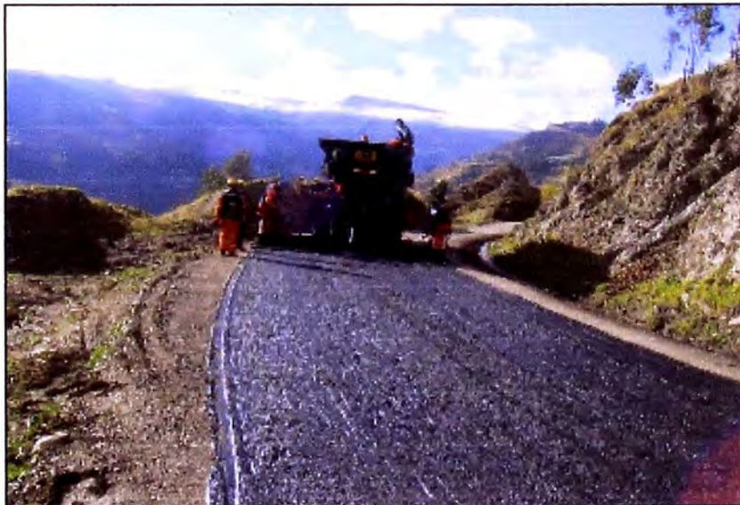
Foto N° 2-2. Colocación de lechada asfáltica (Slurry seal)
