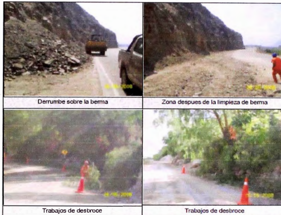
Foto N° 3-1. Algunas actividades correspondientes al mantenimiento rutinario.
