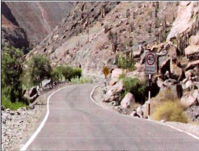
Foto N° 2-1. Se aprecia la sinuosidad de la carretera y la variación en el ancho de la vía.
