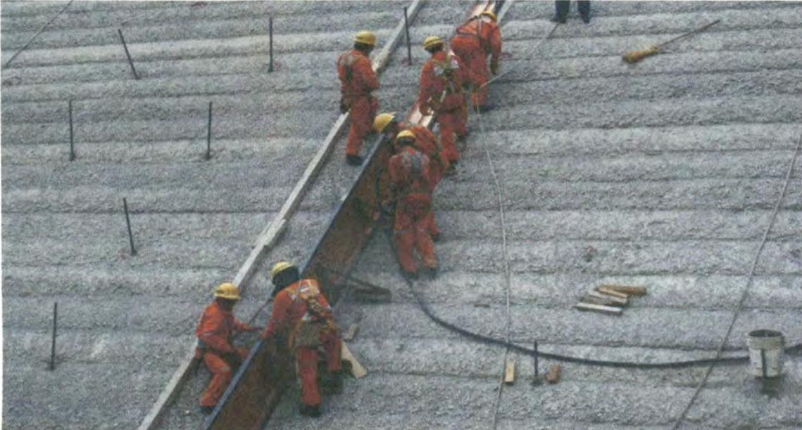
Figura N°19. Colocación de encofrado lateral, sobre el cual se monta el riel a través del cual se desplaza la regla deslizante. (Proyecto Traslase Olmos)
