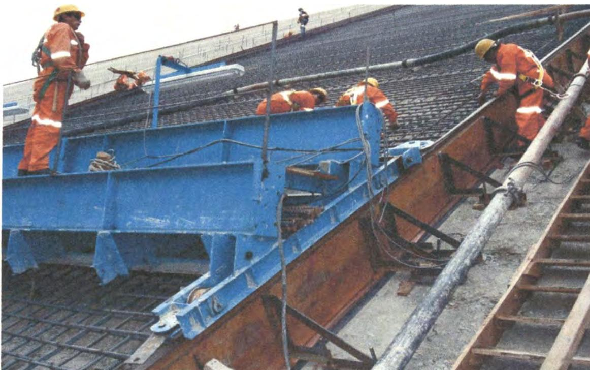
Figura N°20. Montaje de regla deslizante con el cual se dará el acabado final de la losa (Proyecto Traslase Olmos).
