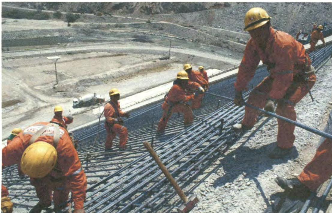
Figura N°15. Armado y colocación del acero de refuerzo de la losa de revestimiento de la presa del proyecto trasvase olmos (Proyecto Trasvase Olmos).
