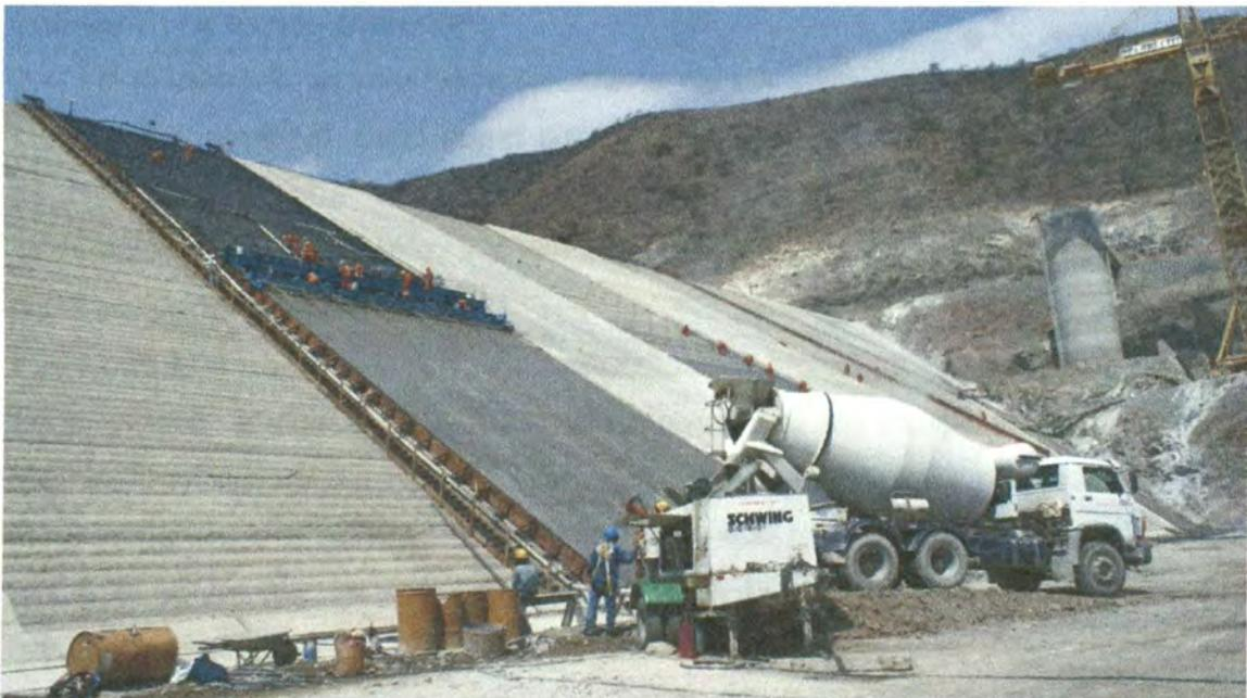
Figura N°23. Vista panorámica del vaciado de concreto (Proyecto Trasvase Olmos).
