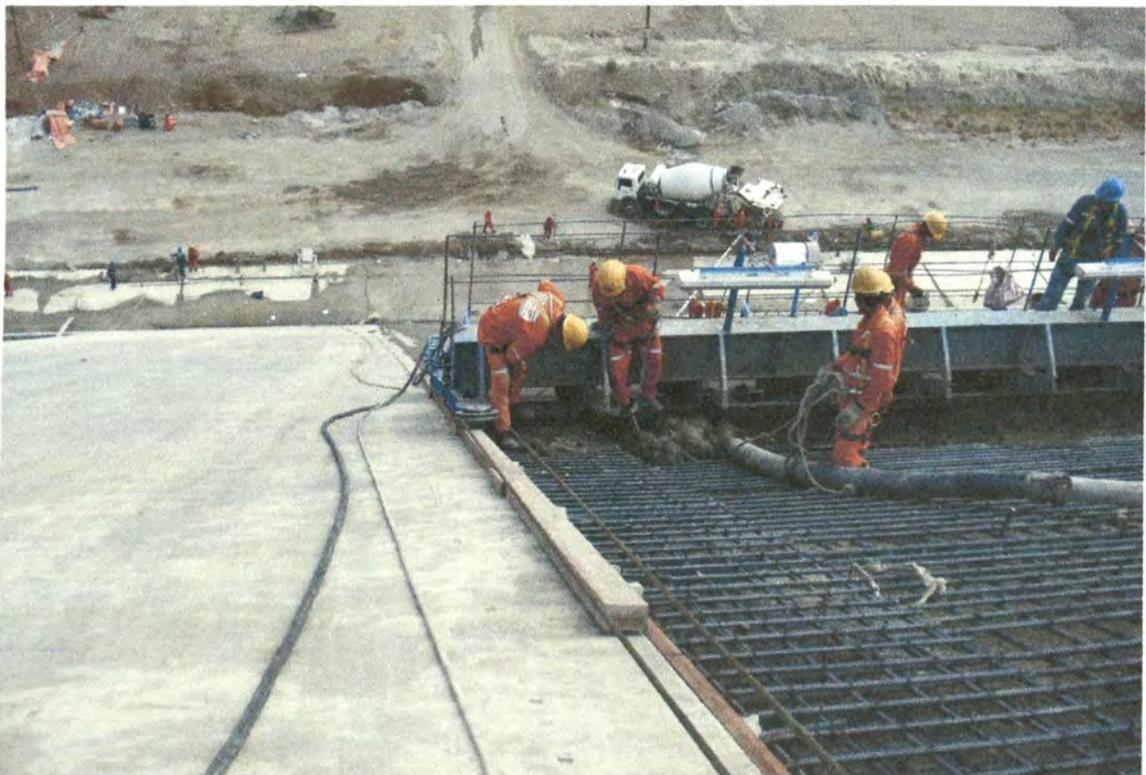
Figura N°21. Colocación de concreto a través de un sistema de bombeo (Proyecto Traslase Olmos).
