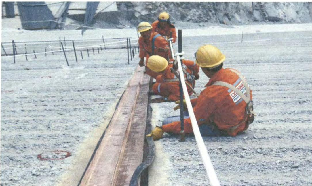
Figura N°18. Instalación de juntas de cobre y neopreno que van entre losas y sobre la cual se montaran las vigas del sistema deslizante. (Proyecto Traslase Olmos)
