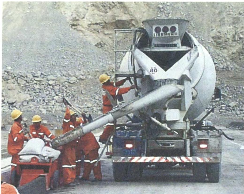
Figura N°9. Ejecución del bordillo con la maquina estrusadora (Proyecto Trasvase Olmos)
