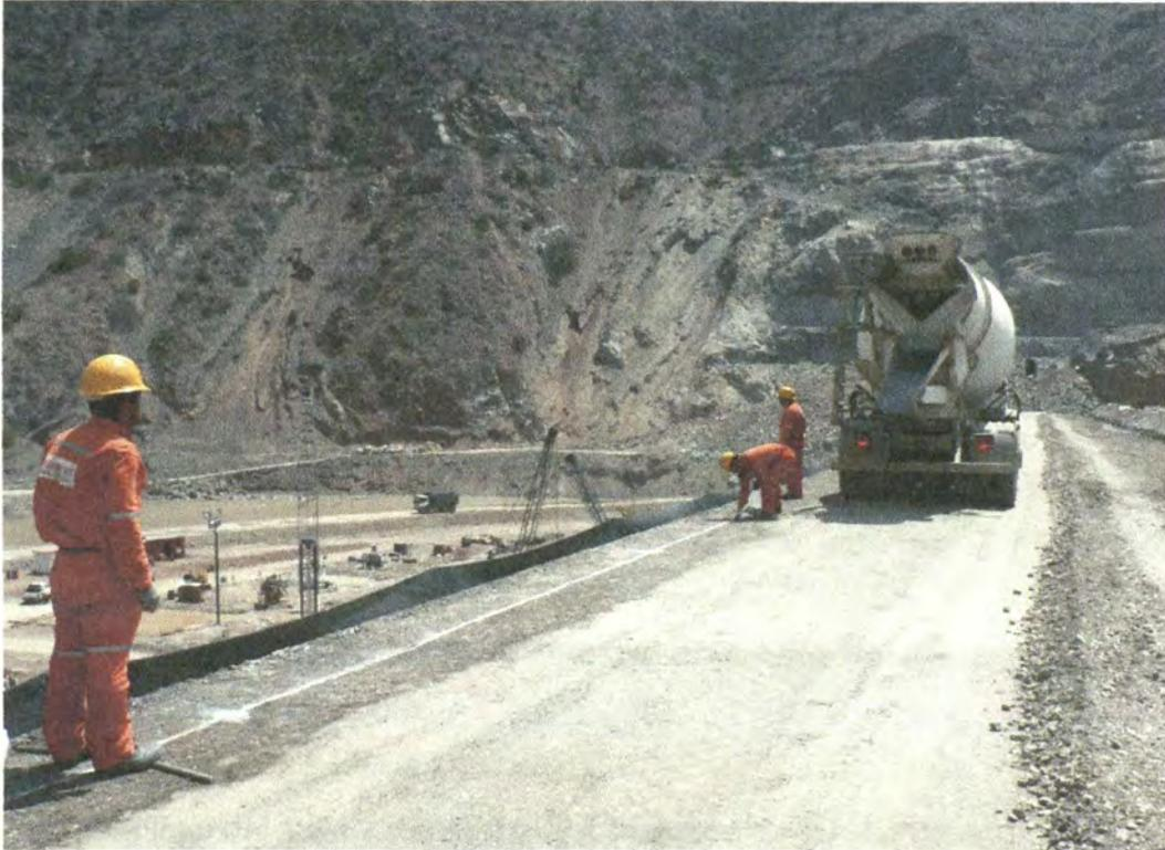
Figura N°8. Trazo previo a la colocación de concreto para bordillo (Proyecto Trasvase Olmos)
