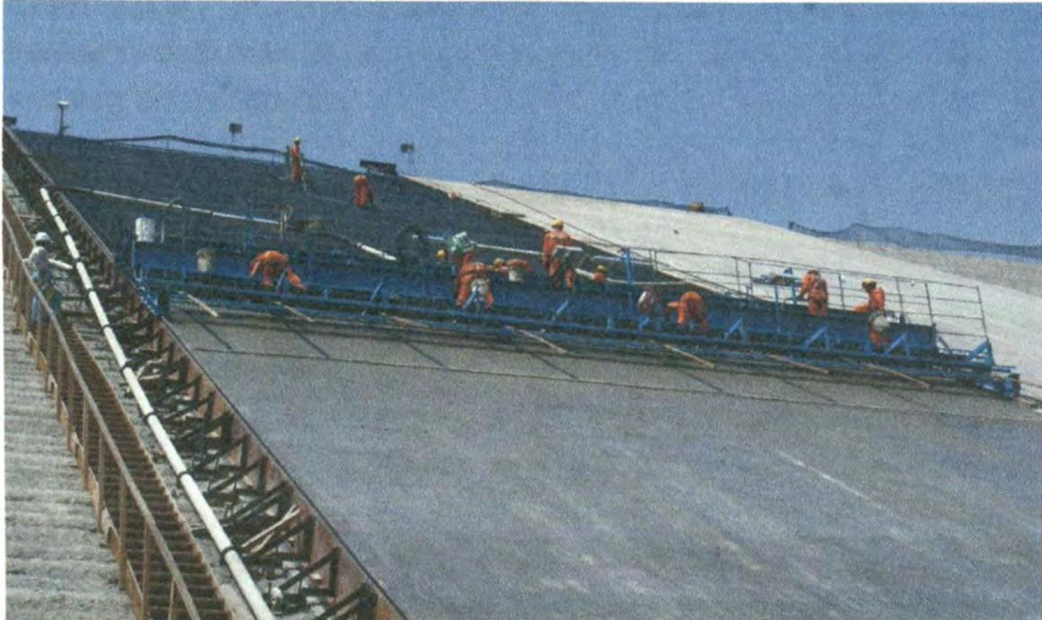
Figura N°22. Acabado de la losa de concreto realizado de forma manual desde la plataforma del sistema deslizante (Proyecto Trasvase Olmos).
