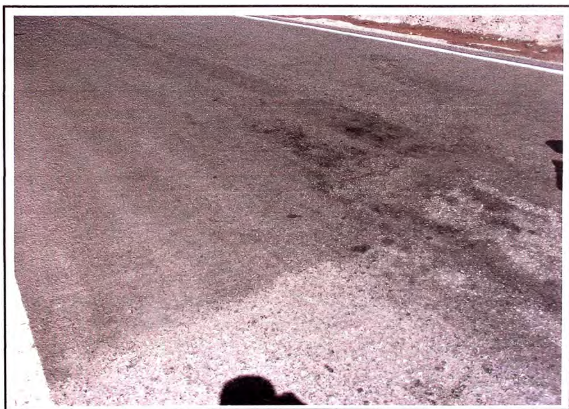
Fotografia N° 06: Sector de Refuerzo con Slurry Seal sobre Monocapa Km. 100+260
