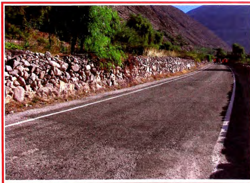
Figura Nº 1.03: Tramo de Estudio Km. 100+000 – Km. 102+000
