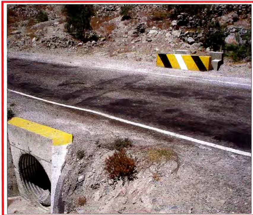
Figura N° 1.04: Alcantarilla Tipo TMC
