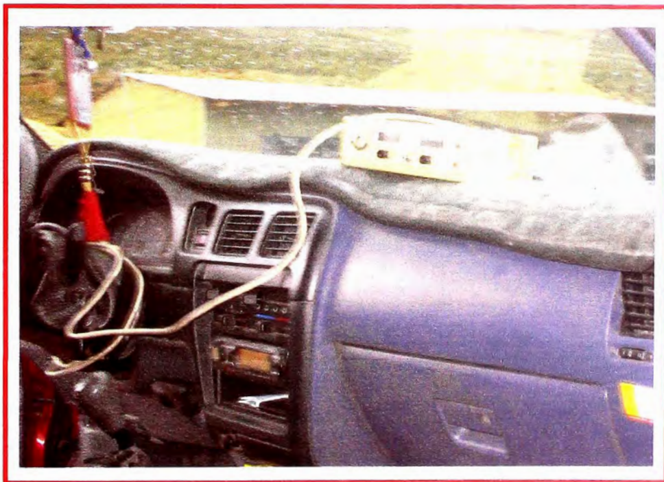
Figura Nº 4.01: Instalación del Adquisidor de Datos
