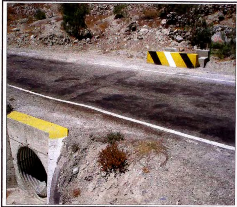
Fotografía N° 03: Alcantarilla Tipo TMC 24" Km. 100+970
