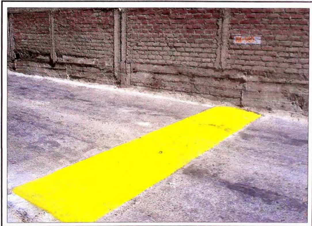
Fotografía N° 04: Presencia de Gibas en el Sector Km. 101 + 500
