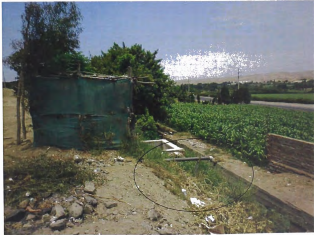
Foto N° A.10: Baños construidos rústicamente en el centro poblado Primavera, las cuales son conectados hacia el canal de regadío para su descarga.
