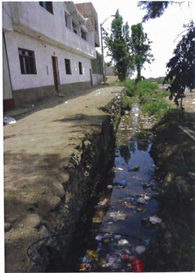
Foto N° A.8: Los desagües descargan en el canal de regadío, que sirve como fuente para riegos de las áreas cultivo, que es de consumo humano.
