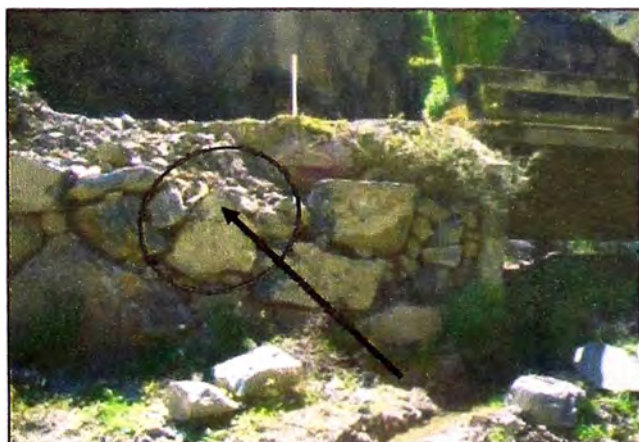
Foto N° 3.19, Inspección Muro Piedra
