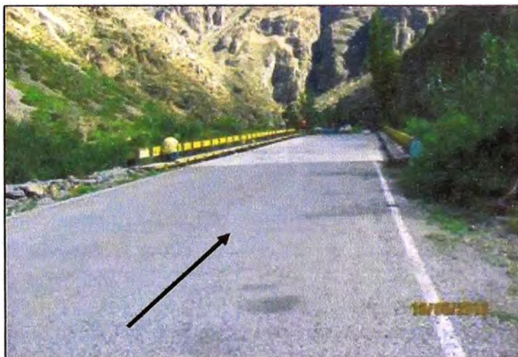
Foto N° 3.17, Inspección Acceso Izquierdo Puente
