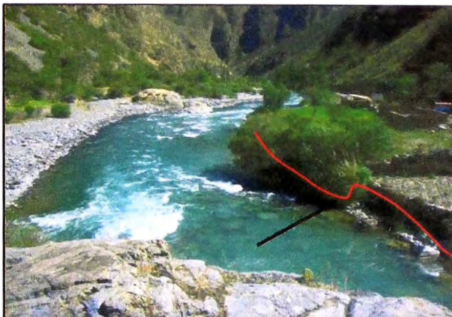
Foto N° 3.03, Inspección Cauce Aguas Abajo
