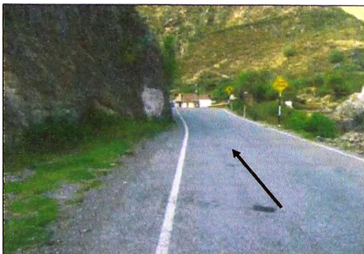
Foto N° 3.18, Inspección Acceso Derecho Puente
