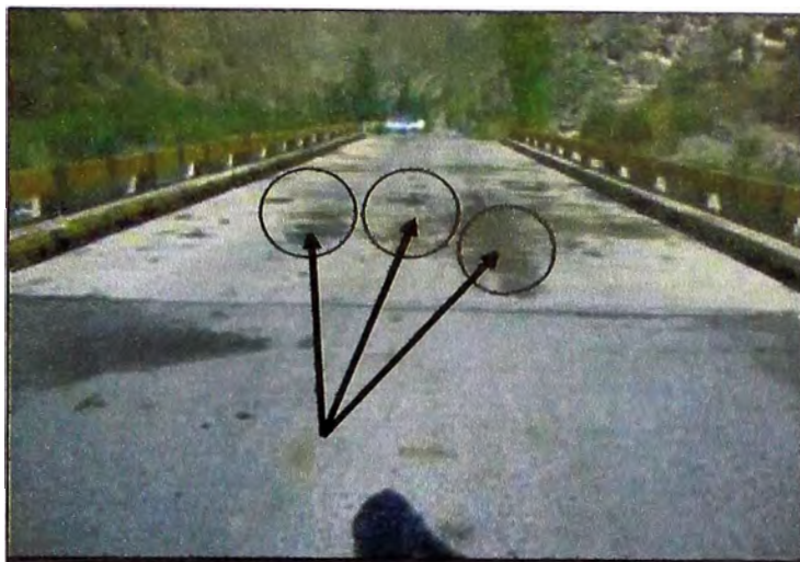
Foto N° 3.13, Inspección Superficie de Rodadura
