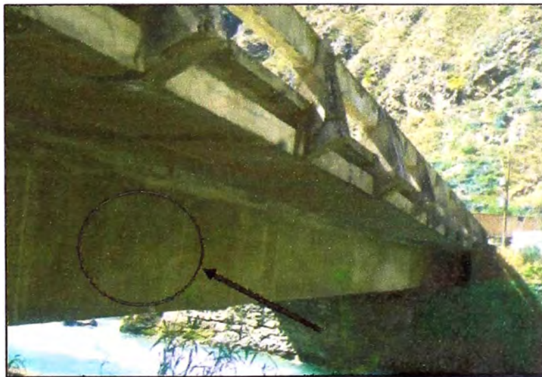
Foto N° 3.09, Inspección Vigas Principales
