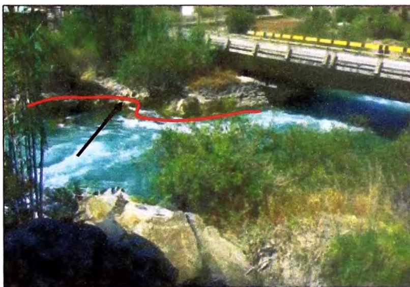
Foto N° 3.02, Inspección Cauce Aguas Arriba
