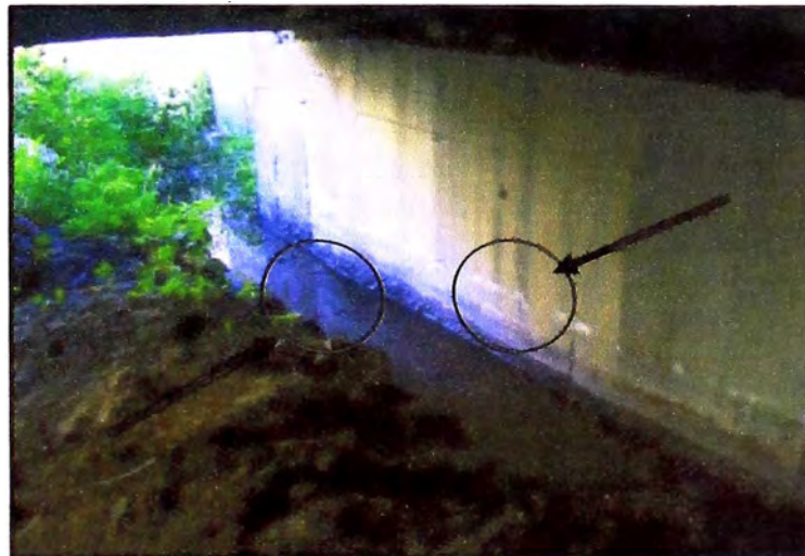
Foto N° 3.06, Inspección Estribo Derecho
