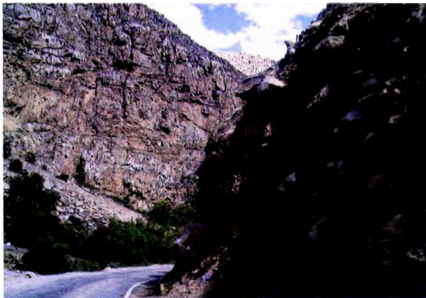
Foto N° 01 Curva sin visibilidad en el km 113+400
