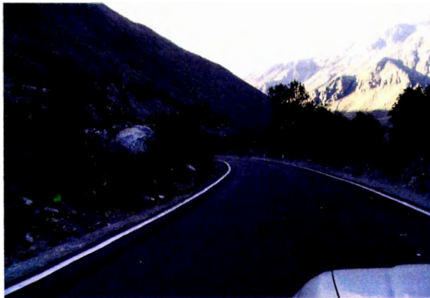
Foto N° 02 Curva sin visibilidad km 100+800
