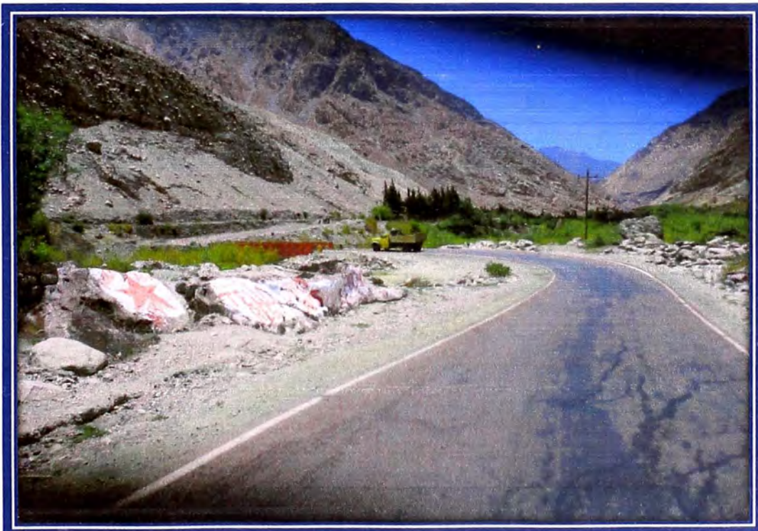
Fotografía 2: Estado actual del tramo de la carretera en estudio Progresiva 77+800
