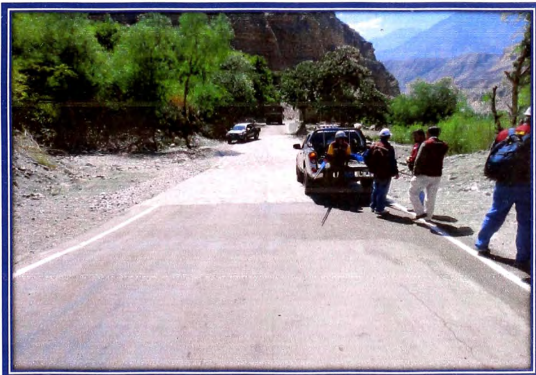
Fotografía 4: Estado actual del tramo de la carretera en estudio Progresiva 82+800
