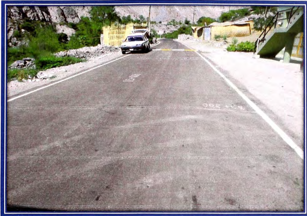
Fotografía 3: Estado actual del tramo de la carretera en estudio Progresiva 83+800
