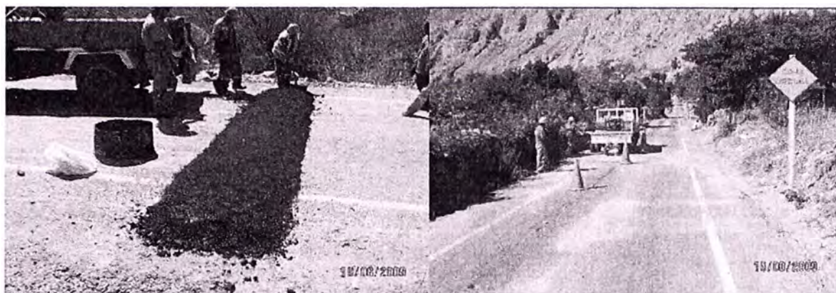
Figura N° 3.02: Trabajos de ejecución de gibas no contemplado en el proyecto inicial
