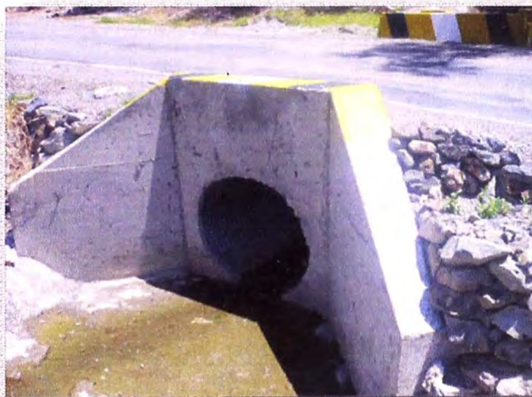
Figura N° 7.05: Imágenes de alcantarilla progresiva 142+ 125
