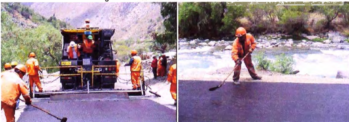
Figura N° 5.09: Tendido de mortero asfáltico
