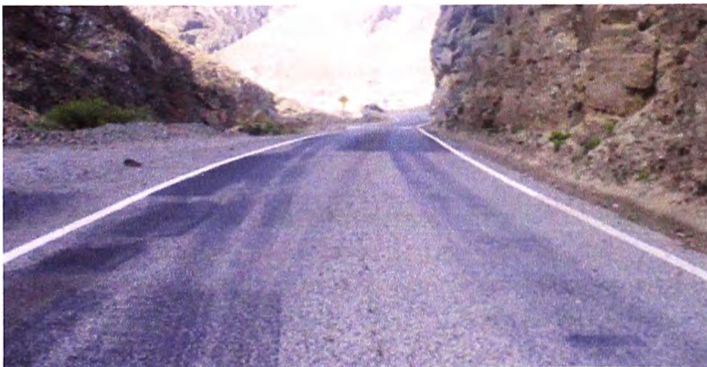
Figura N° 4.01: Ejemplo desgaste y exudación
