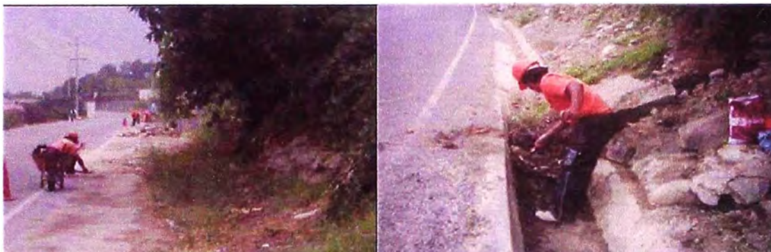
Figura N° 5.01: Limpieza de bermas y cunetas
