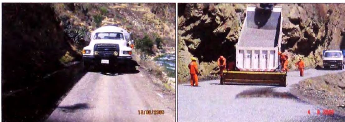
Figura N° 2.07: Proceso constructivo de carretera con Monocapa, riego esparcido de grava
