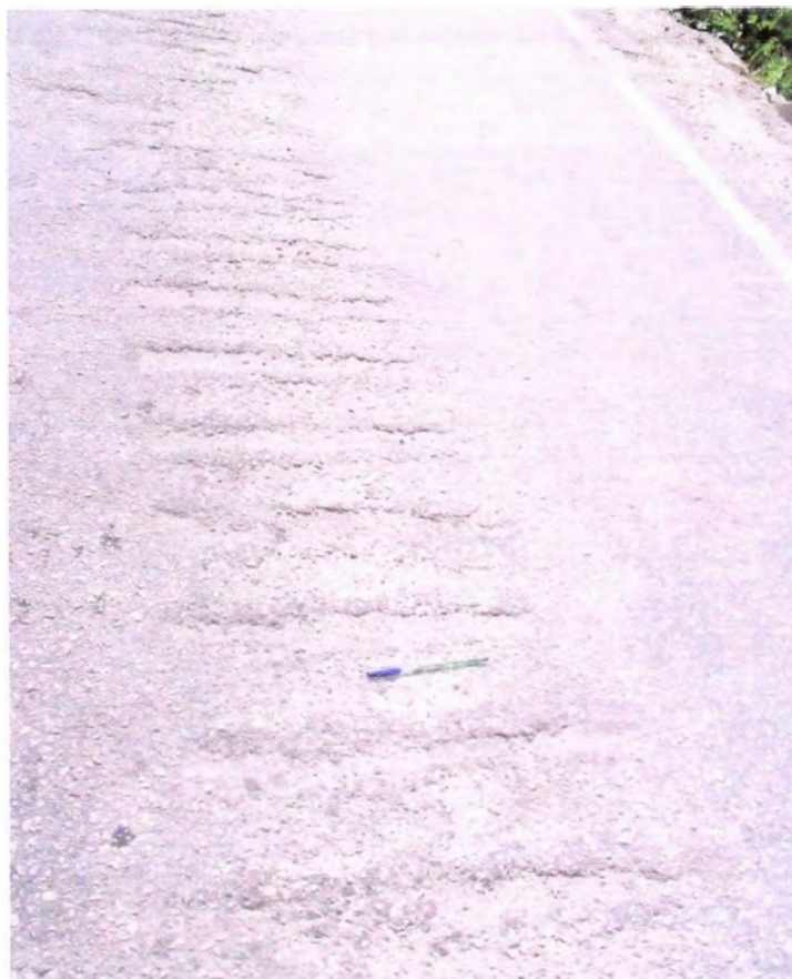
Foto N°09 Huellas de maquinaria pesada
