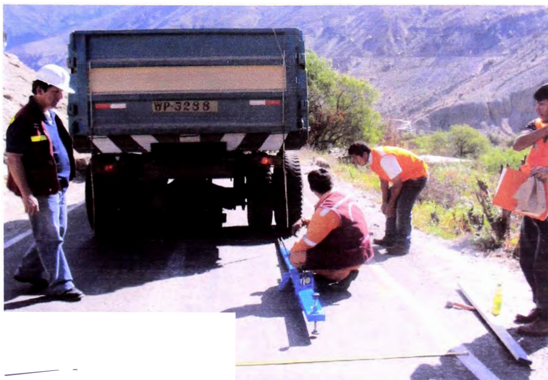
Foto N°10: Ensayo de viga Benkelman
