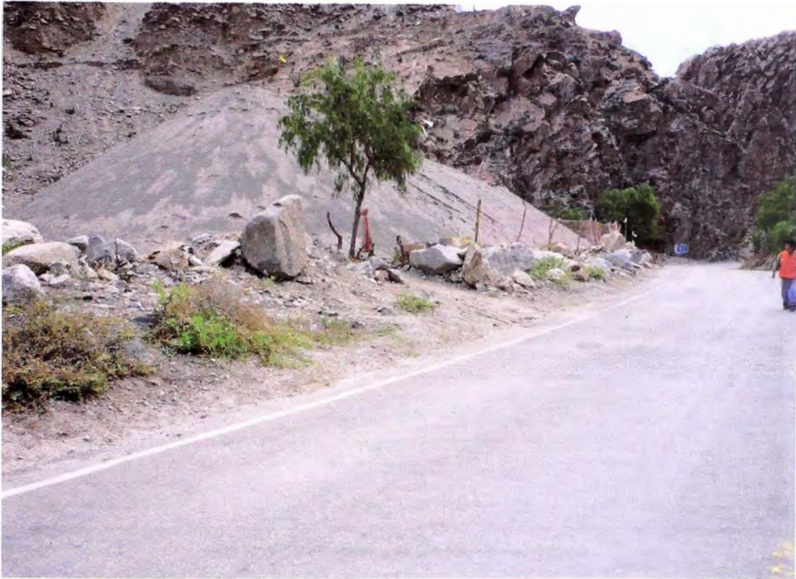
Foto N°03: Zona de acopio para agregado fino, no hay cunetas carril izquierdo
