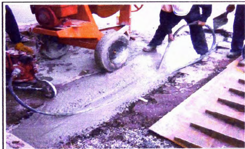
Figura 3.19. Colocación y vibrado del concreto en juntas de dilatación.
