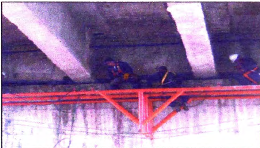
Figura N° 3.9, La forma de cómo se colocan los gatos hidráulicos(ejemplo de un caso similar )
