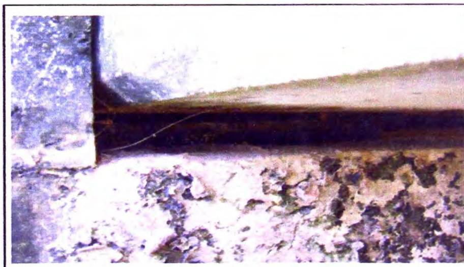
Figura N° 3.10, Colocación de los apoyos de Neopreno (ejemplo de un caso similar)
