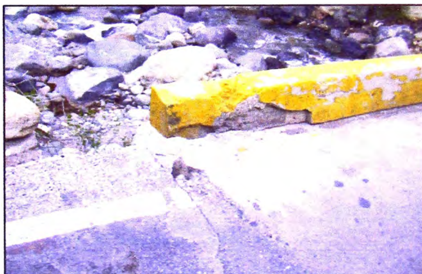
Figura N° 3.6 Se puede apreciar el deterioro del sardinel
