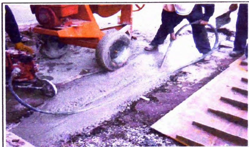
Figura 3.20. Acabado superficial liso en juntas de dilatación (ejemplo de trabajos similares)
