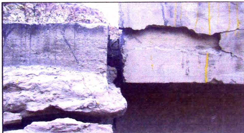
Figura N° 3.14 No tiene junta de dilatación-Vista Perfil
