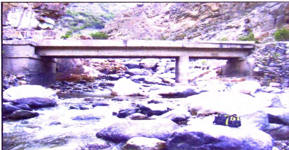
Figura N° 3.11 Se puede apreciar la cantidad de bolonería y canto rodado en la zona
