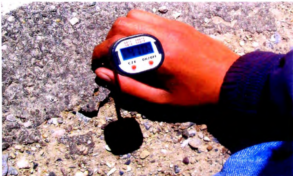
Foto 4: Medición de la temperatura de la carpeta de rodadura en el punto de ensayo, con termómetro digital.
