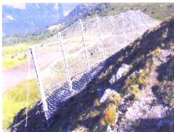
Figura N°2.04 Protecciones dinámicas-activas para caídas de rocas
