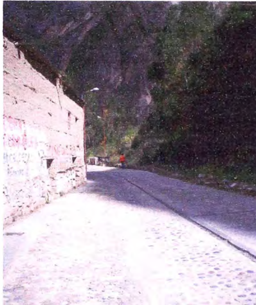
Figura N°2.06 Emboquillado en el pueblo de Tomas
