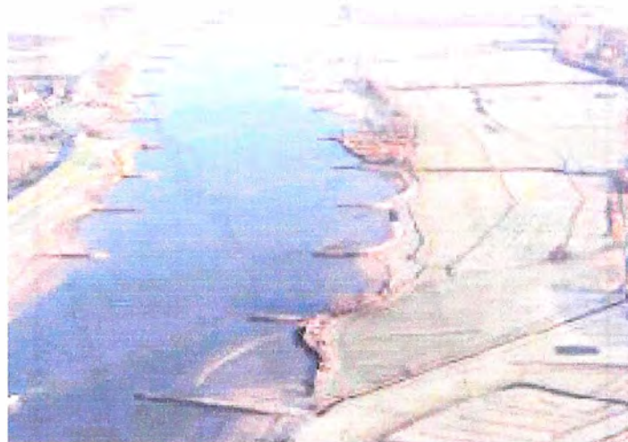
Fuente: Conferencia Consideraciones sobre las defensas fluviales a base de espigones. Dr.- Ing. Arturo Rocha Felices Figura N°2.02 Control de erosión fluvial, defensas discontinuas: Espigones
