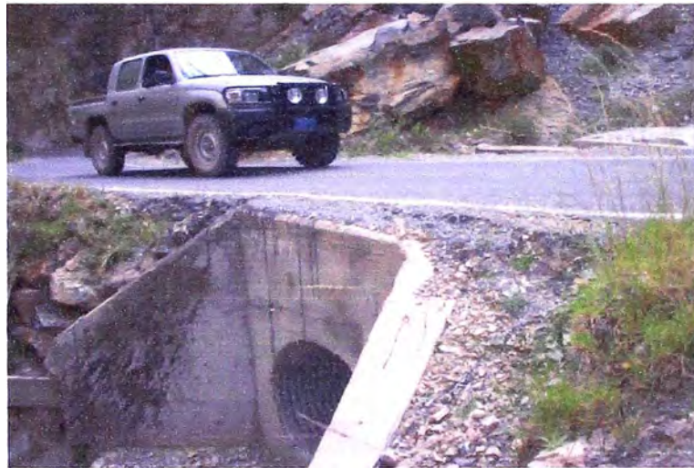
Figura N°1.02 Alcantarilla
