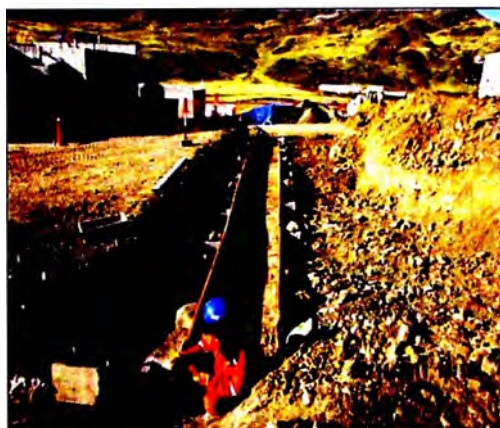
Figura N° 2.8. Encofrado de losa de nivelación
