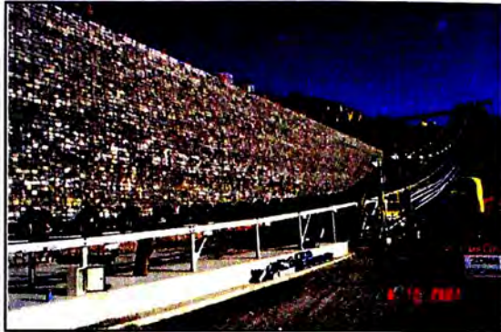
Figura N°1.11. Acceso a la chancadora primaria Gold Fields (h=16.50m)
