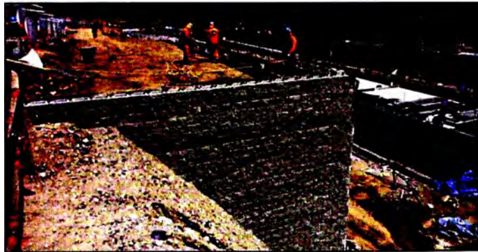
Figura N° 1.7. Muro de Suelo reforzado en zona urbana
