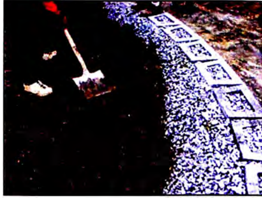
Figura N° 1.16. Drenaje posterior y dentro de los bloques
