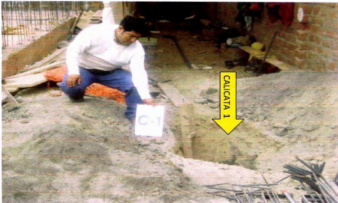
Foto 3: Excavación de calicata 1
