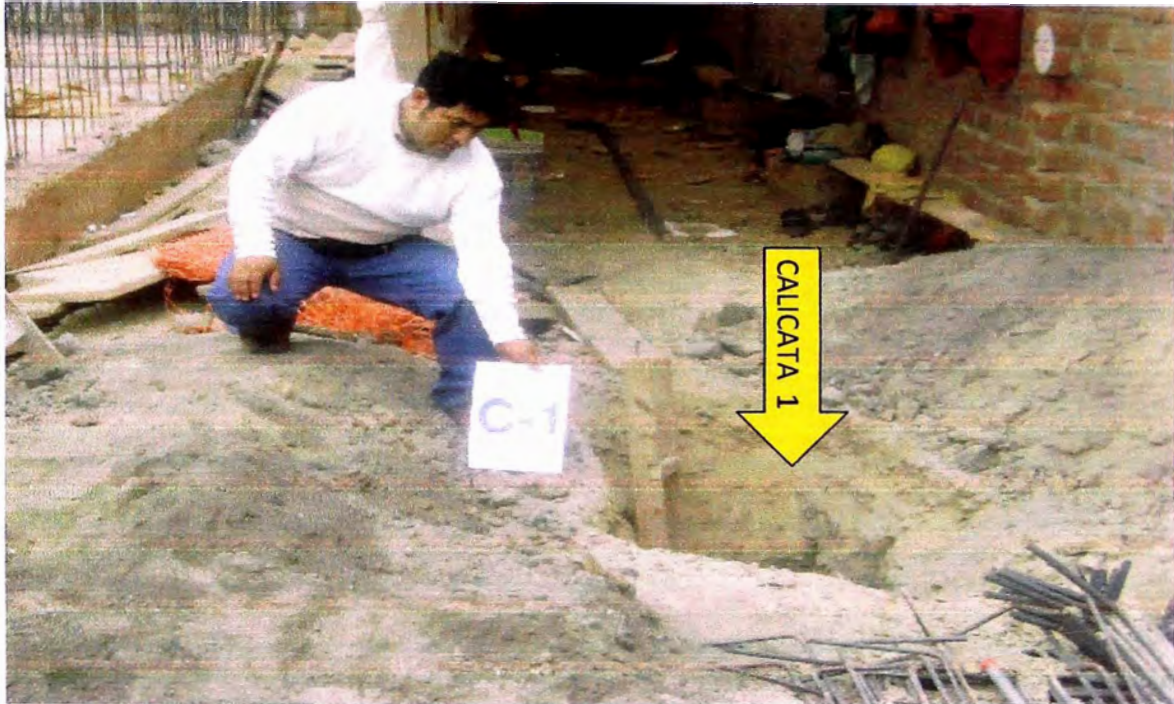
Foto 3: Excavación de calicata 1
