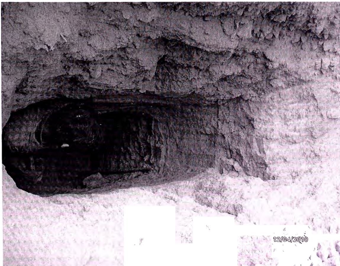
Foto 3.1 Excavación de calicata
