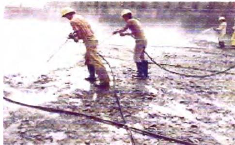
**Figura 1: Corte con Partek para la preparación de las juntas de construcción**
