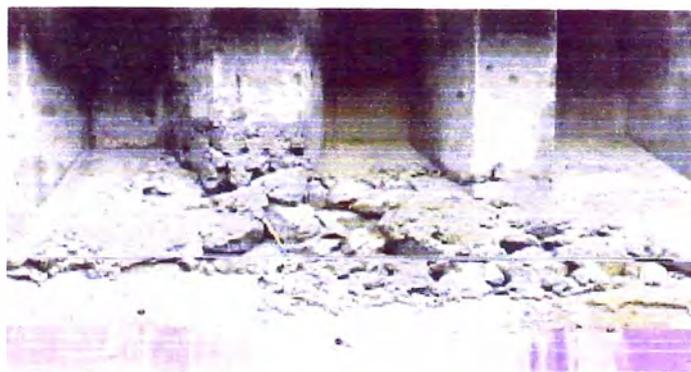
**Figura 2: Concreto endurecido con indicación de cangrejas.**
