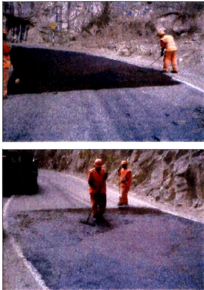
FIGURA 1.06 VISTAS DEL TRATAMIENTO SUPERFICIAL SLURRY SEAL EN EL KM 138+500
