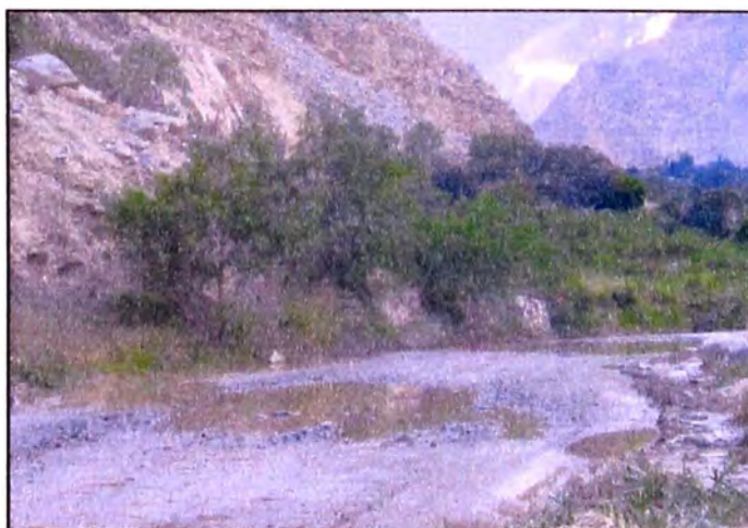
FIGURA 1.01 PRESENCIA DE BACHES PROFUNDOS EN EL KM 93
