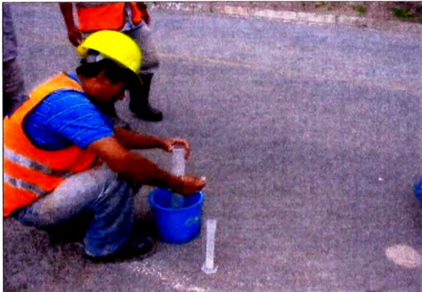
Figura N°3.08 Medición de Macrotextura con el Método de Circulo de Arena
