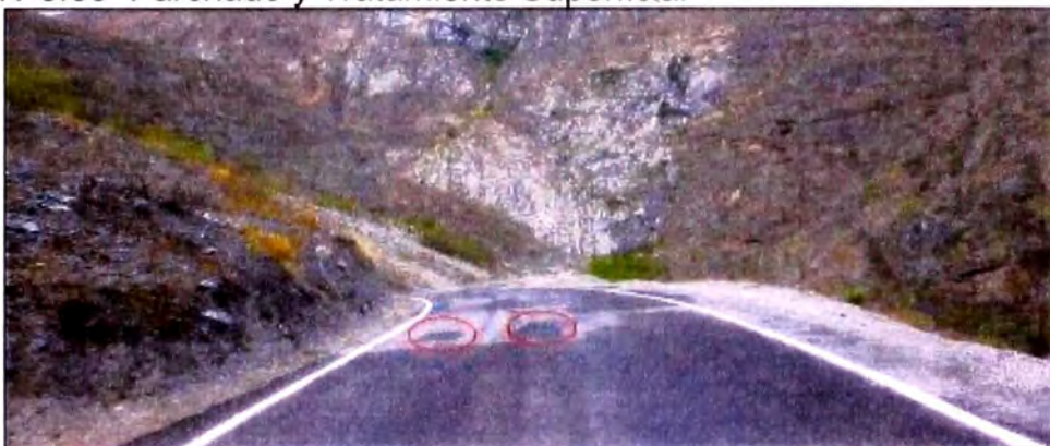
Figura N°3.05 Parchado y Tratamiento Superficial
