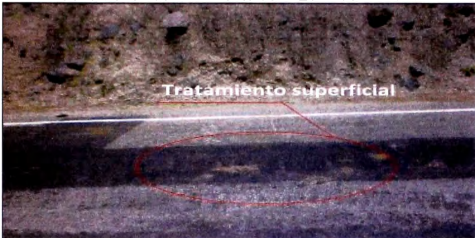
Figura N°3.04 Condiciones del Pavimento de la Zona de Evaluación
