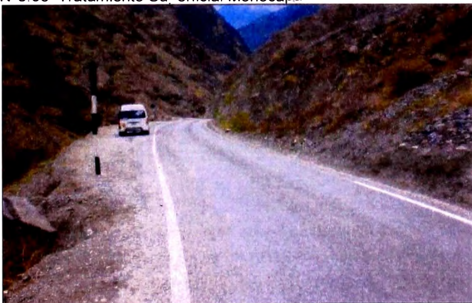
Figura N°3.06 Tratamiento Superficial Monocapa
