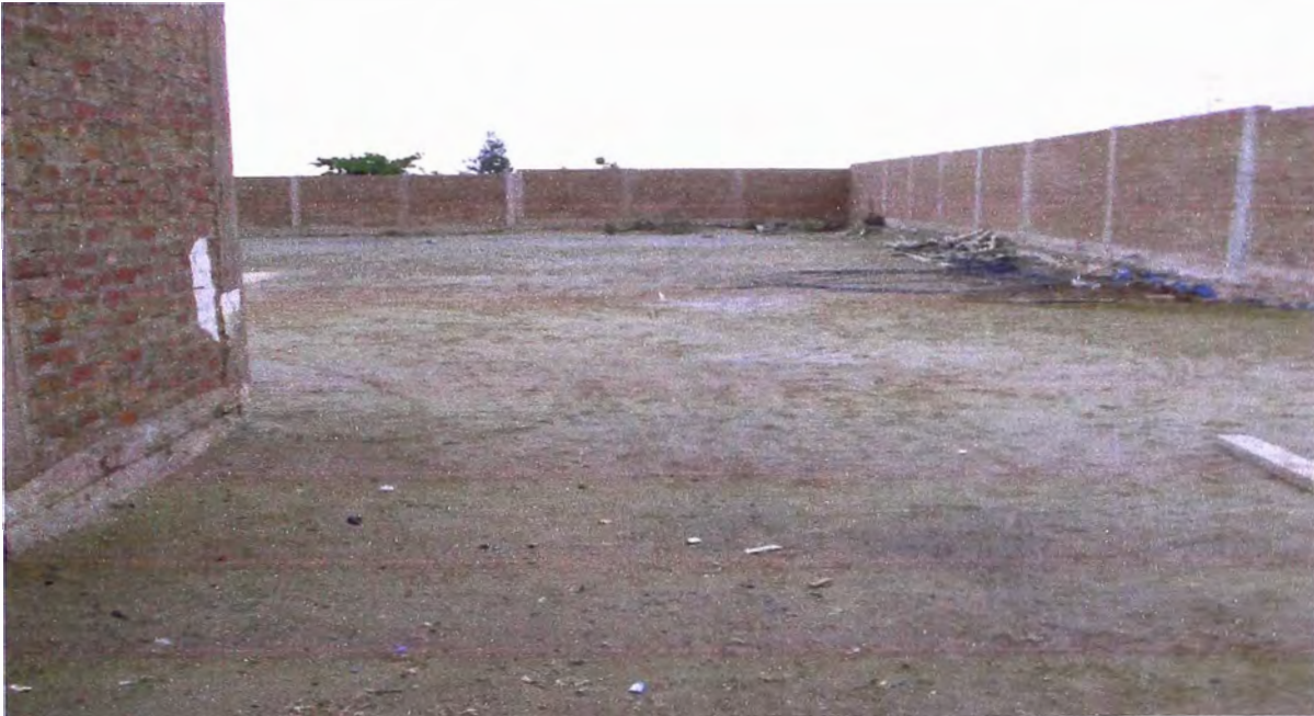
Figura N° 3.07 Almacén 1: Interior del Local Municipal
