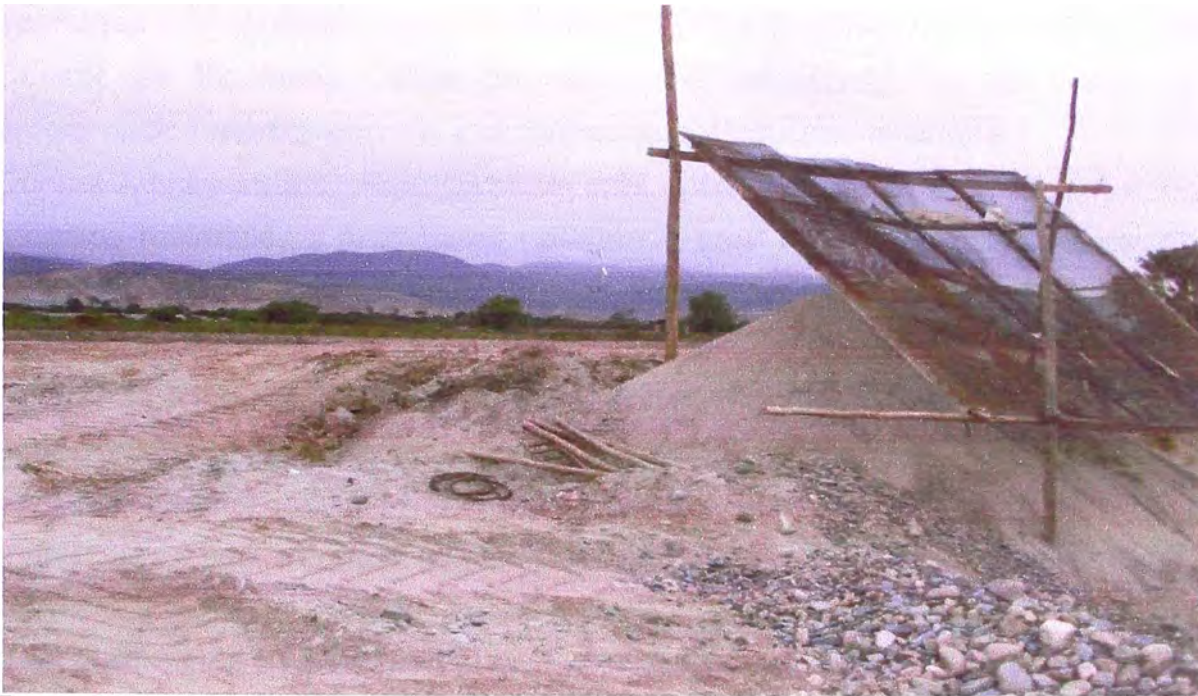
Figura N° 3.10 Cantera de Arena Gruesa al Fondo el Centro Poblado de Santa Rosa
