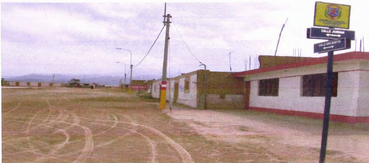
Figura N° 3.05 Calle San Martín Mostrando el Ancho de su Vía
