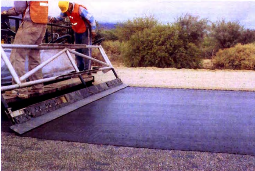
Mantenimiento Periódico – Recapeo con Slurry Seal
