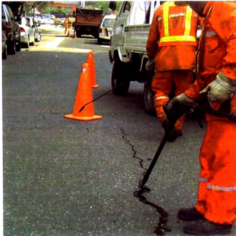
Figura 4.12: Sellado de fisuras
