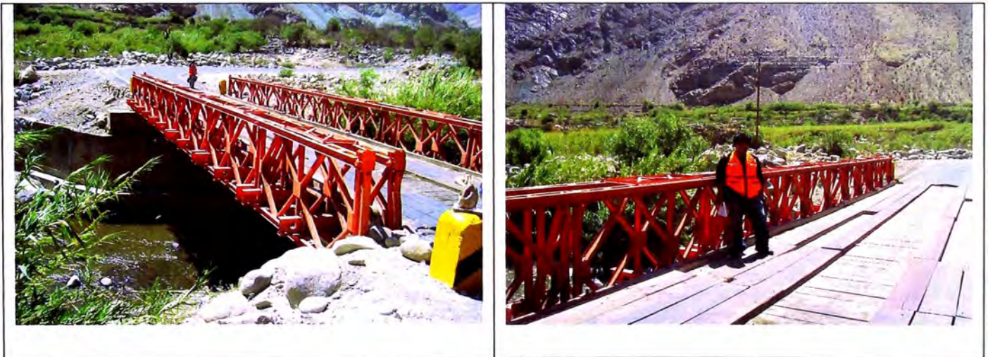
Puente Reticulado, en Huallampi
