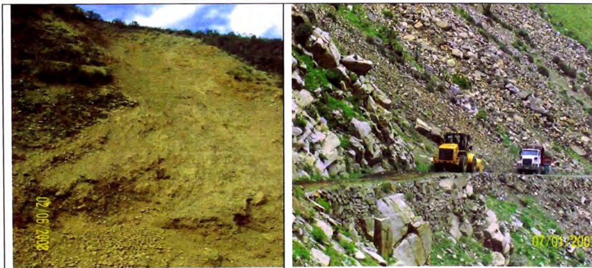
Punto crítico debido a Inestabilidad de taludes
