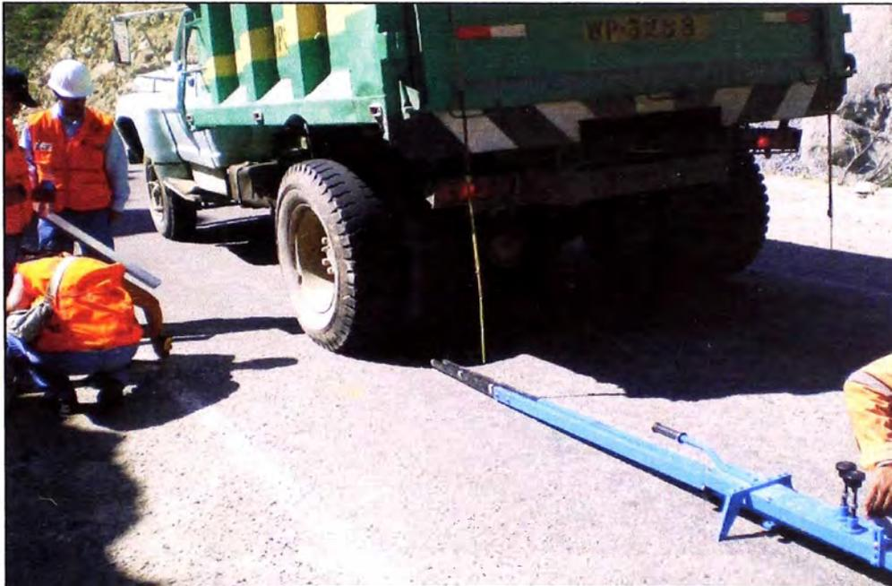
**FOTO 18: Se nivelan las bases y se ajustan los diales**
