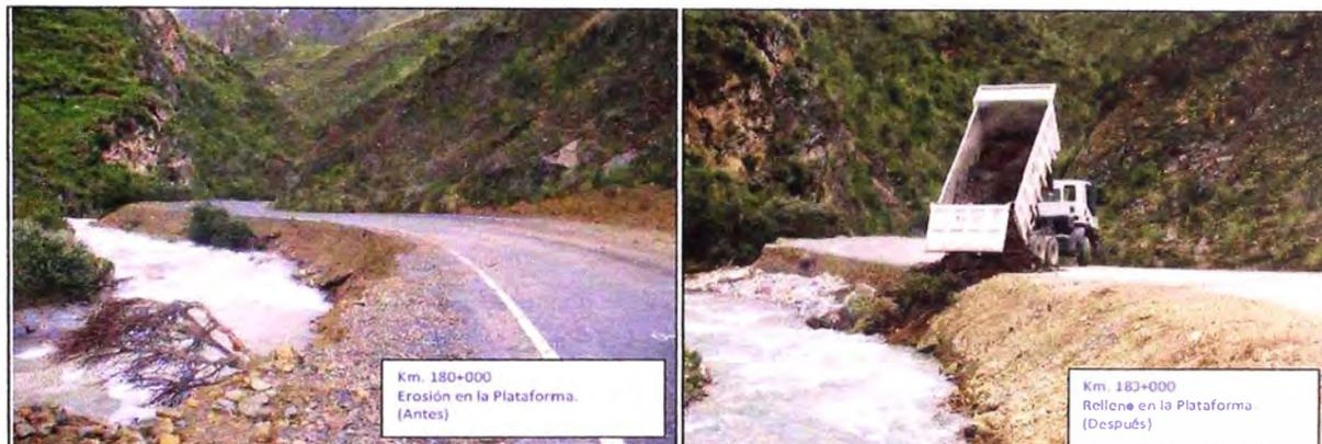
Foto 5.1. Relleno en la plataforma del Km. 180+000
