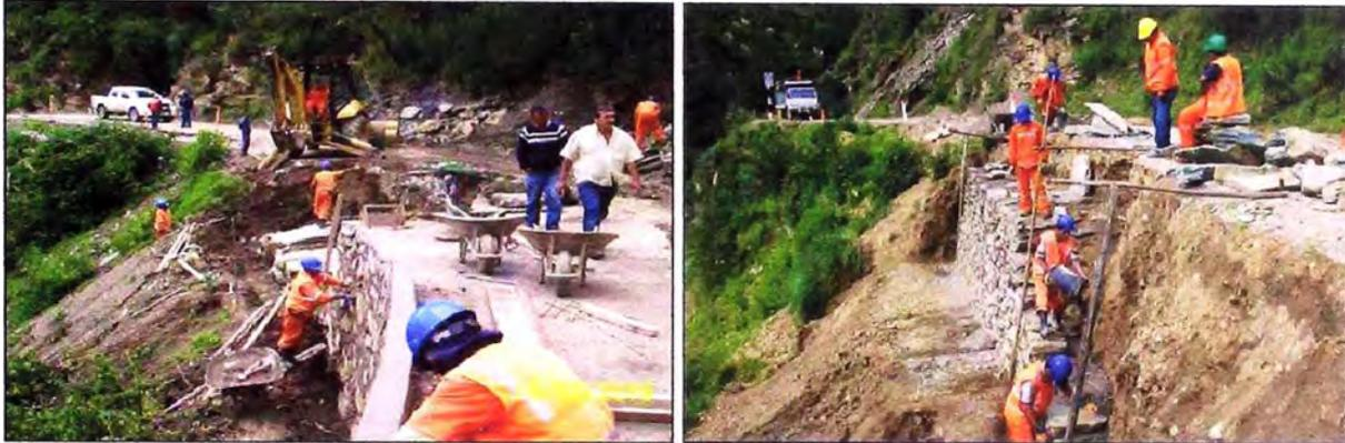
Foto 5.3. Construcción de Muro de Mampostería
