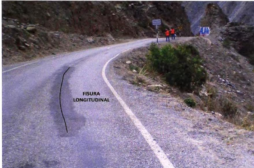
Foto 3.1. Fisura longitudinal
