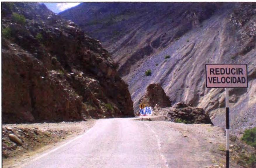
FOTO 12: Km. 108+500: Talud con posible desprendimiento de material.
