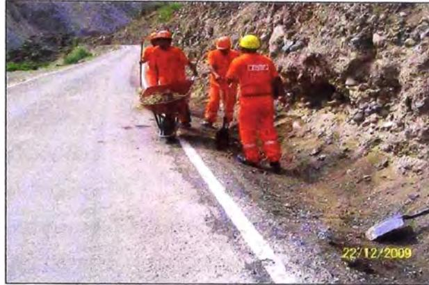
Foto 5.5. Construcción de cunetas no revestidas
