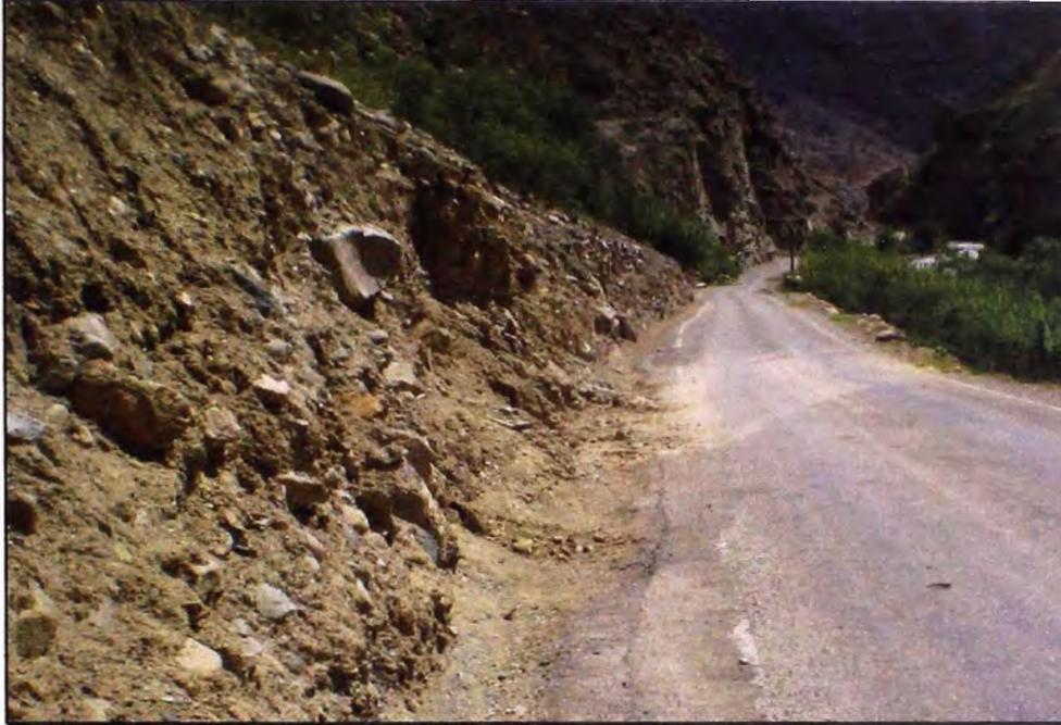
**FOTO 13: Km. 108+700: caída de huayco, inadecuada limpieza de las cunetas no revestidas.**
