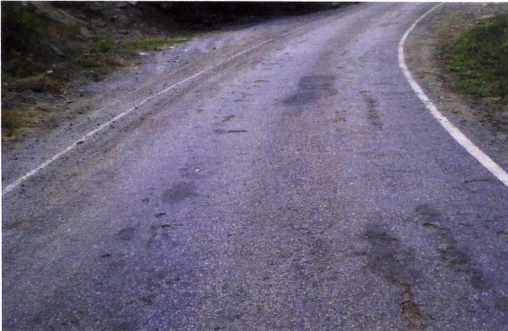
**FOTO 15: Km. 109+600: deterioro de la superficie de rodadura (monocapa)**
