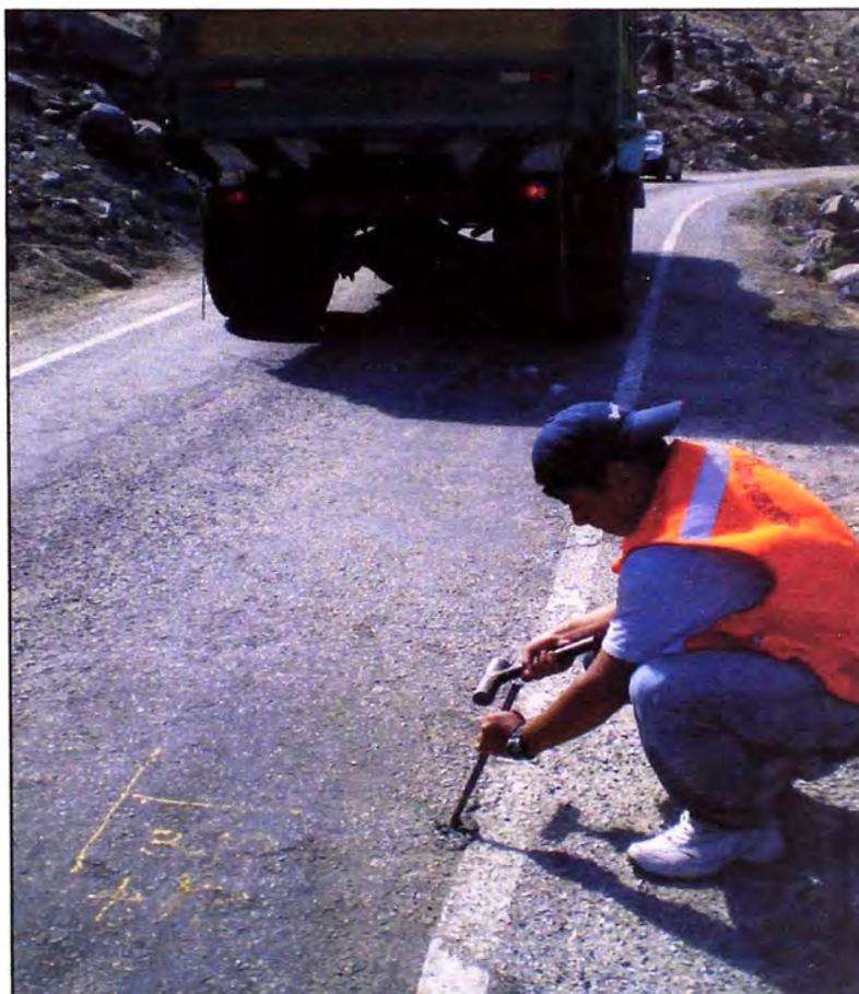
FOTO 21: Finalmente se realiza un hueco en el pavimento para la medición de la temperatura.
