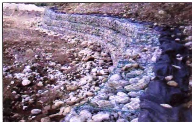
Foto 5.2. Enrocado para proteger socavación y erosión el río
