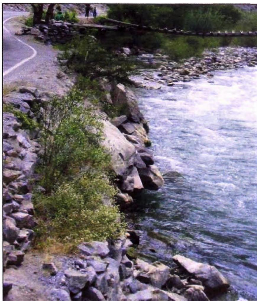
**FOTO 7. Km. 109+000: Erosión de plataforma**
