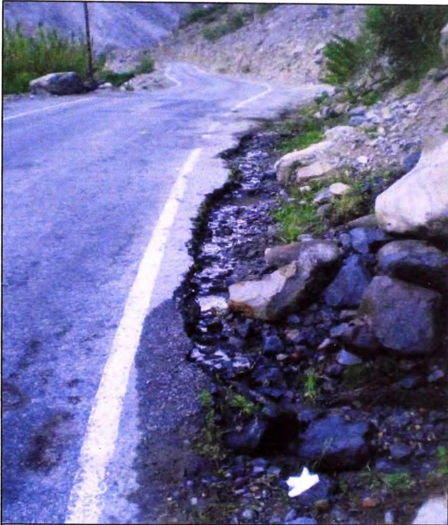
**FOTO 2. Km. 108+800: Falta de drenaje que genera erosión.
