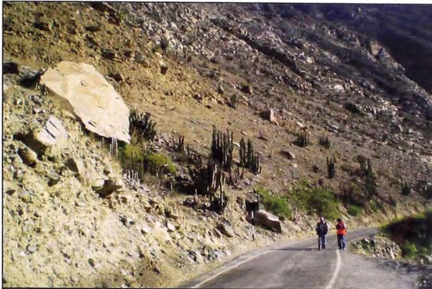
**FOTO 8. Km. 109+800: Taludes rocosos con potencial desprendimiento
