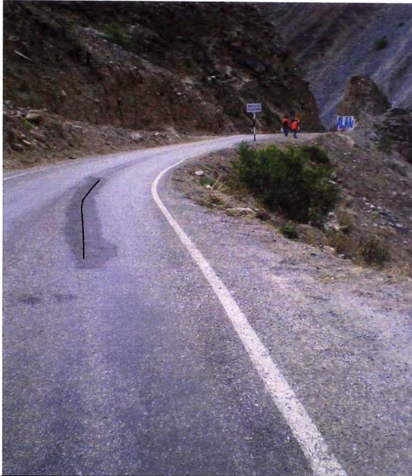
**FOTO 1. Km. 108+400: Fisuras causa de desprendimiento de talud
