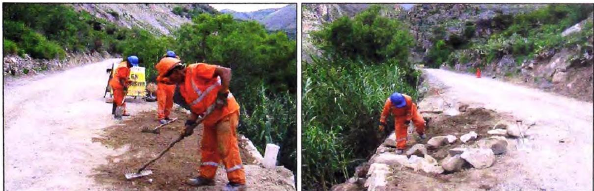
Foto 5.4. Construcción de muro seco Km. 107+200
