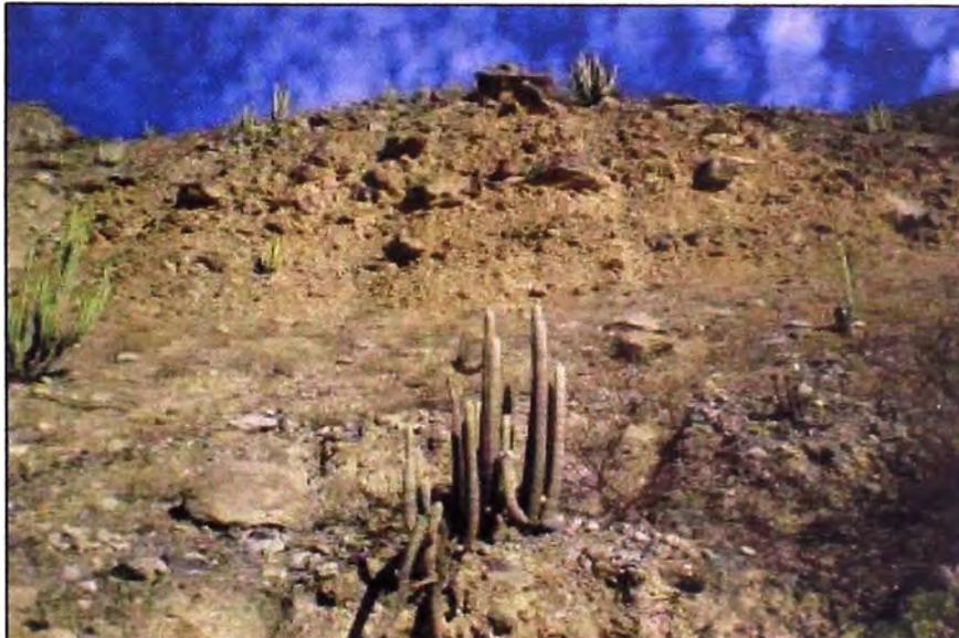
**FOTO 9. Km.109+900: Taludes rocosos con potencial desprendimiento
