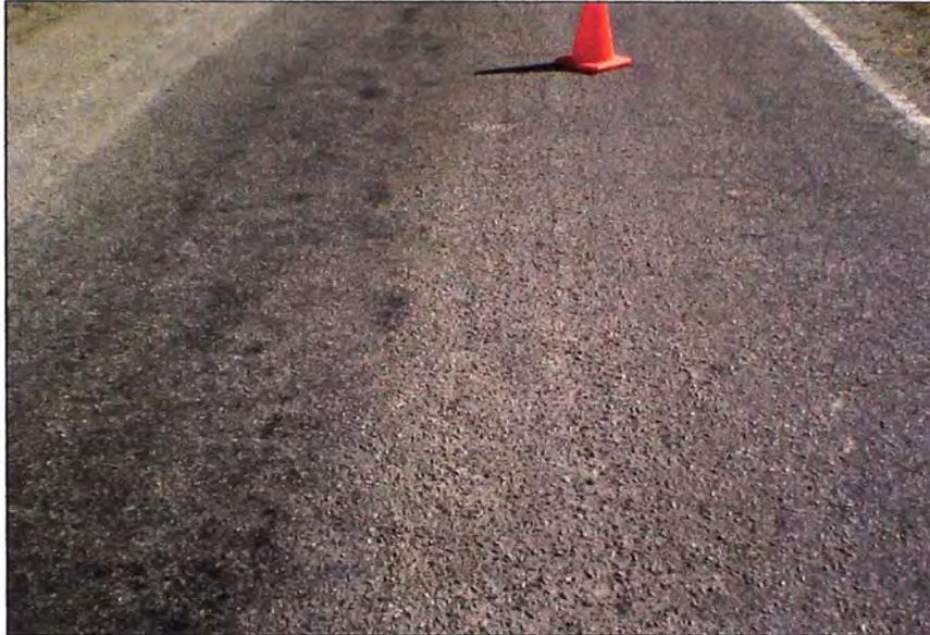
Foto 3.2. Desintegración superficial del monocapa
