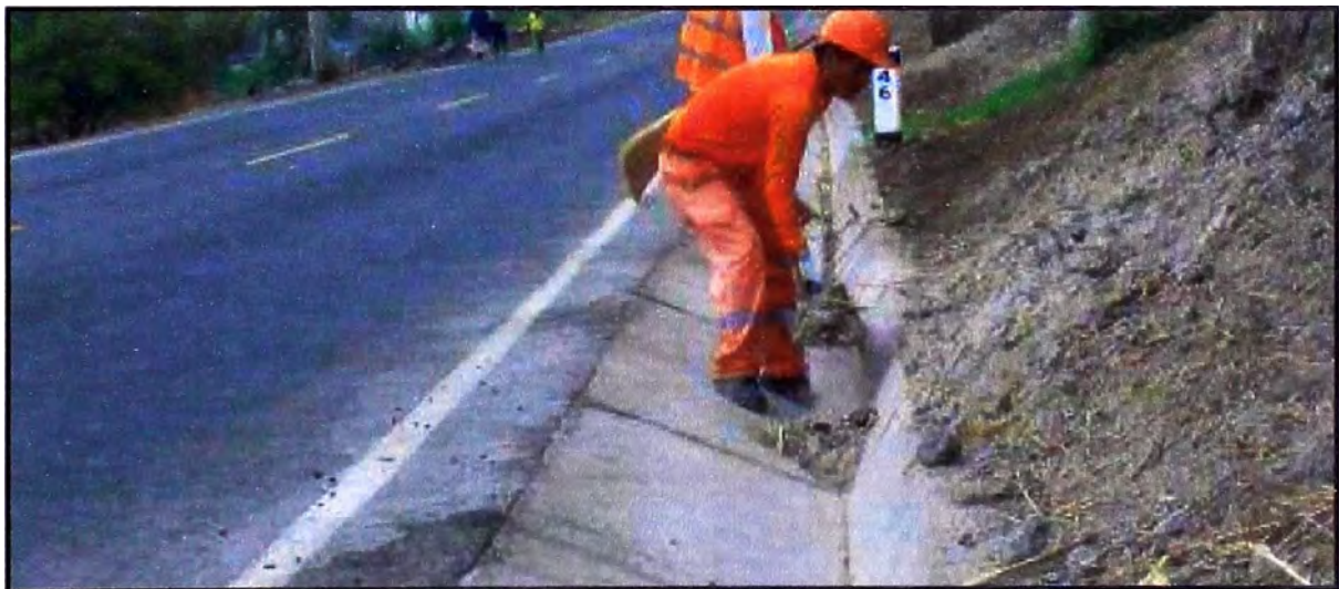
Figura N° 3.19 Limpieza de Cunetas
