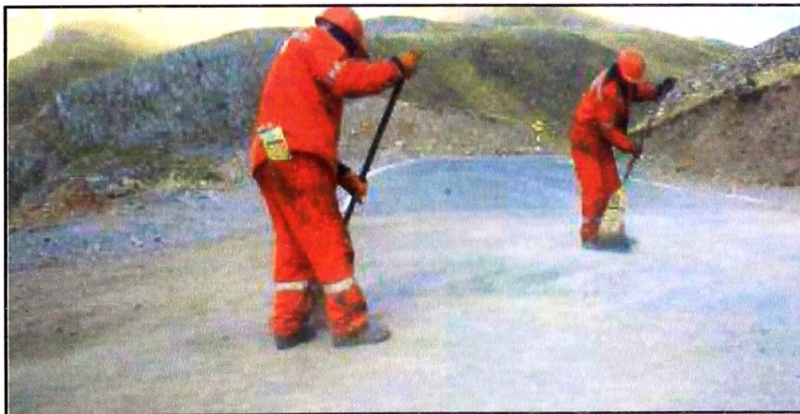
Figura N° 3.18 Limpieza de Calzada
