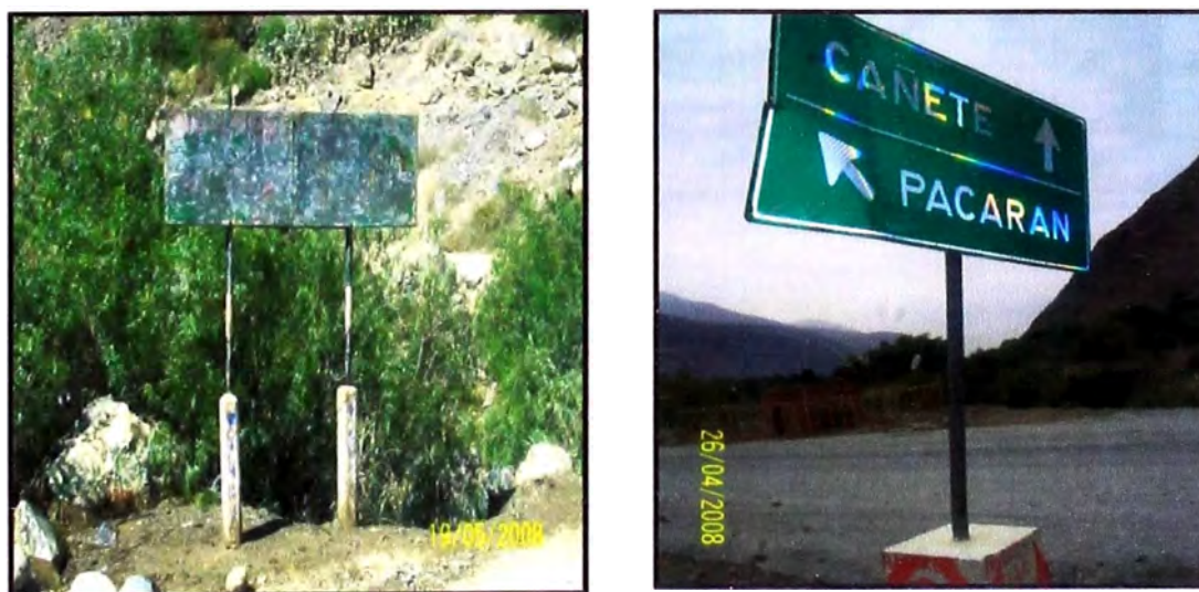
Figura N° 3.20 Limpieza de Señales Informativas
