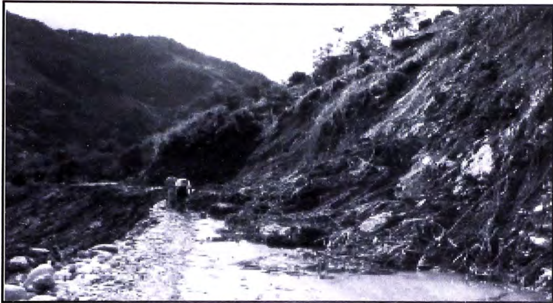
Figura N° 3.28 Caída de Huayco
