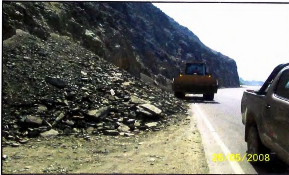
Figura N° 3.21 Remoción de Derrumbes Localizados
