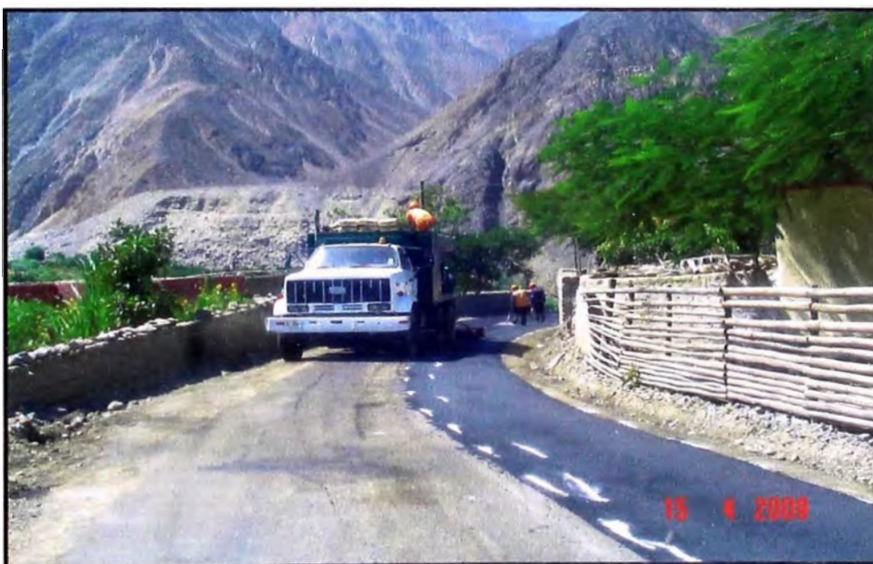
Figura N° 3.27 Sobre Capa de 1cm de Espesor
