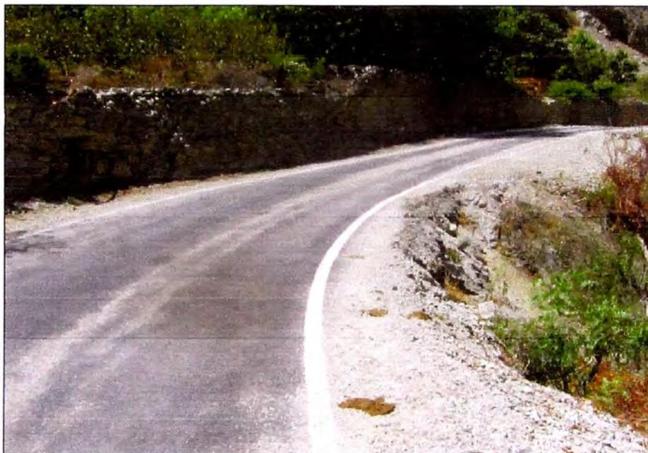
**Identificación de Punto Crítico:** Inestabilidad de talud en curva, se propone un muro de contención para estabilizar el talud.
