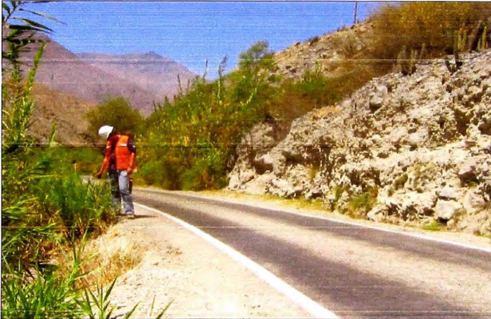
**Identificación de Punto Crítico:** Se observa talud inestable, se propone muro de contención para estabilizar el talud.
