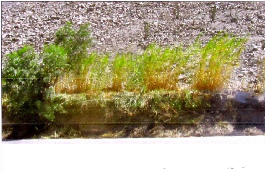
**Identificación de Punto Crítico:** Se observa acumulación de material rocoso en el talud de la carretera, se recomienda plantar árboles y vegetación en el pie del talud para mitigar deslizamientos del material a la carretera.
