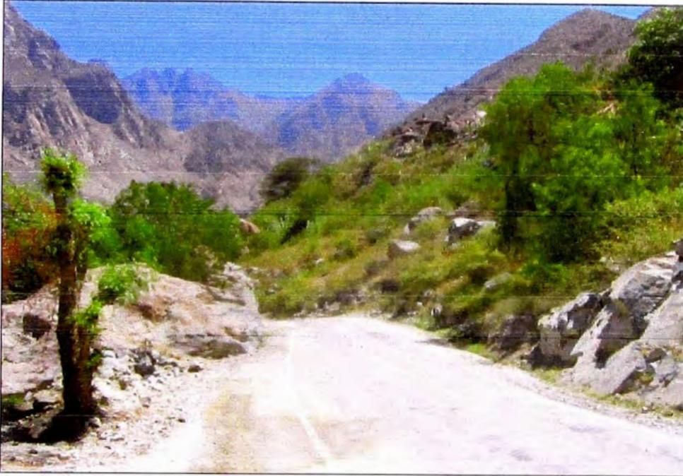
**Identificación de Punto Crítico:** Falta señalización por presencia de curva.
