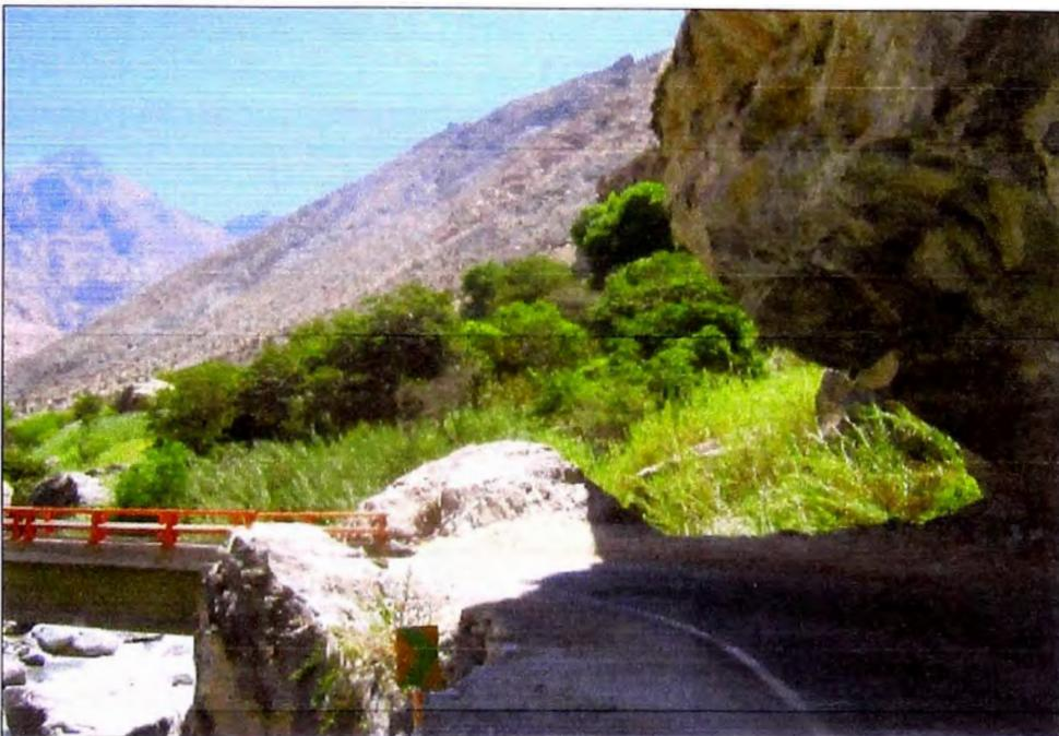
**Identificación de Punto Crítico:** Se observa que falta perfilar el talud de la roca existente para mejorar el tránsito de los buses y camiones en el ingreso al puente. Adicionalmente falta señalización que indique a los vehículos de mayor tamaño cuidado con talud vertical rocoso.
