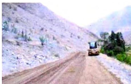
Figura N°1.02 Mejoramiento de la subrasante, colocando una capa de material en el Km 98 (Fuente: Provias Nacional)
