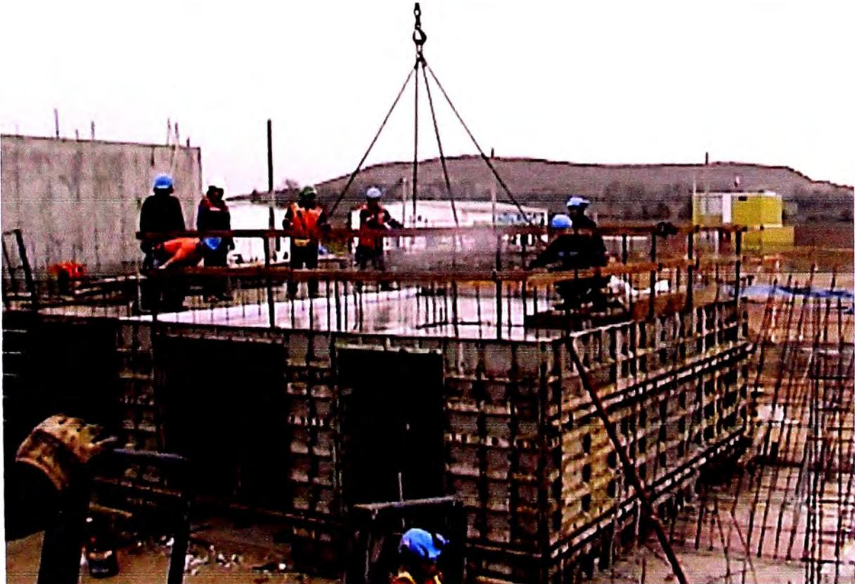
**Figura No 2.8 Construcción de viviendas con encofrado FORSA,
