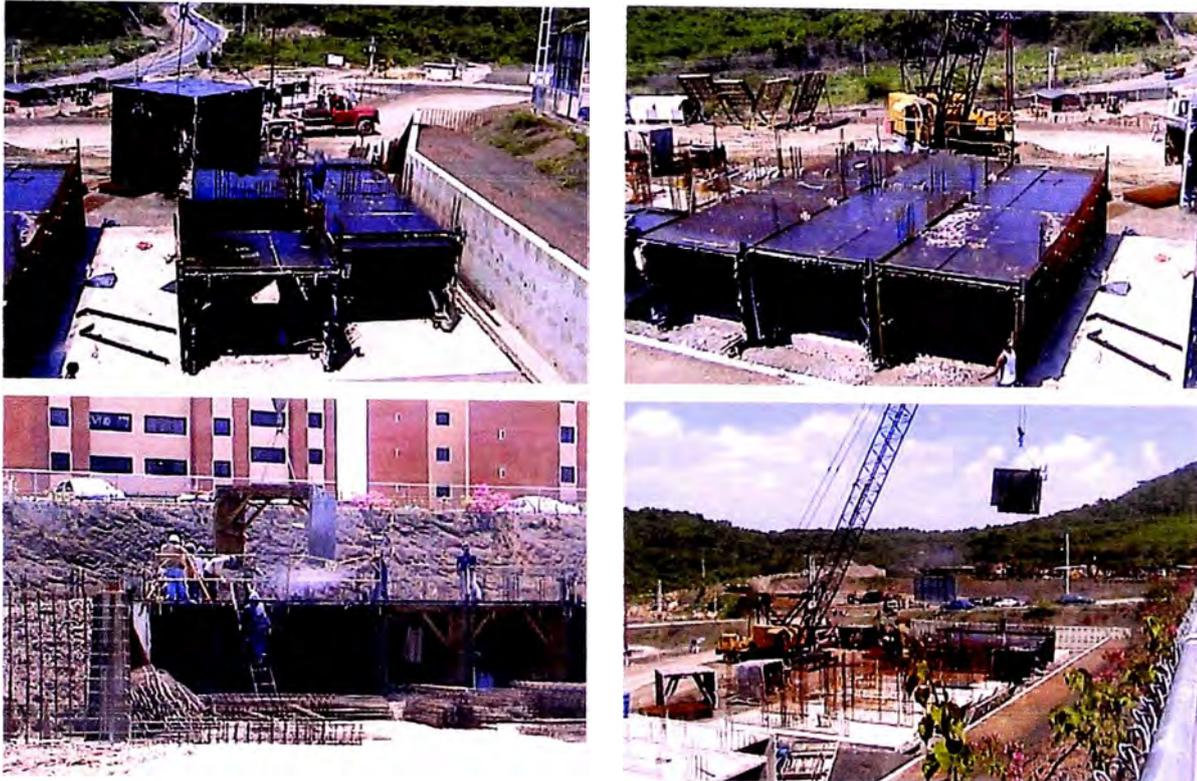
**Figura No 4.6 Colocación de los encofrados túnel para EMDL.
