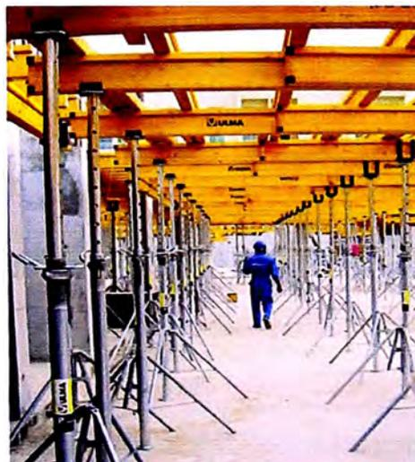
**Figura No 2.17 Encofrado ENKOFLEX, estabilizado con Puntales EP.**
