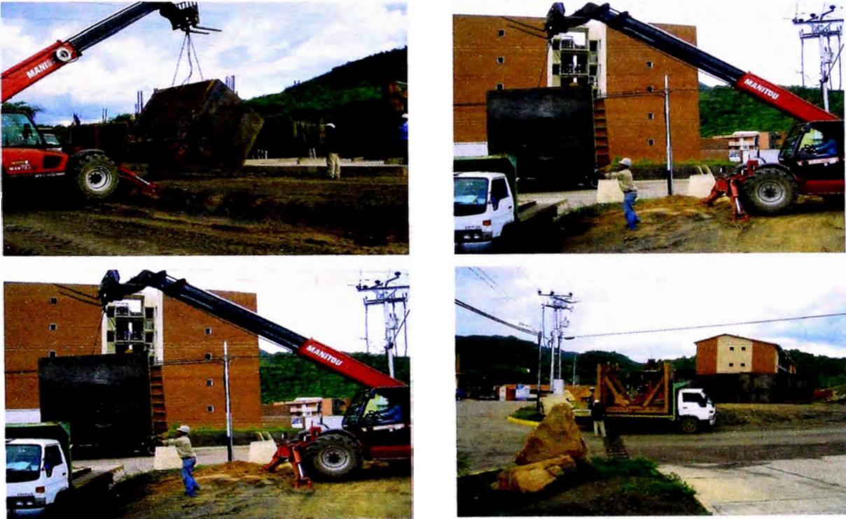
**Figura No 3.3 Montacargas y Camión 350, movilizan el encofrado túnel,
