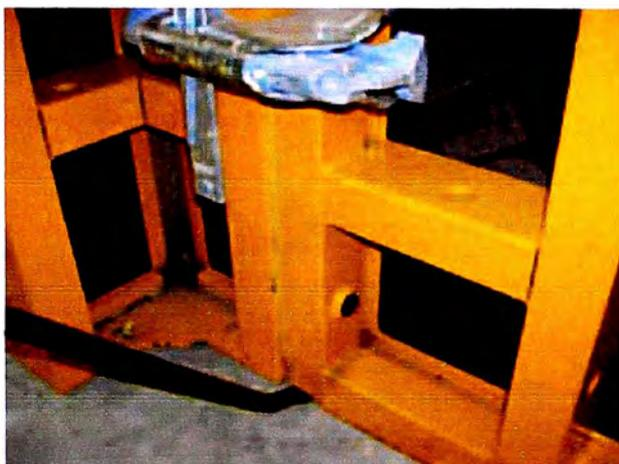
**Figura No 2.11 Unión de paneles mediante grapas ULMA, fuente tomada de Internet.**
