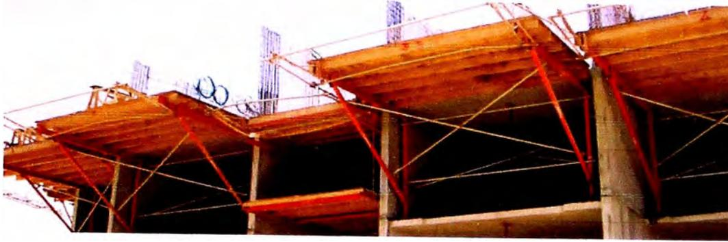
**Figura No 4.17 Plataforma del SET en EMDL,
