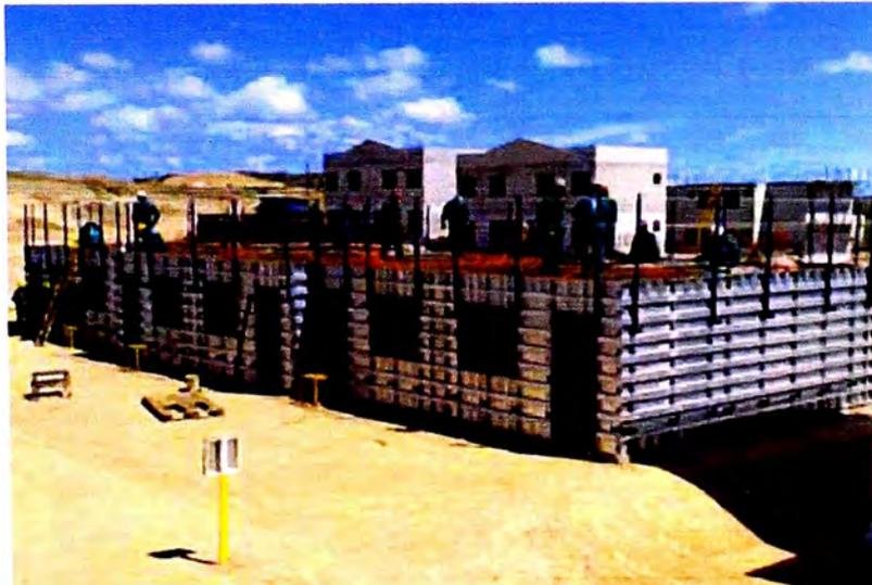
**Figura No 2.1 Vista Sistema Encofrado Monolítico FORSA,
