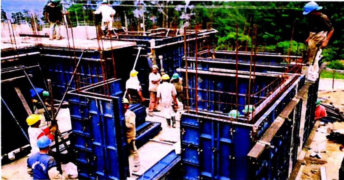
**Figura No 2.23 Vista encofrado de muros con paneles UNI-SPAN,
