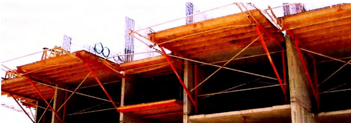
**Figura No 4.8 Plataformas de trabajo en SET para niveles superiores.**
