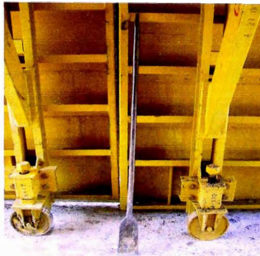
**Figura No 3.8 La barreta, herramienta importante en encofrado túnel,
