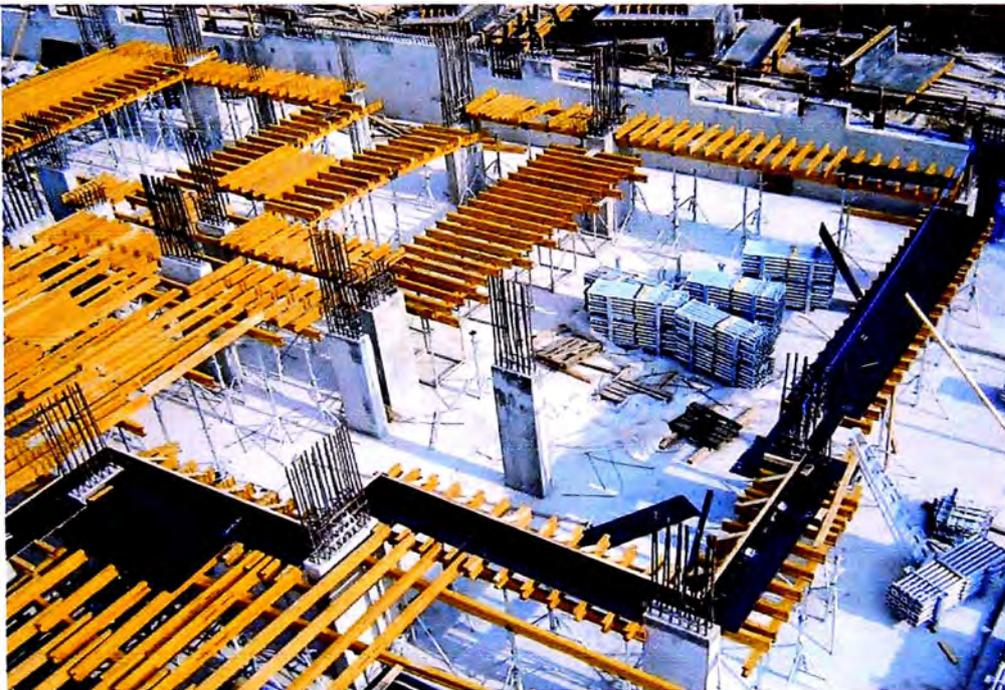
**Figura 2.19 Losa Aligerada, encofrado con ENKOFLEX- ULMA,**
