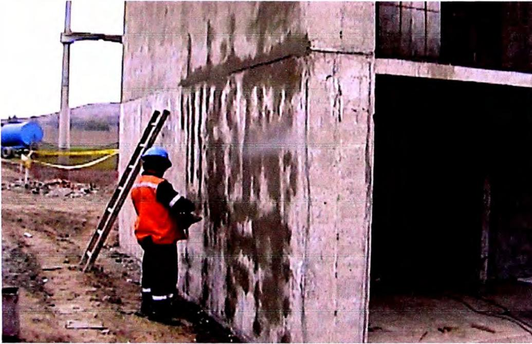
**Figura No 2.9 Solaqueado de muros en EMDL.
