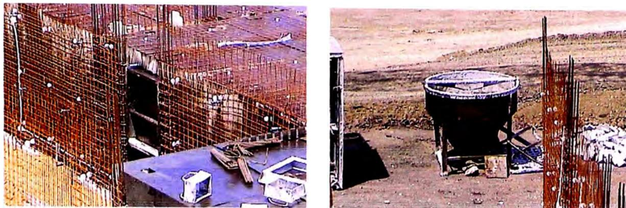
**Figura No 4.11 Marcos para vano de puerta, Tolva de vaciado de concreto.
