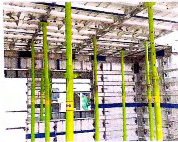
**Figura No 2.7 Formaletas FORSA para Apuntalamiento de Losas, fuente catálogo FORSA.**
