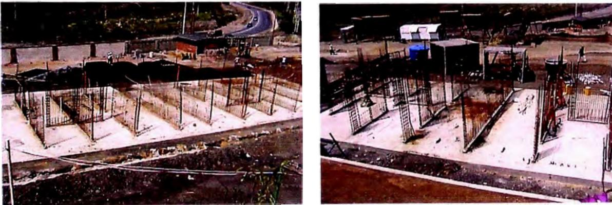
**Figura No 4.4 Losa de fundación con el acero de refuerzo en muros,
