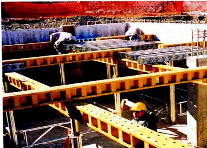
**Figura No 2.32 Encofrado con vigas primarias EFCO.**
