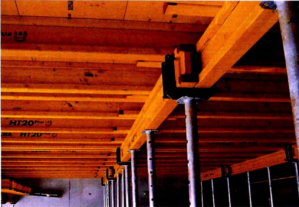
**Figura 2.18 Vigas VM y cabezales, encofrado ENKOFLEX-ULMA.**
