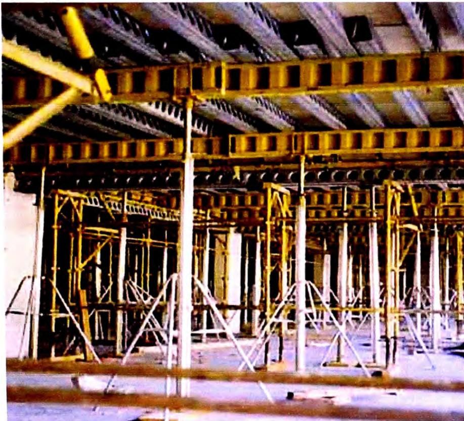
**Figura No 2.30 Encofrado con vigas primarias (EFCO LITE®).**
