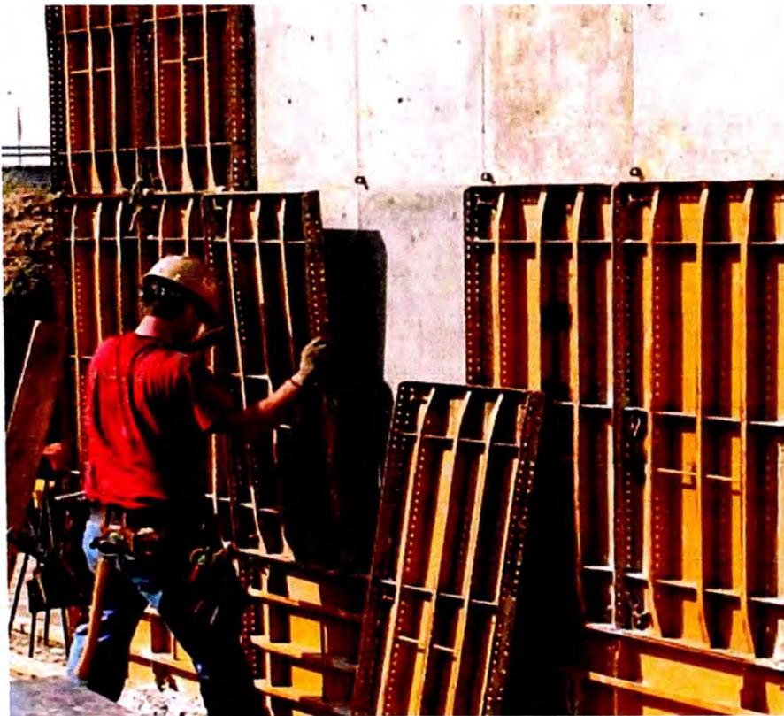
**Figura No 2.29 Encofrado de Muros con paneles (EFCO LITE®).**
