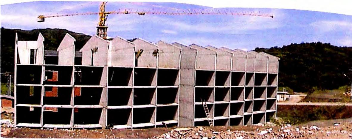
**Figura No 3.5 Grúa Torre también se usan en operación de montaje,
