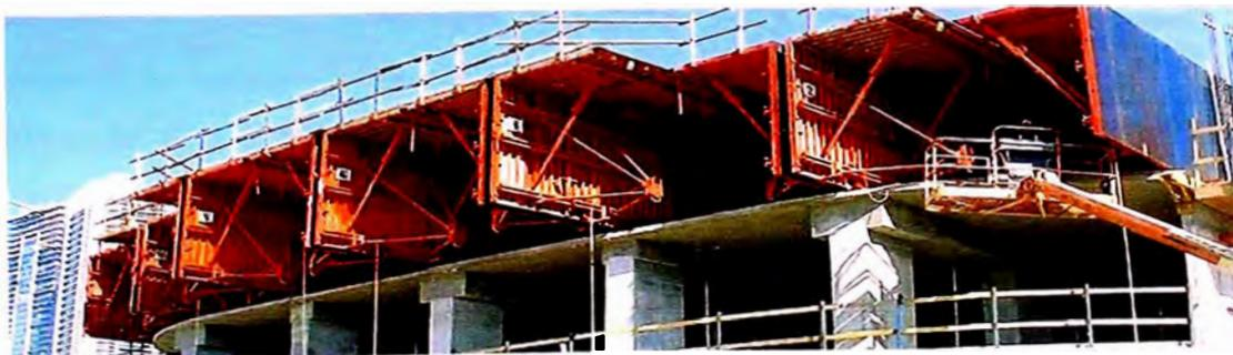
**Figura No 4.16 Encofrados medio Túnel en el segundo nivel,
