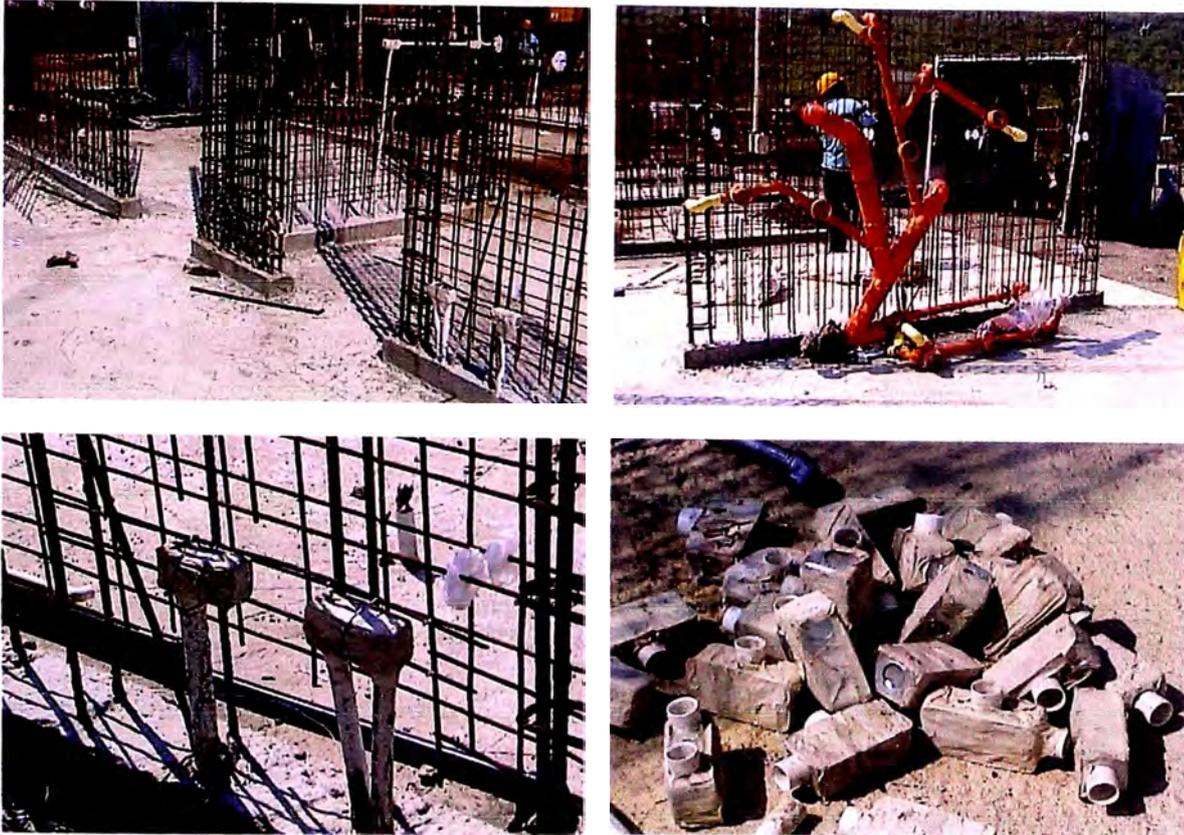
**Figura No 4.5 Instalaciones sanitarias y eléctricas en EMDL.
