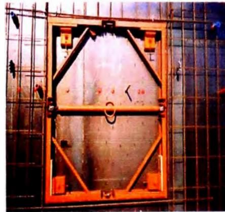
**Figura No 4.14 Marcos para vanos de puertas y ventanas en EMDL.**
