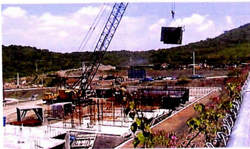
**Figura No 3.4 Grúa de Celosía en plena operación de montaje,
