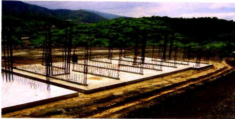
**Figura No 4.22 Losa de Fundación Sistema Encofrado Túnel.
