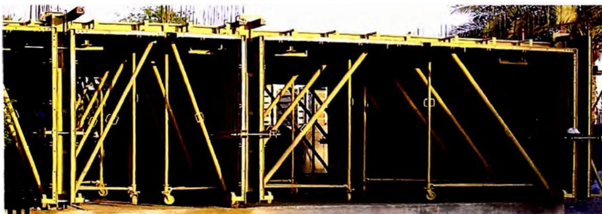
**Figura No 3.2 Encofrados del Sistema Medio Túnel tipo "L" invertida.
