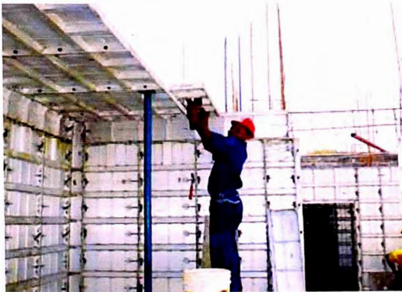
**Figura No 2.6 Formaletas FORSA para Losas de Entrepiso,
