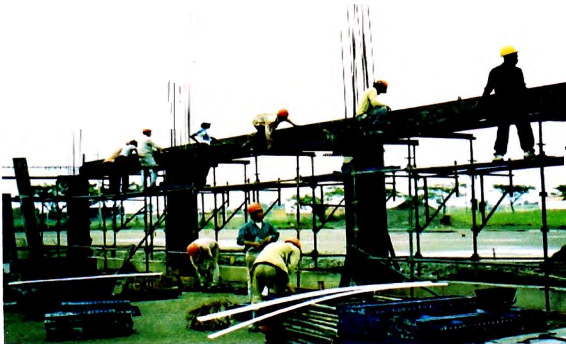
**Figura No 2.24 Vista del encofrado de vigas y losa con paneles UNI-SPAN.
