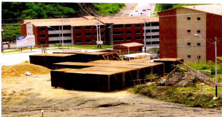
**Figura No 4.24 Sistema Encofrado Túnel.
