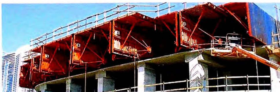
**Figura No 4.7 Encofrado medio túnel en niveles superiores,
