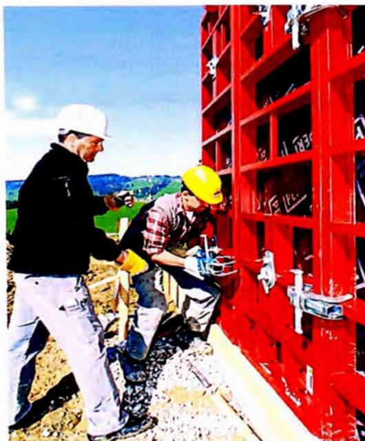
**Figura No 2.27 Dispositivo de fijación para Paneles MAXIMO-PERI.
