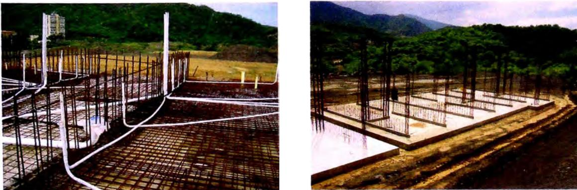
**Figura No 4.3 Losa de concreto para EMDL.
