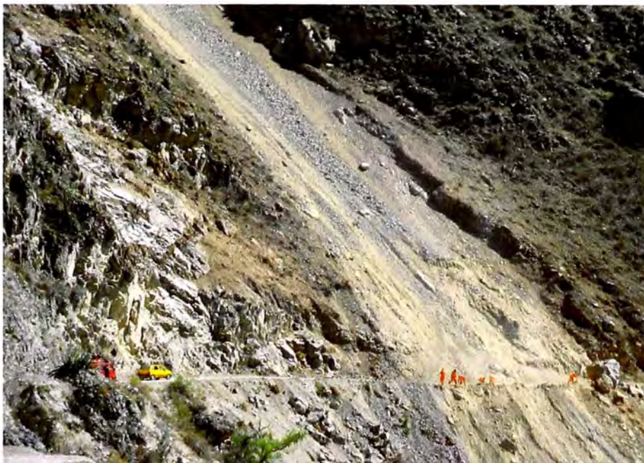
FOTO 04: Sector crítico, talud superior inestable en el Km 135+400 al Km 135+600
