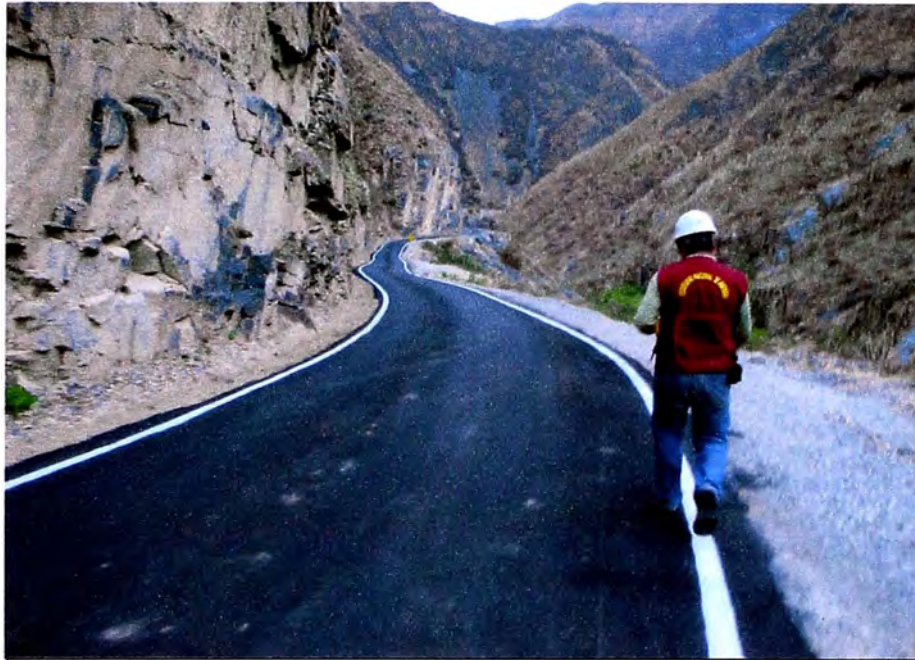
FOTO 03: Rehabilitación de superficie de protección en el Km 137+400 al Km 139+000
