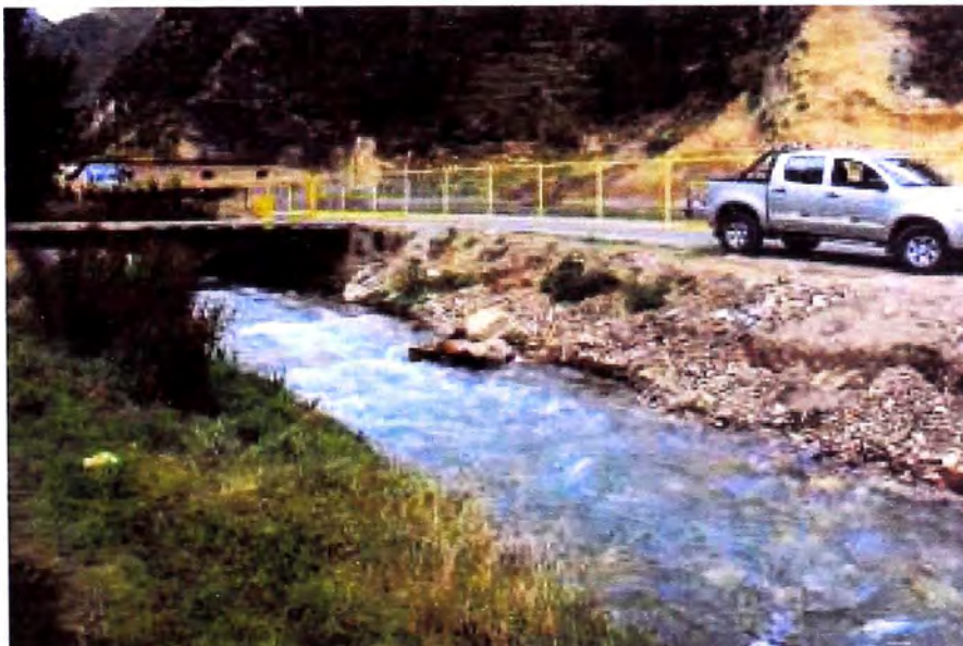
FIGURA N° 3.8 Arrojo de desmorte en el cauce del puente
