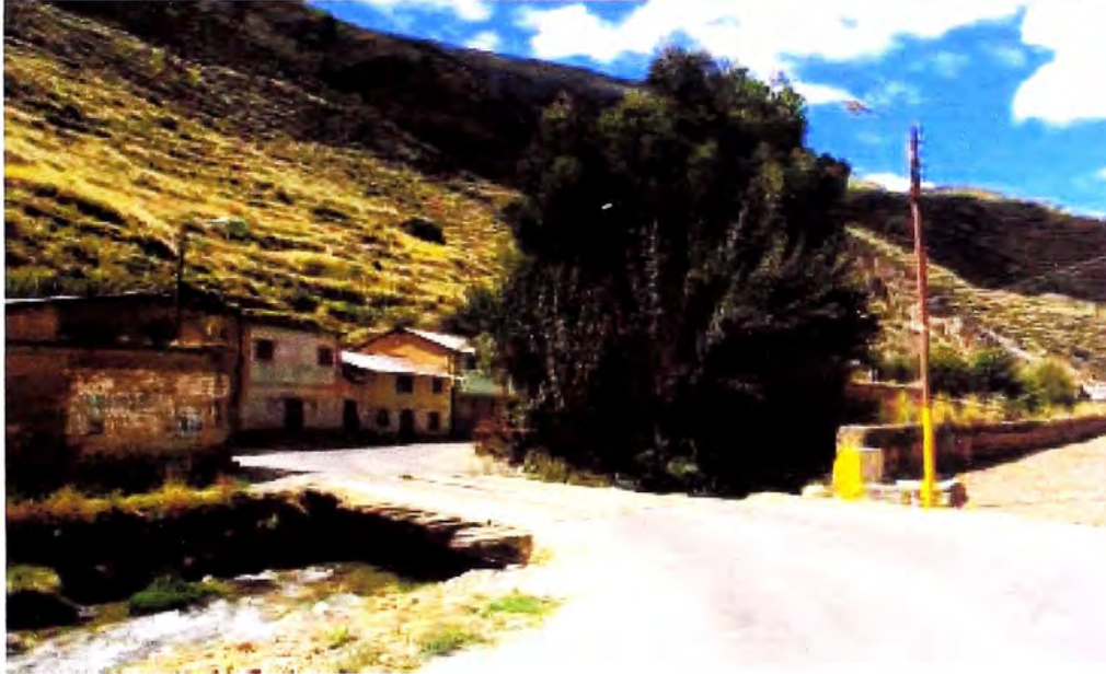
Foto 01 Vista de Elevación desde aguas abajo
