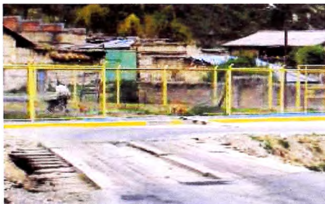
Foto 20 Vista panorámica de la plataforma acceso derecho
