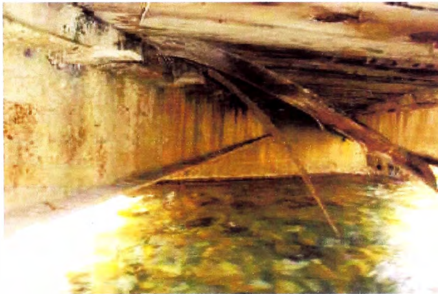
FIGURA N° 3.4 Vista de la superestructura (vigas y plataforma)
