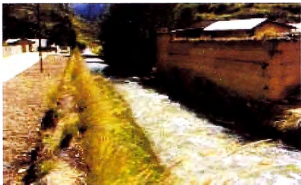
Foto 06 Vista de cauce aguas arriba
