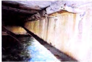
Viga Exterior (VM-02)
