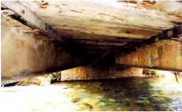
Foto 22 Vista panorámica del fondo desde Estribo izquierdo donde se observan la viga del lado izquierdo y central
