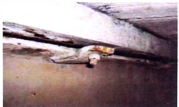
Foto 29 Vista de la viga izquierda tomada del estribo izquierdo donde se observa la union de la viga con la madera
