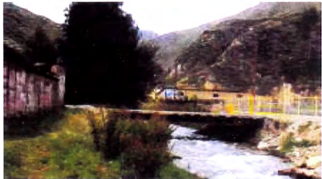
Foto 03 Vista de elevacion estribo izquierdo
