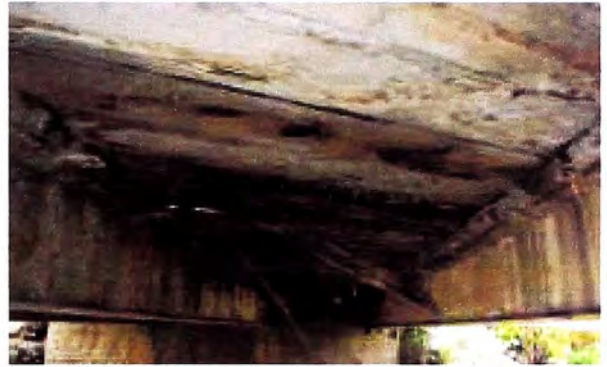
Foto 23 Vista panorámica del fondo desde Estribo izquierdo donde se observan la viga central y lado derecho
