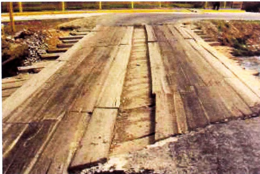
FIGURA N° 3.6 Vista de la superficie de rodamiento
