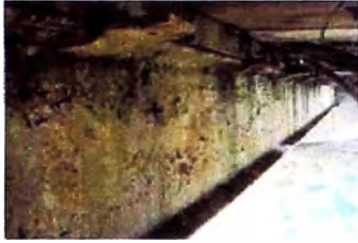
Viga Exterior (VM-02)
