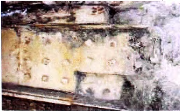
Foto 26 Vista del emplame en el estribo izquierdo de la viga central
