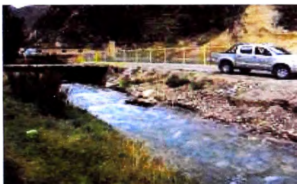
Foto 08 Vista de cauce aguas abajo donde se observa que se esta vertiendo desmonte en el cauce
