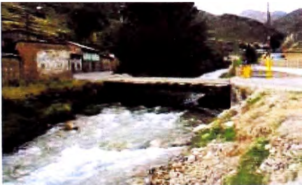
Foto 02 Vista de elevacion de los estribos.
