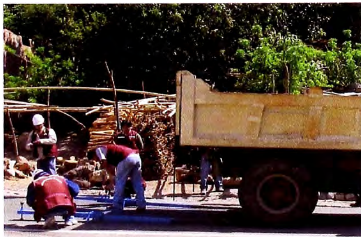
Figura N° 3.01 Ensayo con viga Benkelman en la carretera Cañete – Yauyos. Nov. 2010
