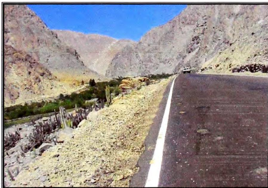
Fig. C.4 Deben seleccionarse tramos rectos para la medición de la rugosidad
