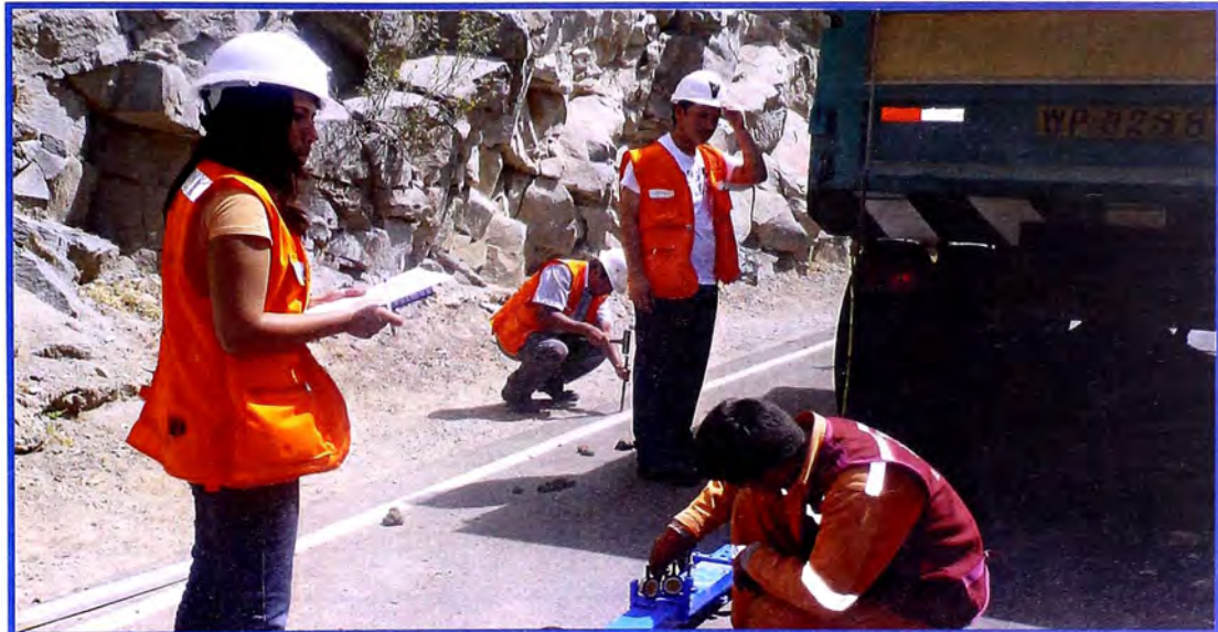
Foto 2: Posicionamiento del personal para realizar la primera medición con el Equipo Deflectómetro Viga Benkelman
