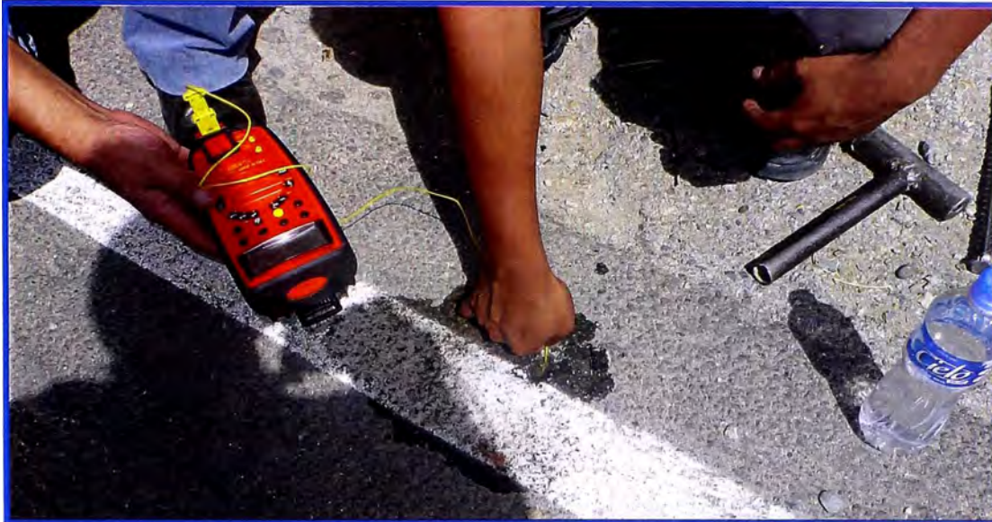
Foto 7: Medición de la temperatura de la carpeta de rodadura con termómetro digital.
