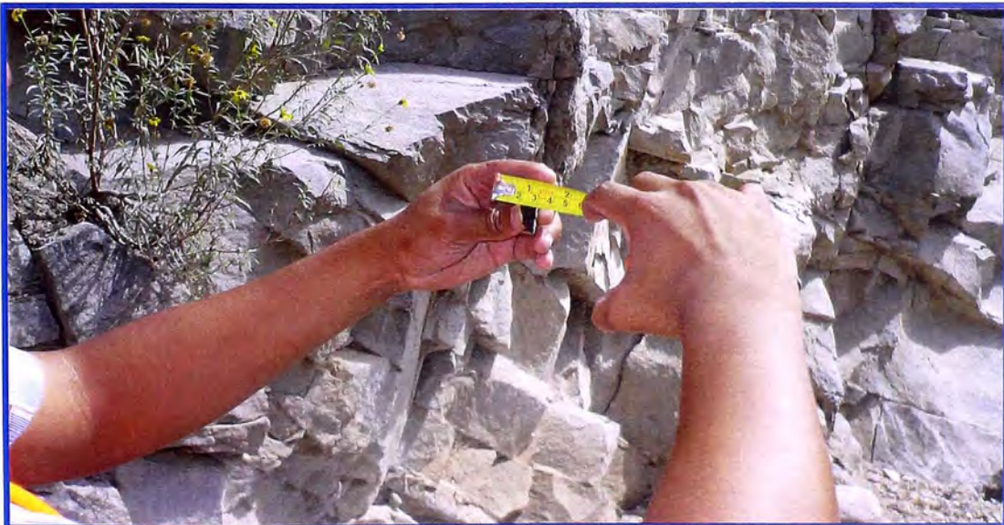
Foto 6: Proceso de medición del espesor de la carpeta de rodadura.
