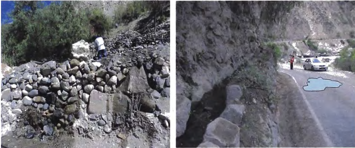
Figura 3.07: Fisuras y desprendimiento del tratamiento superficial
