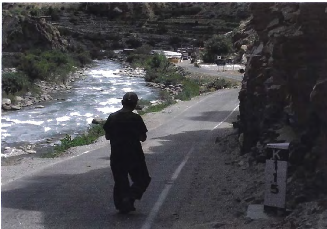
Fotografía mostrando el ancho de calzada de 2.5 m.- Km 115+00
