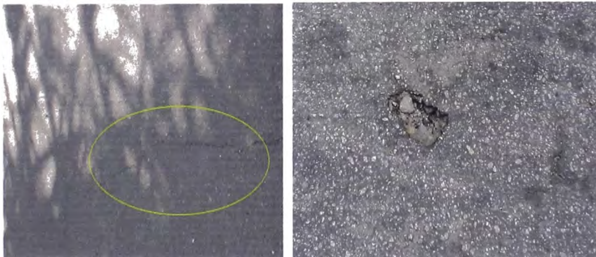
Figura 3.07: Fisuras y desprendimiento del tratamiento superficial
