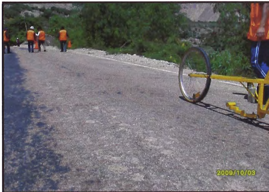
Foto N°4.2. VISTA DEL TRAMO EN ESTUDIO Km. 80+500 – 80+100.
