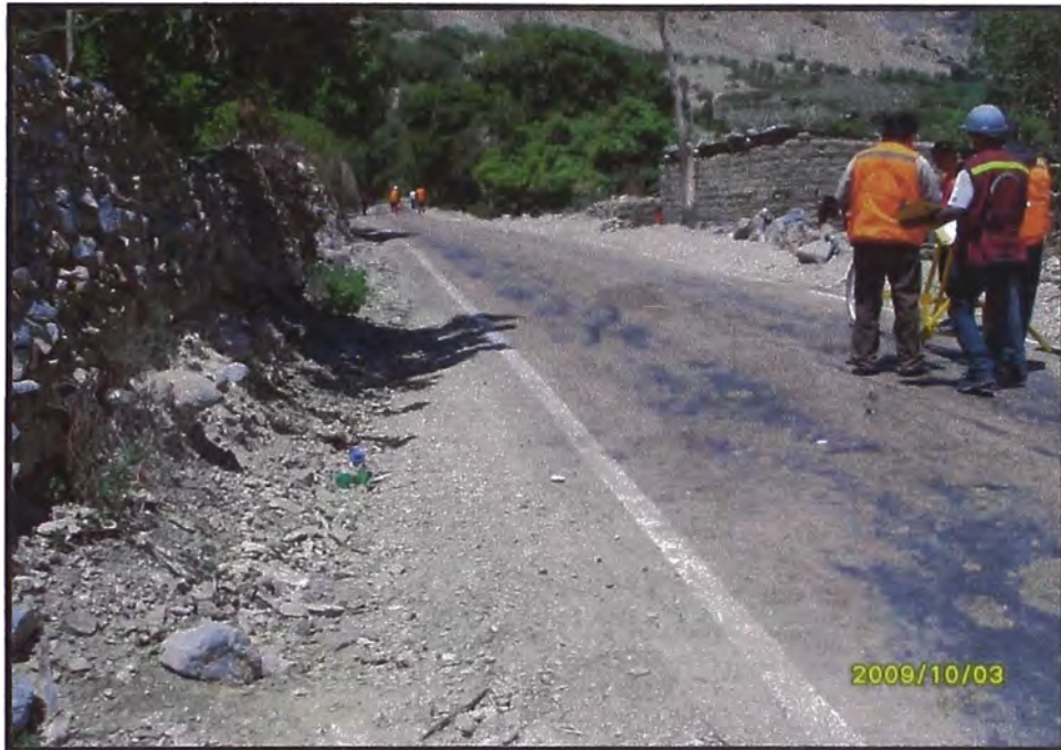
Foto N°4.3. VISTA DEL TRAMO EN ESTUDIO Km. 80+500 – 80+100.
