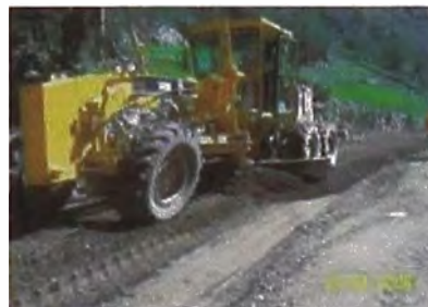
Reconformación del afirmado con emulsión.
