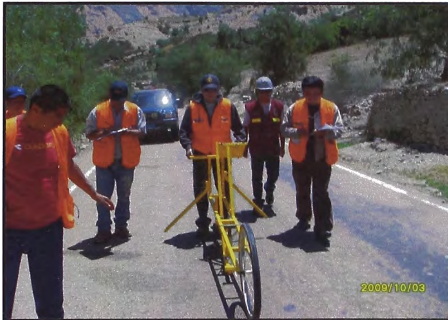
Foto N°4.1. TOMA DE DATOS CON MERLIN Km. 80+500 – 80+100.
