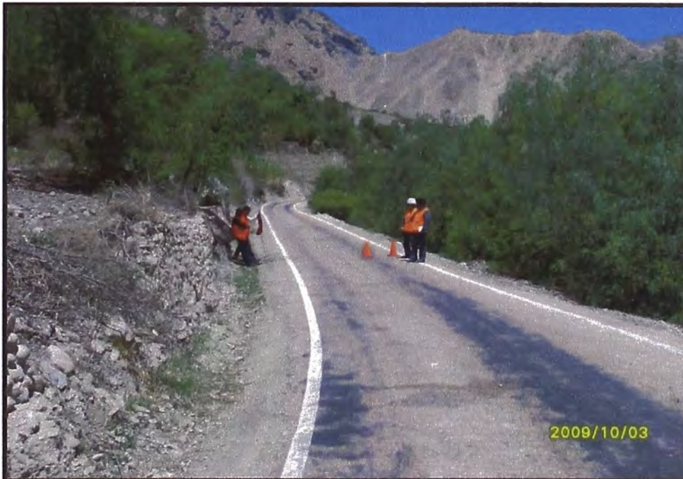
Foto N°4.6. VISTA DEL TRAMO EN ESTUDIO Km. 80+500 – 80+100.
