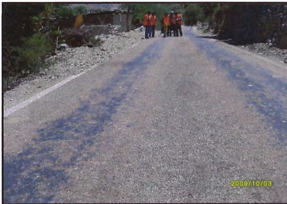
Foto N°4.4. VISTA DEL TRAMO EN ESTUDIO Km. 80+500 – 80+100.
