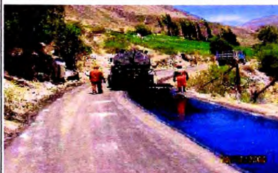
Fotografía N° 1.11: Aplicación de RC 250 para riego de liga para el monocapa.
