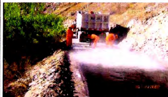
Fotografía N° 1.12: Colocación del T.S. monocapa con esparcidora.
