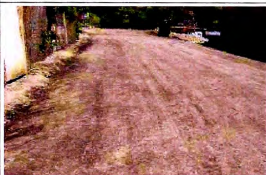
Fotografía N° 1.09: Superficie de Plataforma luego de ser compactada.
