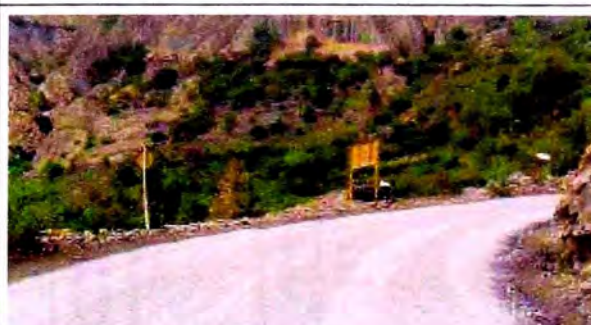
Fotografía N° 1.14: Tramo con monocapa terminado.
