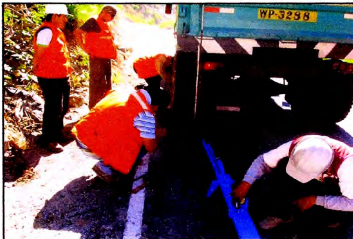
Fotografía N° 4.02: Colocación de Viga Benkelman entre las llantas posteriores
