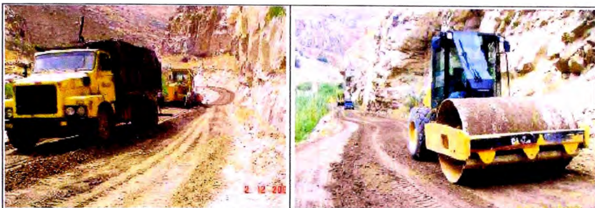
Fotografía N° 1.08: Conformación de afirmado estabilizado con riego de emulsión.
