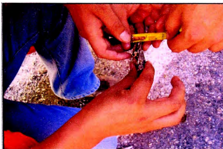
Fotografía N° 4.03: Medición del espesor del pavimento
