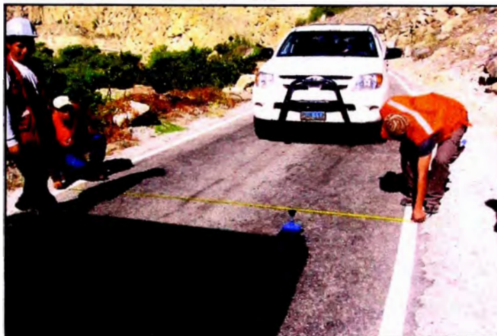
Fotografía N° 4.04: Medición ancho de calzada
