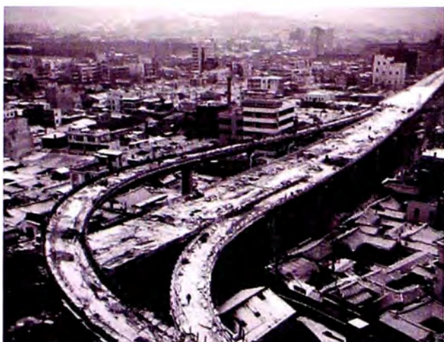
Figura 16. Vista de la autopista elevada sobre el arroyo Cheonggyecheon Fuente: Dr. In Keun Lee. LH Corporation, 2015.
