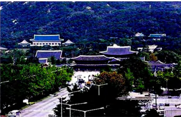
Figuras 9 y 10. Vistas de la sede del Gobierno Colonial y su posterior demolición
