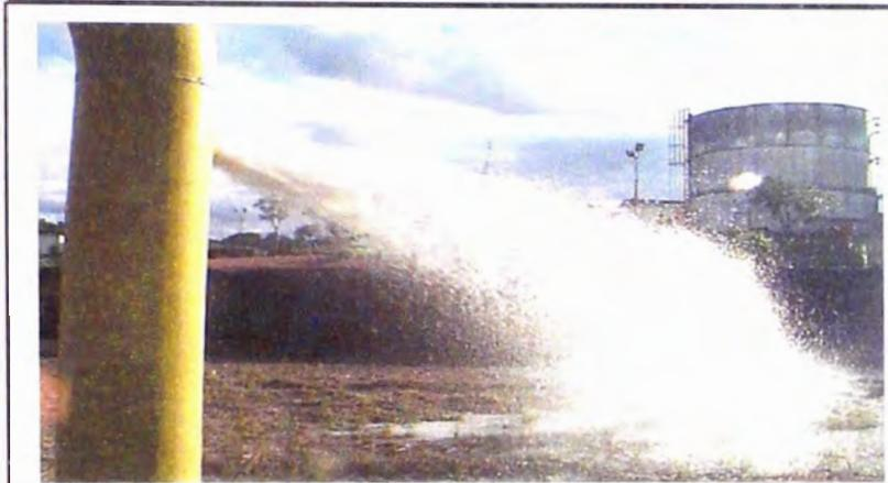
**Foto # 2.-Vista de la salida de espuma para la prueba refractométrica**
