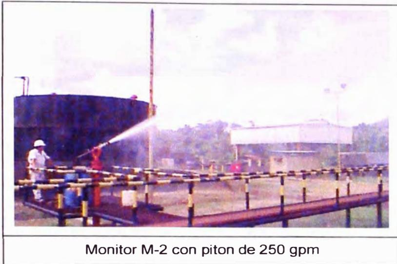
Monitor M-2 con piton de 250 gpm
