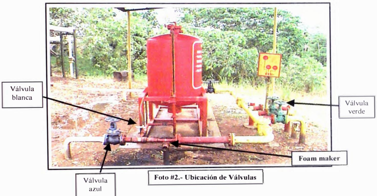
En el supuesto de que el concentrado que esta en los tanques se termine, es posible abrir la segunda válvula blanca de la línea auxiliar para succionar concentrado de espuma directamente desde un cilindro de 55 galones.
