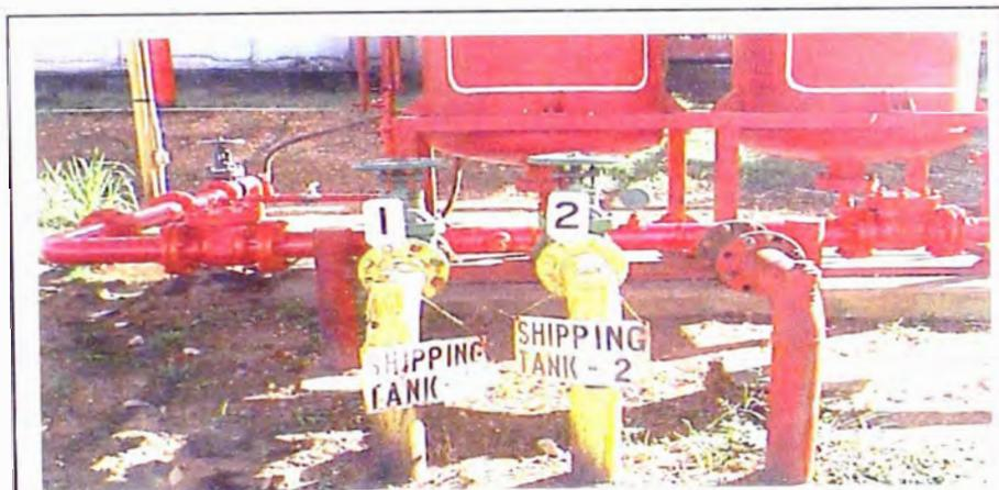
Foto#1 .-Manifolds con identificación de cada tanque.
