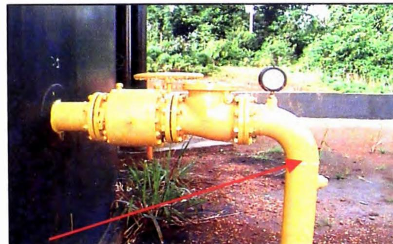
**Foto # 3.-Salida de la espuma para la toma de muestra.**
