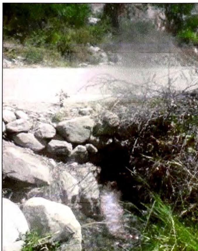
Fotografía N° 4: Pase de agua, Km.93+439, el canal presenta gran caudal con colmatación y alta velocidad
