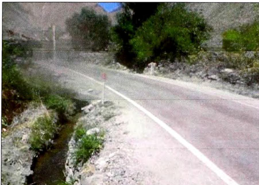
Fotografía N° 3: Pase de agua, Km.93+195, el canal presenta poco caudal con colmatación y baja velocidad
