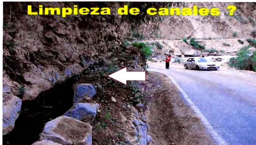
Figura N° 2.05 Canal paralelo a la vía
