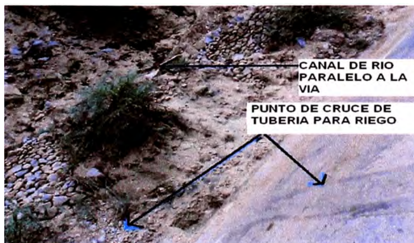
Figura N° 2.05 Cruce de tubería para riego
