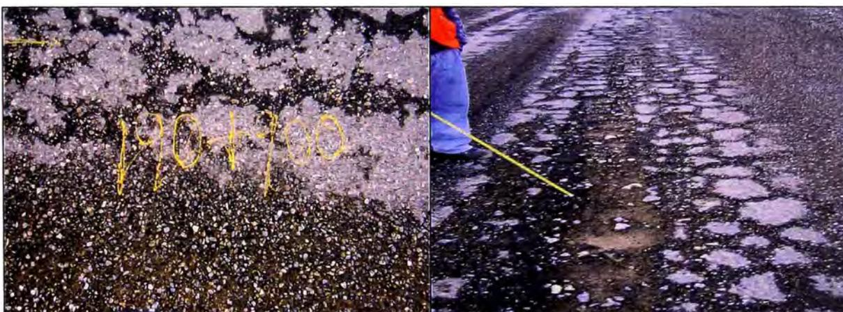
Figura 3.6: Superficie de rodadura con falla tipo piel de cocodrilo, baches y peladura (Km. 190+700)
