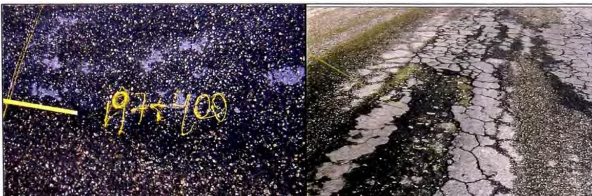
Figura 3.13: Superficie de rodadura con falla tipo piel de cocodrilo,
