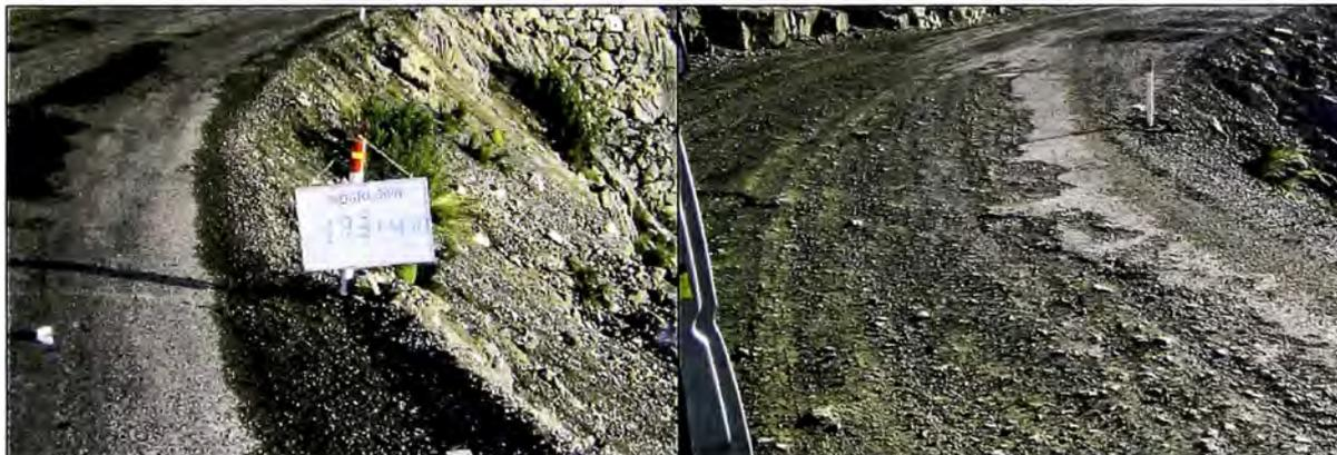
Figura 3.8: Superficie de rodadura totalmente desintegrada
