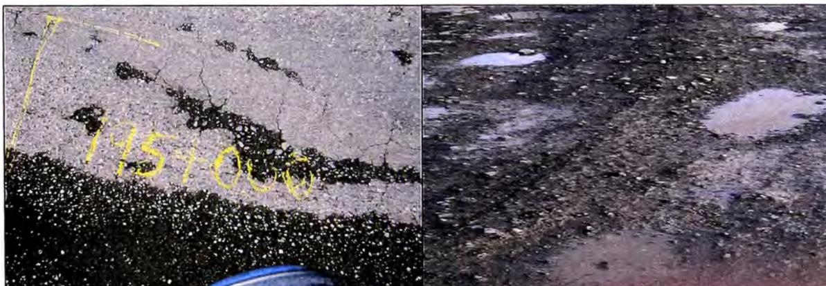
Figura 3.9: Superficie de rodadura totalmente desintegrada
