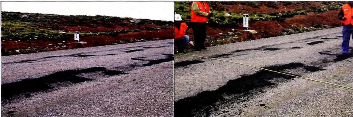
Figura 3.15: Superficie de rodadura con peladura (Km. 205+000)
