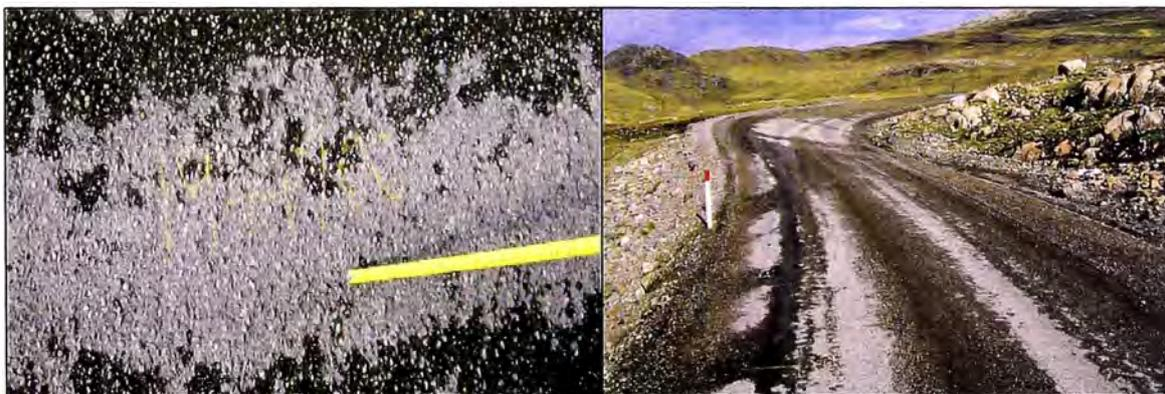
Figura 3.12: Superficie de rodadura con desintegración de bordes y
