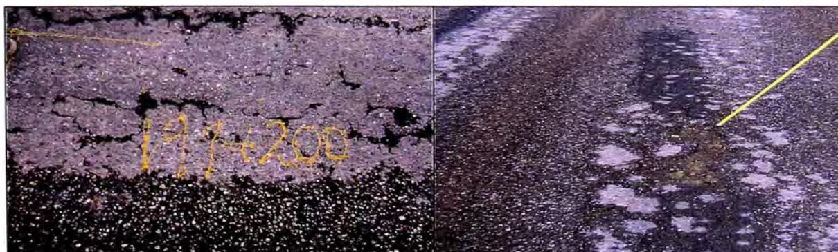
Figura 3.7: Superficie de rodadura con falla tipo piel de cocodrilo, baches y peladura (Km. 191+200)
