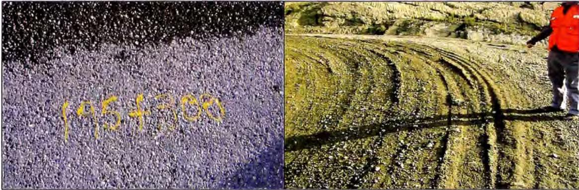
Figura 3.11: Superficie de rodadura totalmente desintegrada
