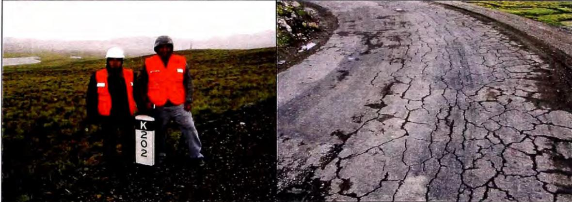
Figura 3.14: Superficie de rodadura con falla longitudinal y peladura
