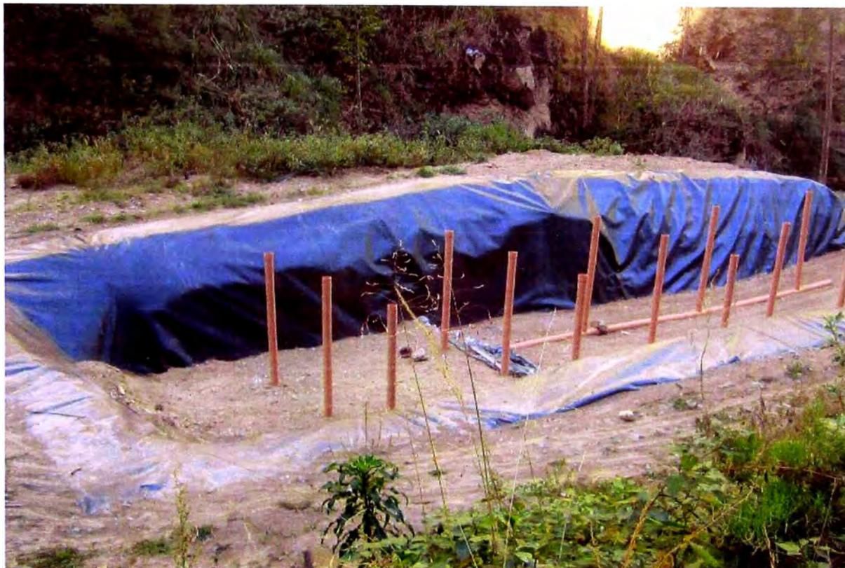
Foto 21: Relleno Sanitario Construido en Alis. Se observan deficiencias en el proceso constructivo (Inadecuada preparación del terreno de fundación previo a la colocación de la geomembrana).
