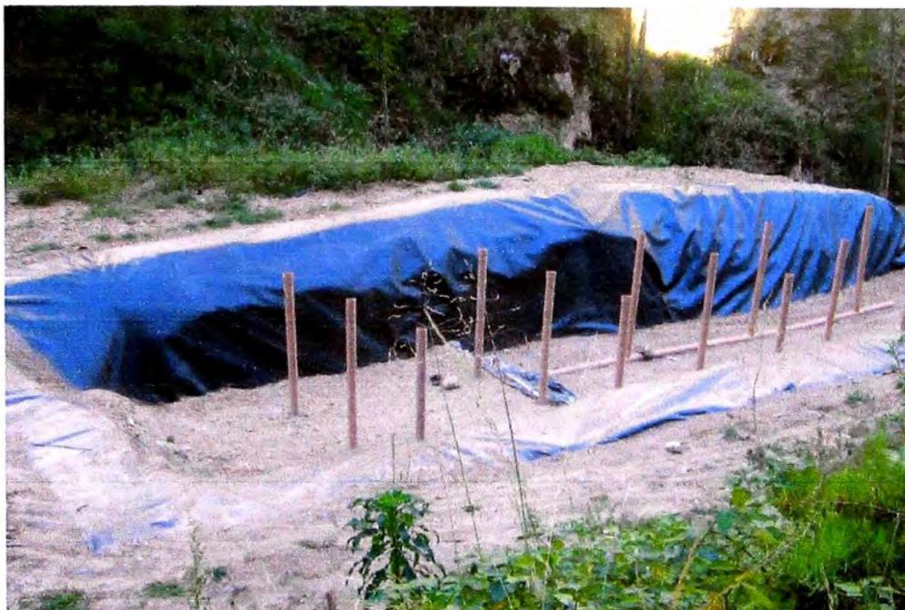
IMAGEN N° 3.02: RELLENO SANITARIO EN ALIS, SE OBSERVA QUE LA GEOMEMBRANA ESTA INSTALADA SOBRE UNA SUPERFICIE MAL PREPARADA.
